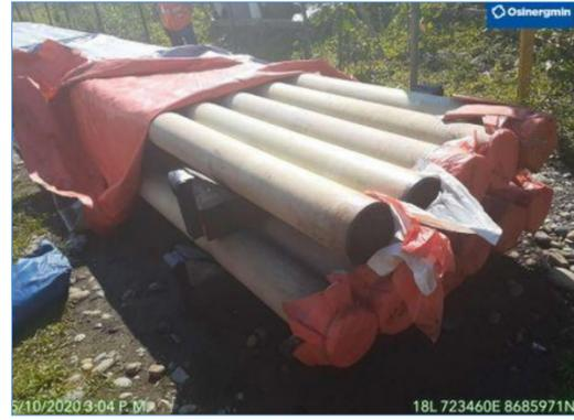
**Área 1 – Acopio KP 06.** Tubería acopiada. Vista de la pila de tubos de 8” de la pila N° 3, se aprecia que cuenta con cobertura de lona y los extremos tapados.
