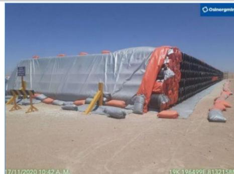
**Área 5 – Acopio KP 777:** Vista de la Pila 05 de tubería de 24", la cual cuenta con la cobertura de flexiona, la cual está en buen estado.
