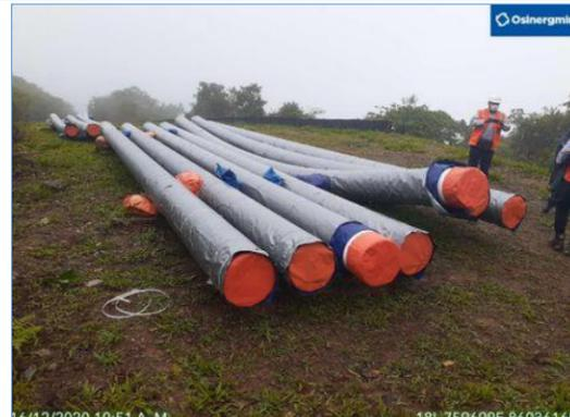
**Área 3 – Ramal Quillabamba KP 2+200.** Vista de tubería desfilada de 14”, se aprecia que cuentan con lonas aseguradas con zunchos en los extremos y están cubiertas con lona.
