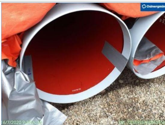
**ÁREA 1 – KP 4:** Vista de la parte interna de la tubería de 32" de la pila N° 2, se aprecia la limpieza interna, la cual está en buen estado.
