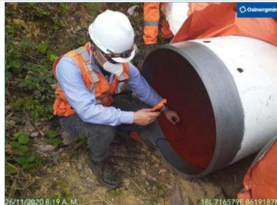
**Área 2 – DDV KP 86+230.** Vista donde se aprecia al personal de la empresa MINDTSER SAC (contratada por Osinerghmin) realizando la medición del recubrimiento interno de la tubería de 32”.
