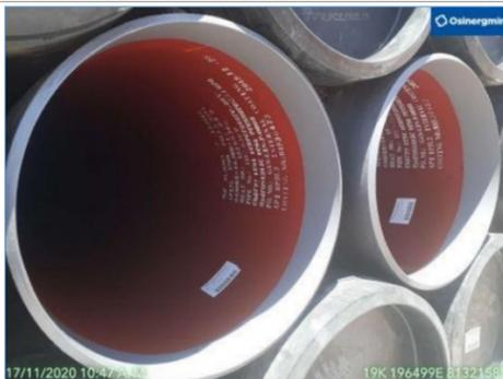
**Área 5 – Acopio KP 777:** Vista de la parte interna de la tubería de 24", se aprecia la limpieza interna y la pintura epóxica de protección aplicada en los extremos, los cuales están en buen estado.
