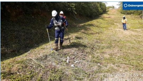
**Área 2 – DDV KP 90+800:** Vista de la inspección del CIS (Close Interval Survey) llevado a cabo por el Administrador, para verificar el nivel de protección del sistema de protección catódica.
