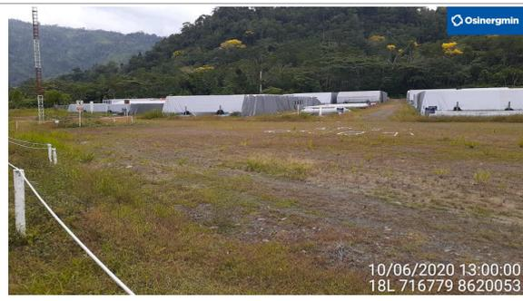
**ÁREA 2 – KP 85:** Vista de las pilas de tubería, cubiertas con lona para protección contra los rayos UV.
