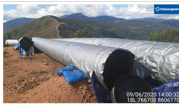
**ÁREA 3 – KP 152+300:** Verificación de la tubería desplegada en el DDV, protegida contra los rayos UV.
