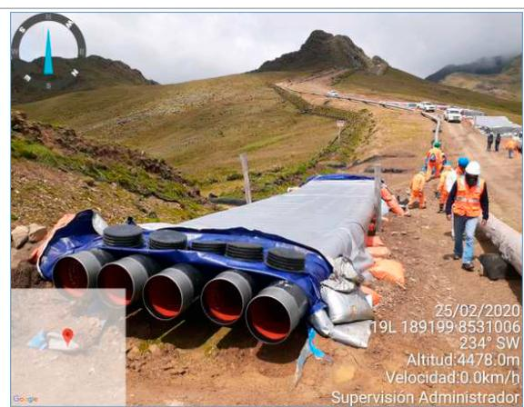
**ÁREA 4 – Ramal Anta Cusco KP 007+080:** Tubería desplegada sobre el DDV, se encuentre con tapas y cubierta con lonas para la protección contra los rayos UV.
