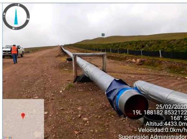
**ÁREA 4 – Ramal Anta Cusco KP 009+300:** Tubería soldada desfilada, la cual se encuentra con tapas y cubierta con lonas para la protección contra los rayos UV.
