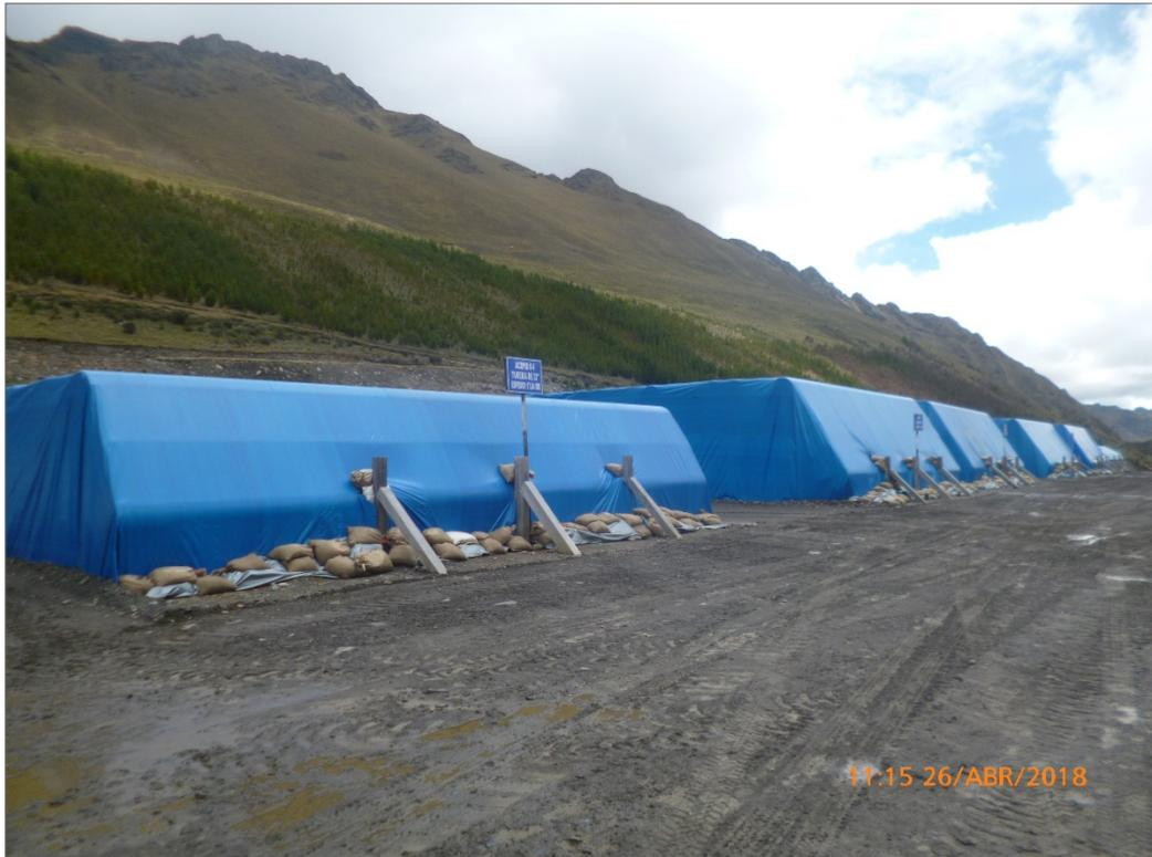
Vista del acopio Acchahuata. Se aprecia que las pilas de la tubería están cubiertas con lona.
