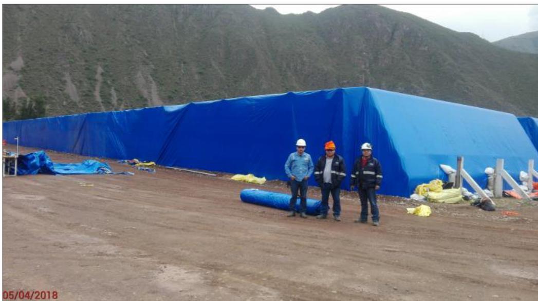
Acopio de Palma Real. Nótese la tubería con mantos protectores.
