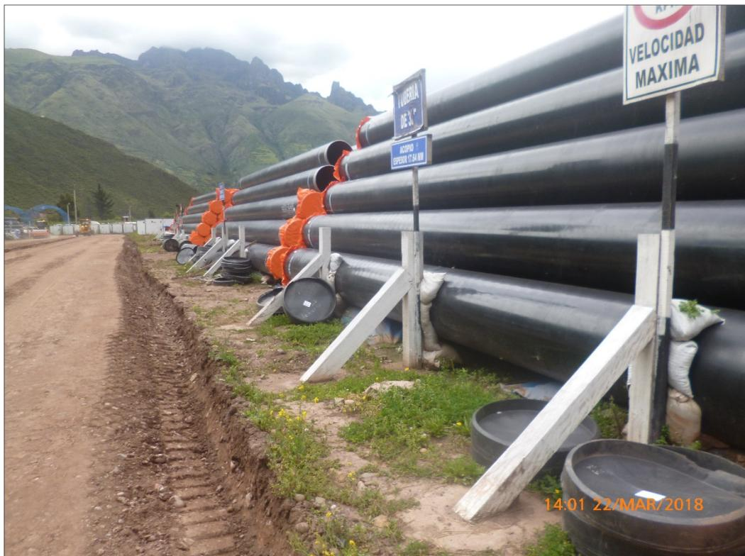
Acopio Calca: Tubería de 32"
