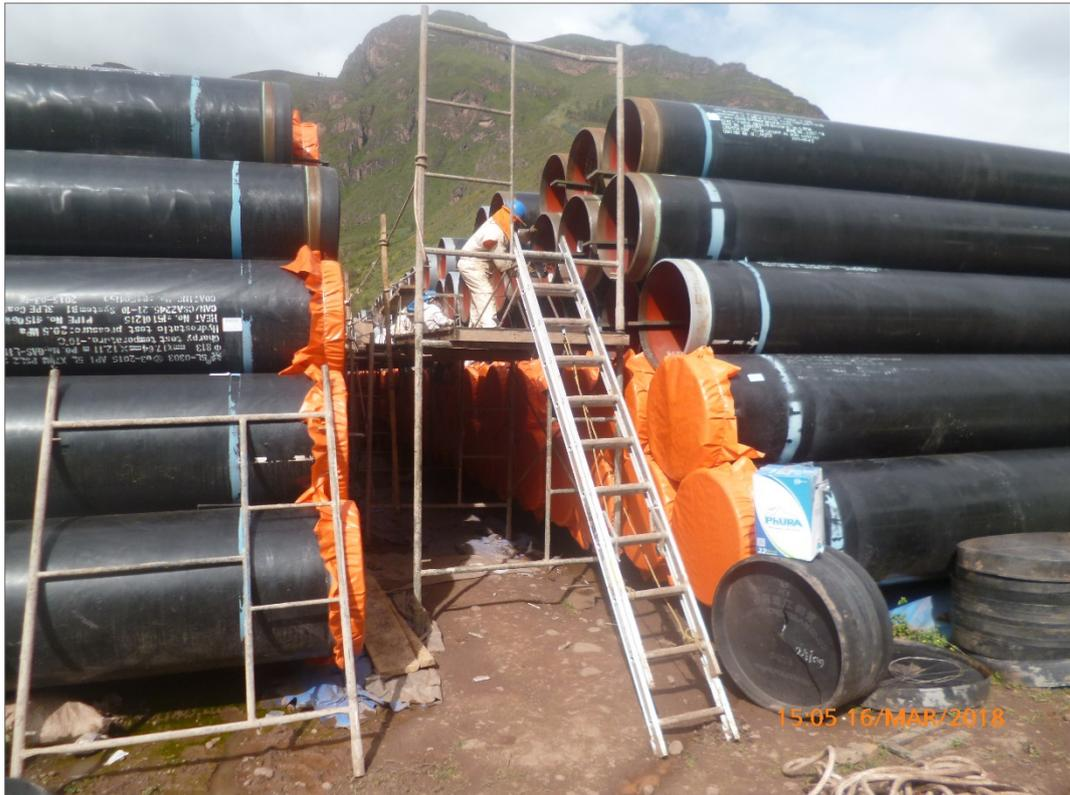
Acopio de Calca: Actividades de limpieza interna de tubería.
