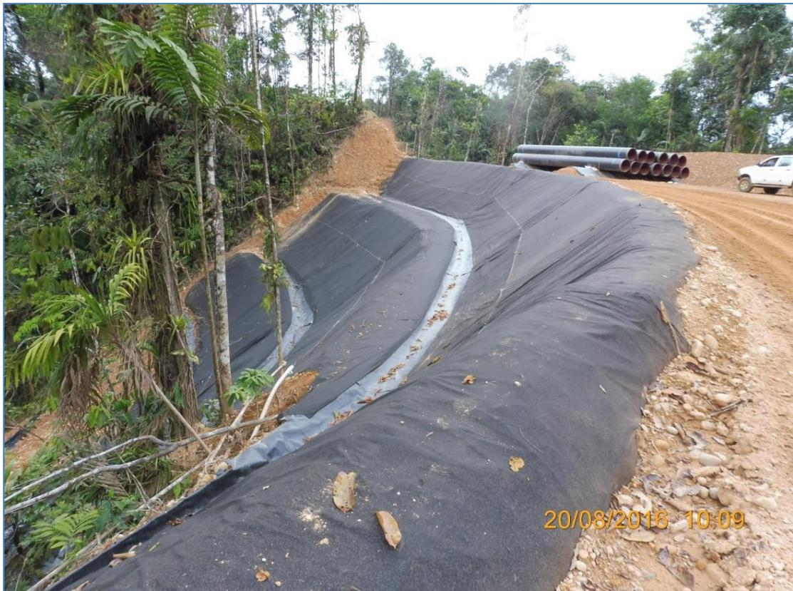
Tramo B – Segmento 1, KP 25+450. Talud protegido con geotextil.
