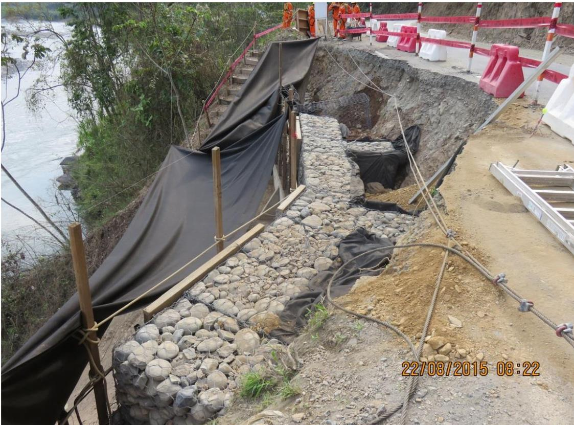
Plataforma de la vía asfaltada Puente Chahuares – Kiteni. Detalle de la construcción de muro de contención con gaviones
