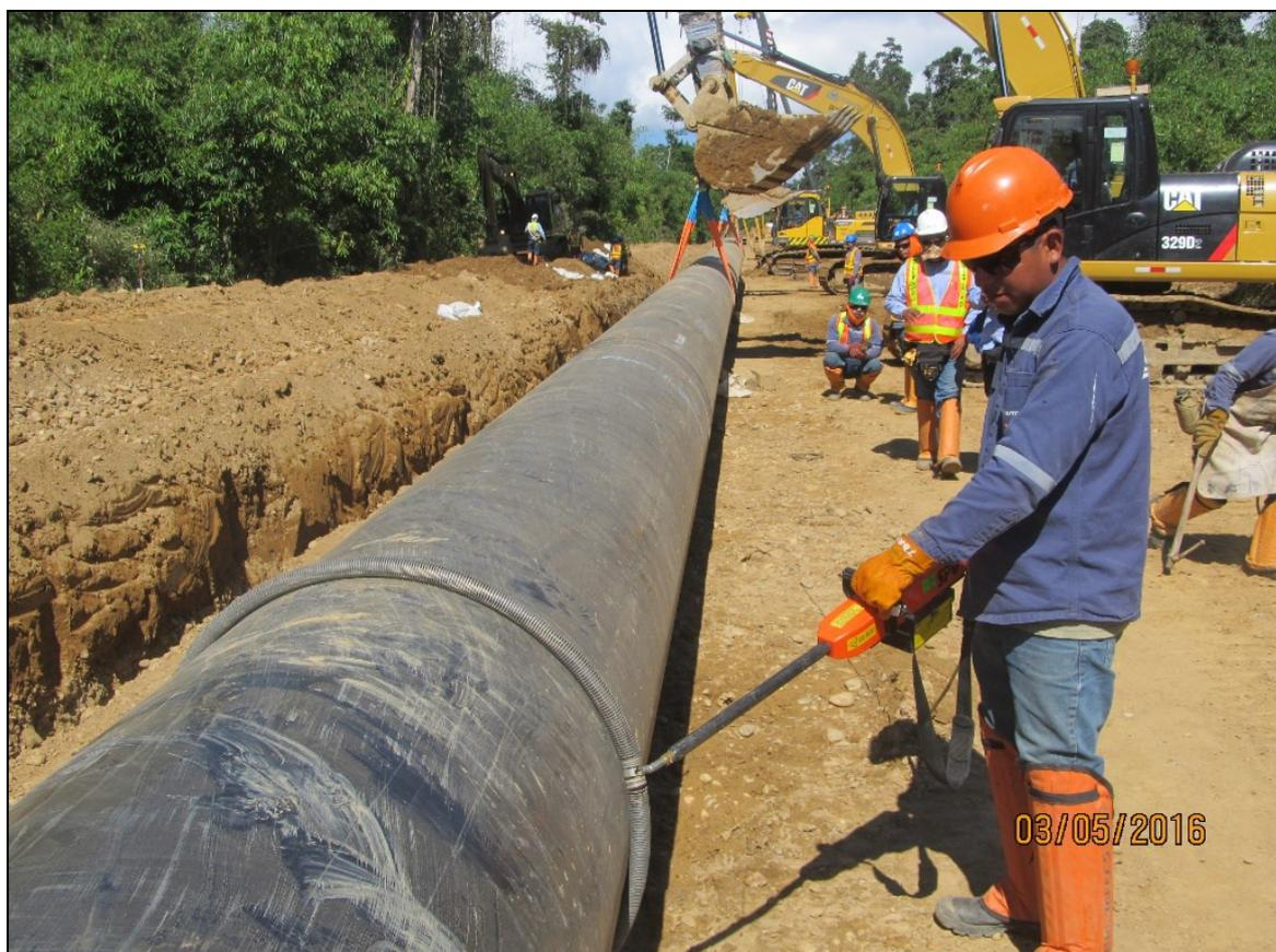
Segmento 1, Tramo B - KP 13. Supervisión de la inspección de la cobertura de la soldadura con "Holiday Detector".
