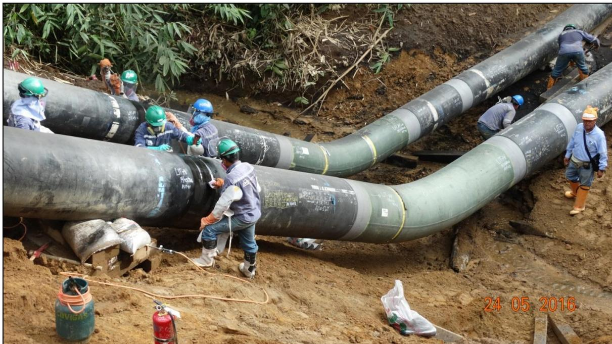
Segmento 1 - Tramo B, KP 10+224. Trabajos de revestimiento de los ductos de 32"φ y 24"φ.
