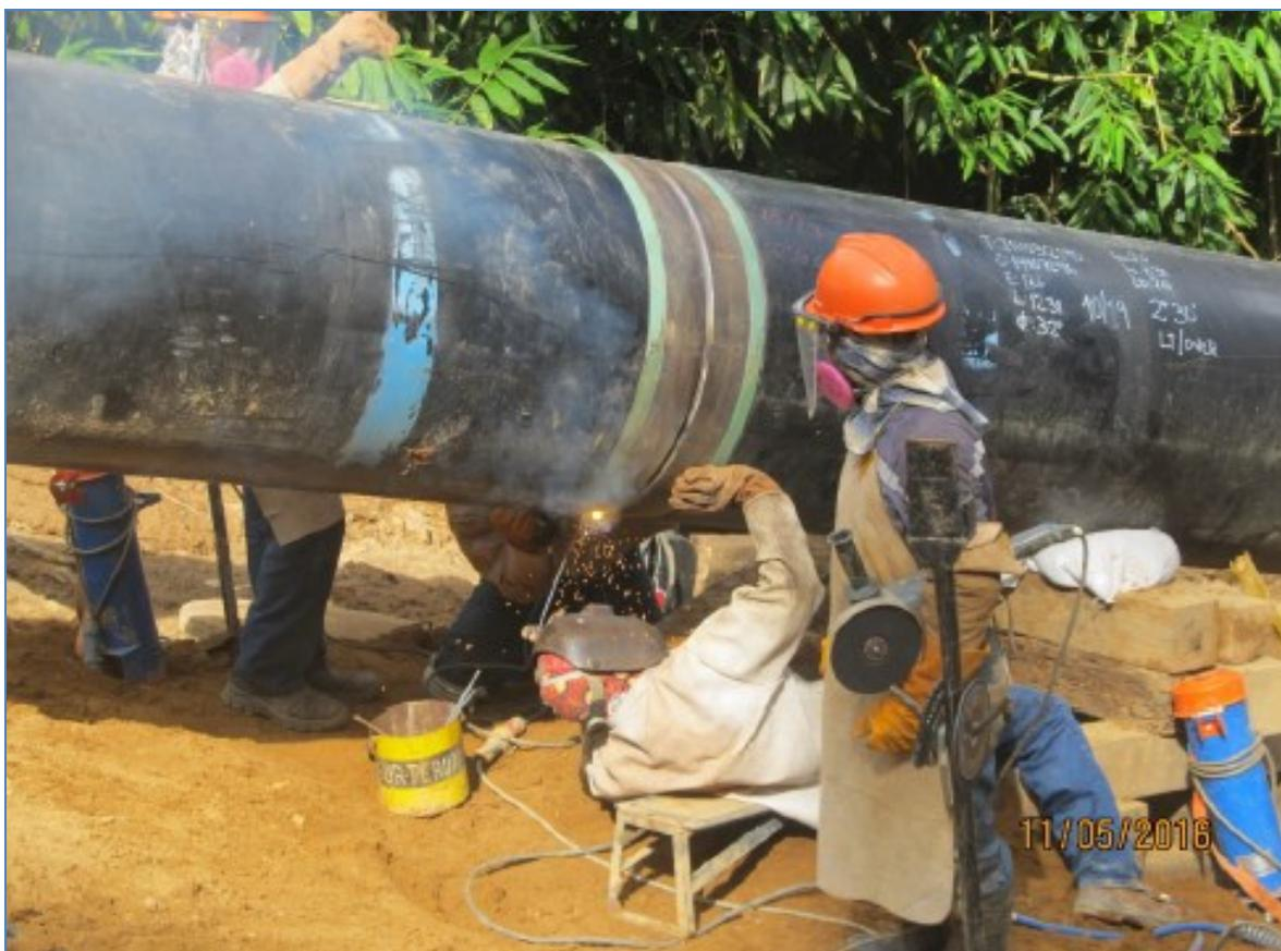
Tramo B - Segmento 1, KP 10+133. Soldadura de Tubería de 32"  $\varnothing$  (Junta 32 J-10/19).
