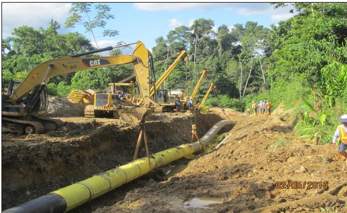
Segmento 1-Tramo B, KP 7+696. Supervisión de los trabajos de bajada de tubería a zanja.
