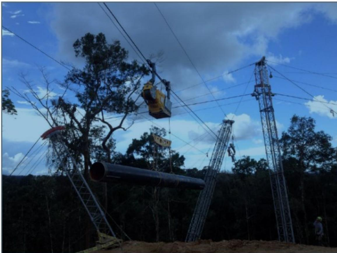
Segmento 01 del Tramo B. Pruebas del teleférico para el transporte de tuberías.
