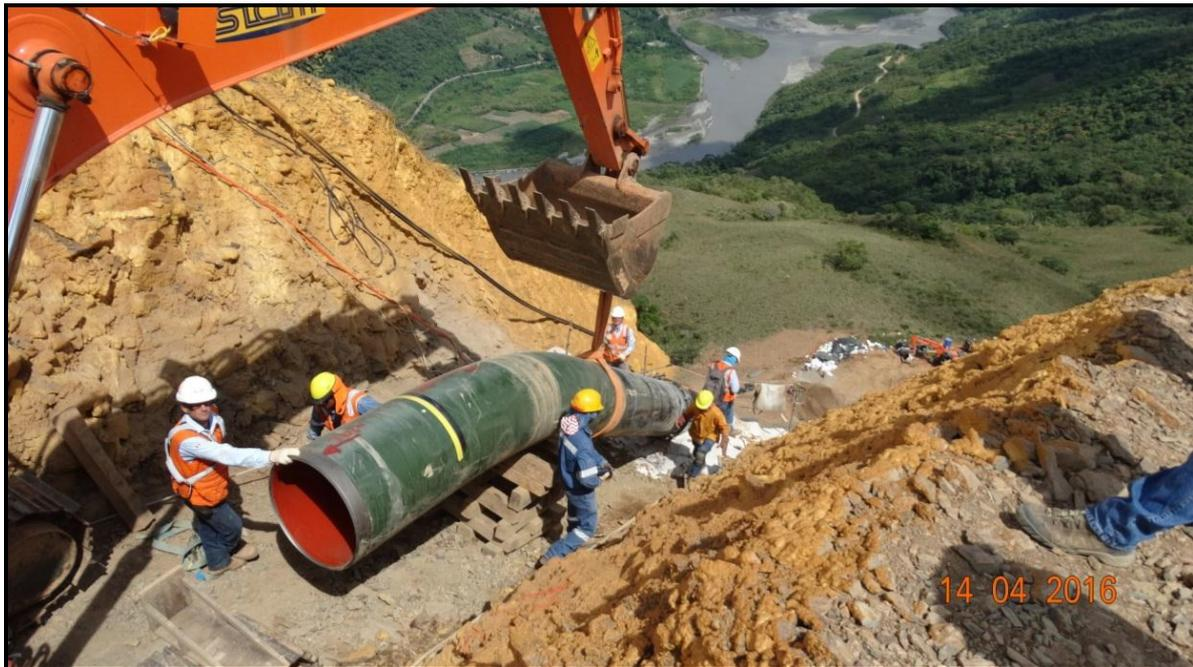
Tramo A1 – Segmento 3, KP-0134+500. Trabajos de alineamiento de tubería de 32"Ø en pendiente de 66°.
