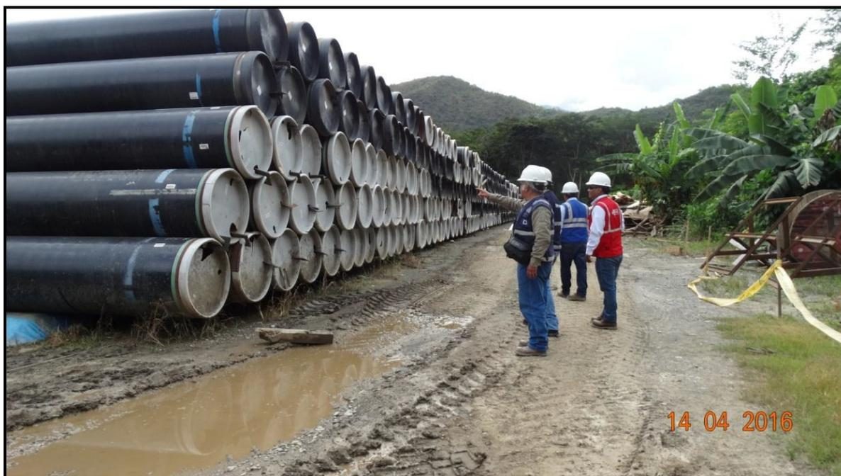
Acopio del Kp 85. Inventario de tubería de 32"Ø para el segmento 03 del Tramo A1
