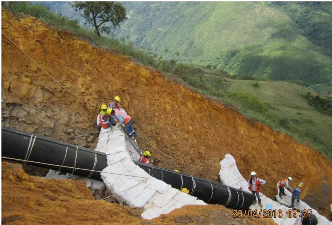
Tramo A1 - Segmento 3, KP 0134+510. Trabajos de tapada de la tubería de 32"Ø.
