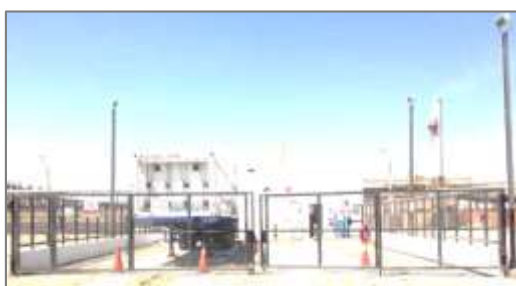
Figura N° 1: Vista de estación de GNC. Fuente: Osinergrmin
