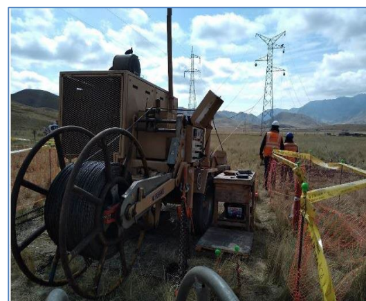
Tendido de Cable de Guarda EHS y OPGW Tramo T100 a T114
