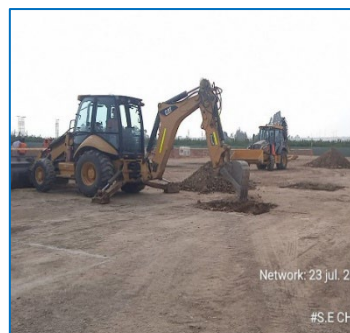
Excavación en Patio de Llaves
