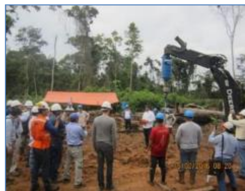
Prueba de pilotes helicoidales
