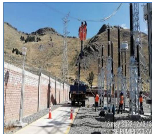
Instalación de Acometida Subestación Pumiri
