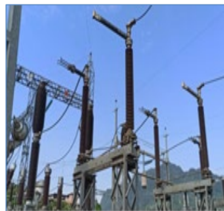
Montaje de Seccionadores en S.E. Tingo María
