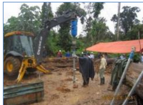
Prueba de pilotes helicoidales
