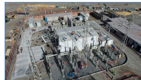
Colocación de Conductor desde el Pórtico de la S.E. Lomitas a la T144
