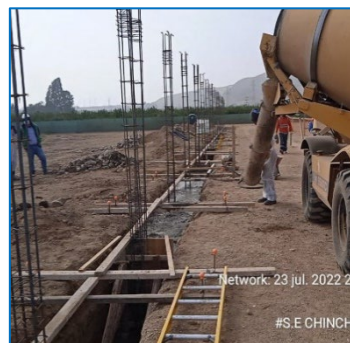
Construcción de Cerco
