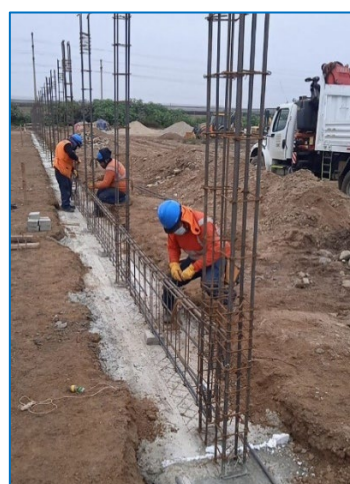
Armado de Bases de Cerco
