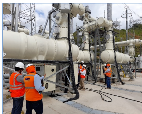
Inspección de Subestación GIS 500 kV
