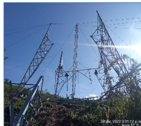
Montaje de Torre T57 de LT 500 kV Campas - Yaros
