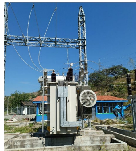
Transformador de Potencia 7 MVA de S.E. Quiroz
