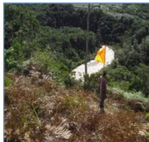
Trabajos de Replanteo de la L.T. (Vértice V1)
