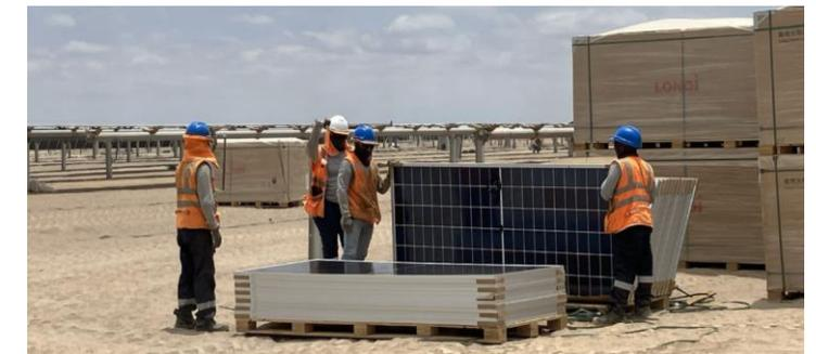
**Colocación de módulos, módulos de 615W por tracker**
