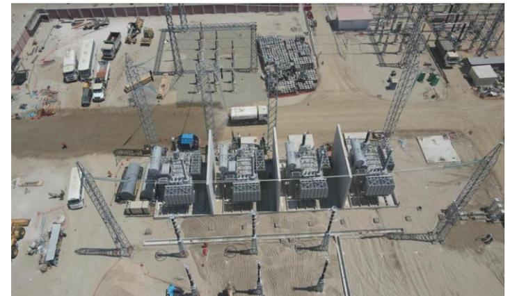
Vista del banco autotransformadores monofásicos de potencia de 200-250 MVA (ONAN-ONAF) c/u
