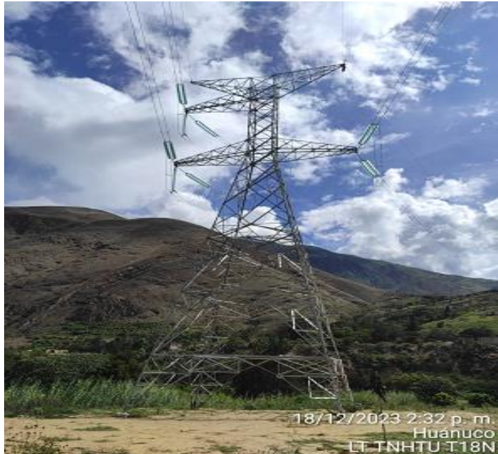
T18N: Regulado de conductores – LT Yaros-Yungas
