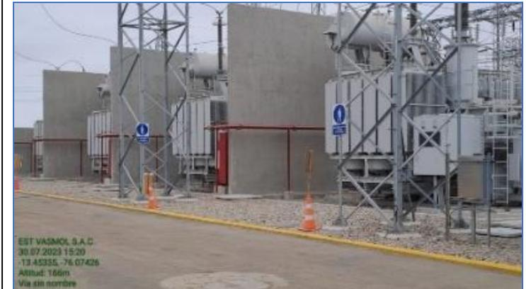
**Banco de transformadores monofásicos, 220/60kV 100MVA-120MVA
