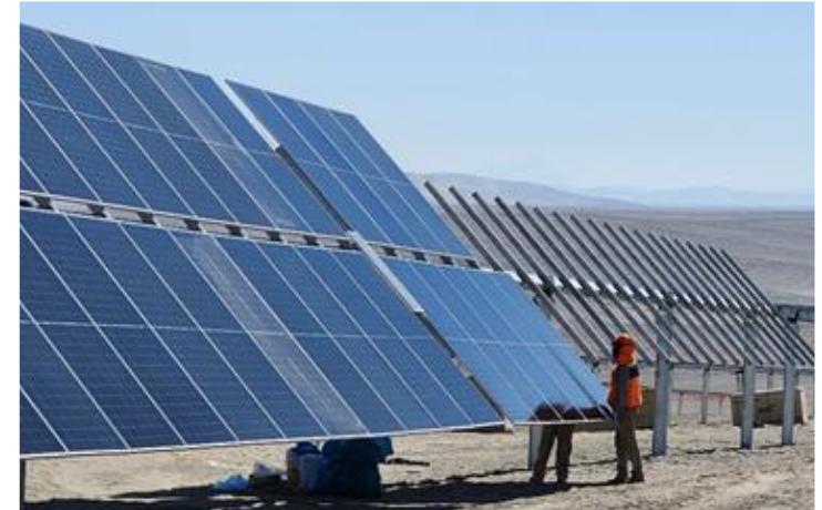
Vista de montaje de módulos fotovoltaicos bifaciales (modelo JKM535M-72HL4-BDVP)
