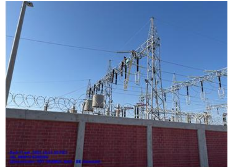
Trabajos para conexión de Enlace 220 kV a S.E. Cahuachi
