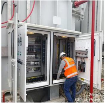
S.E. Chilca: Conexionado de fibra en tablero de Autotransformador
