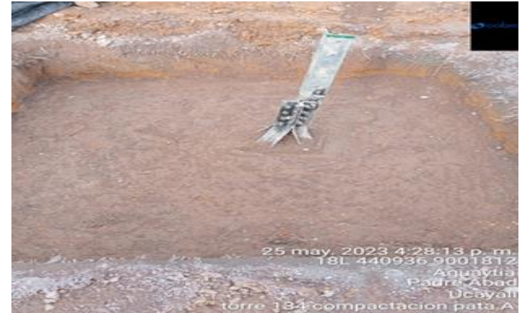
Compactación en la torre T134
