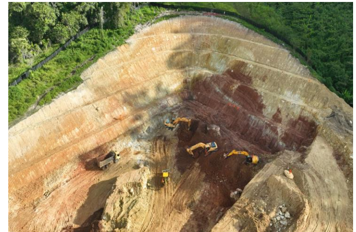
Corte y eliminación de material excedente en la futura S.E. Leoncio Prado
