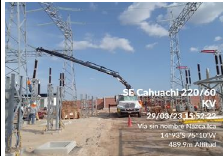
Montaje de Pararrayos Patio de 60 kV
