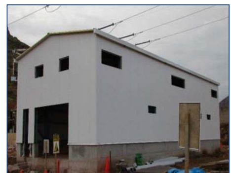
S.E. Friaspata: Instalación de cobertura sala GIS
