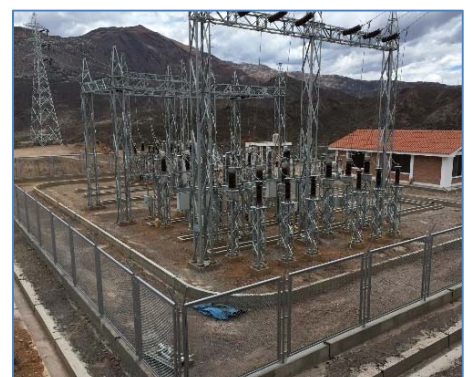
Obras S.E. Aguas Calientes
