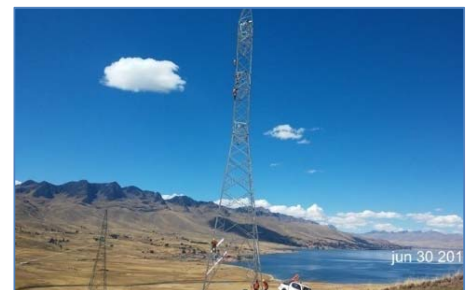
Inicio de revisión de estructura en T46
