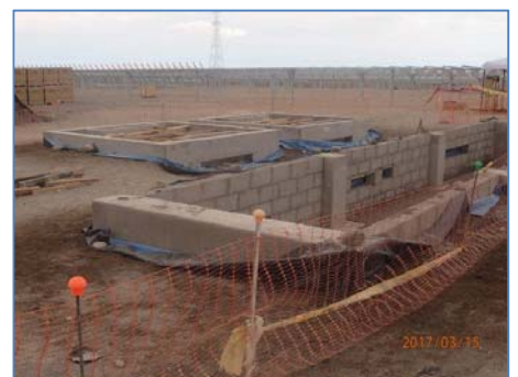
Avances en la Subestación de Salida
