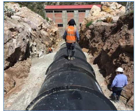
Tubería Forzada
