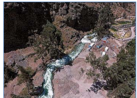
Construcción de Campamento
