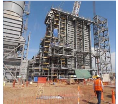
Montaje de la caldera de recuperación de calor
