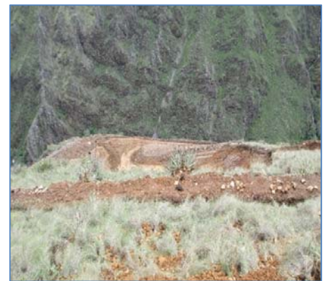
Replanteo de trazo topográfico
