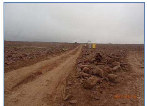
Inicio de Obras Civiles
