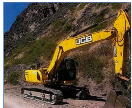
Movilización de equipos
