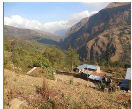
Obras en plataforma de Canal de Aducción
