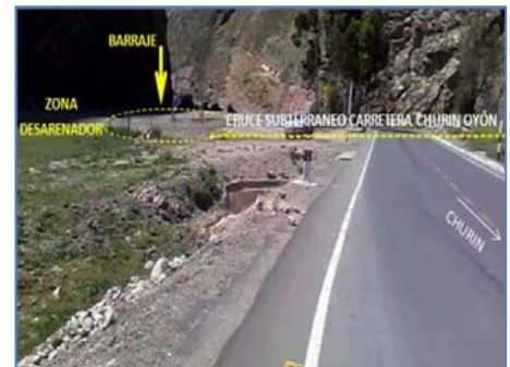
Cruce del ducto subterráneo de la CH Viroc
