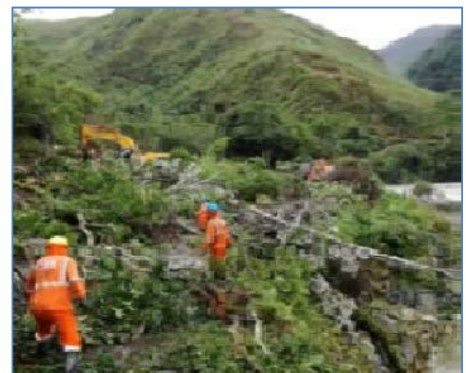
Desbroce y habilitación de tramo 1
