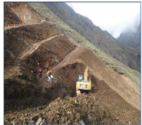
Limpieza de material suelto en talud
