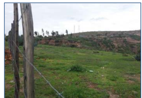
Cerco perimétrico de la futura S.E. Mollepata
