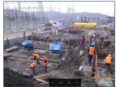
Trabajos en Fundaciones
