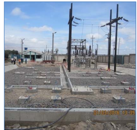
Obras civiles en la S.E. Bella Unión
