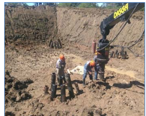
Instalación de pilotes en tramo aéreo de la línea
