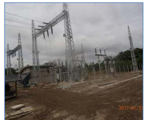
Trabajos en la Subestación de Salida
