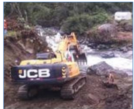
Habilitación de accesos y obras provisionales
