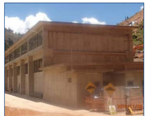
Casa de Máquinas
