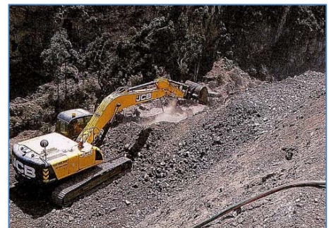
Trabajos de excavación – Portal de entrada de Túnel
