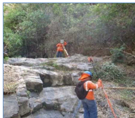
Trazo y replanteo topográfico
