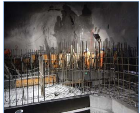
Encofrado y vaciado de concreto en Casa de Máquinas
