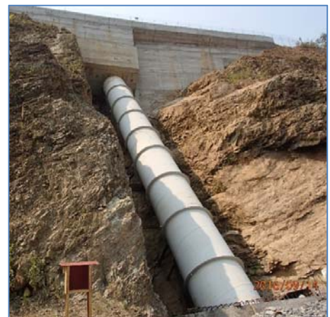
Tubería Forzada
