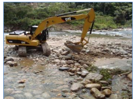
Mantenimiento y mejora de carretera de acceso
