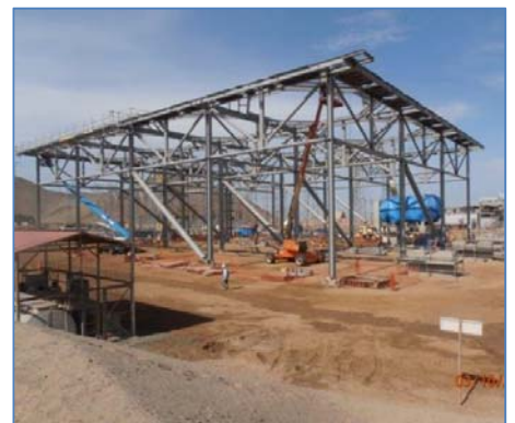
Estructuras instaladas del Aerocondensador
