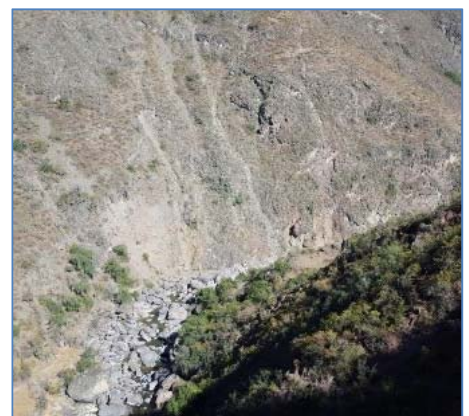
Zona de Casa de Máquinas
