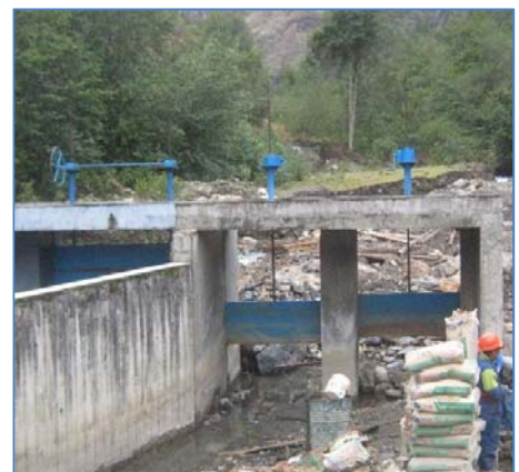
Trabajos barraje en bocatoma
