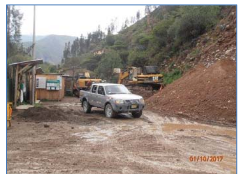
Área donde se construirá la S.E. Santa Lorena
