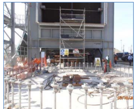
Base y pernos de anclaje de la chimenea
