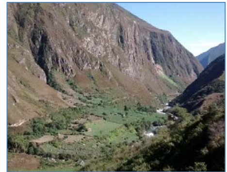
Zona del recorrido del Túnel de Conducción
