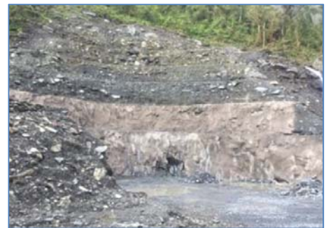
Excavación del Desarenador
