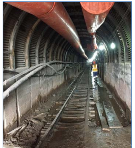
Revestimiento del Túnel de Aducción
