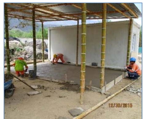
Instalación de campamento
