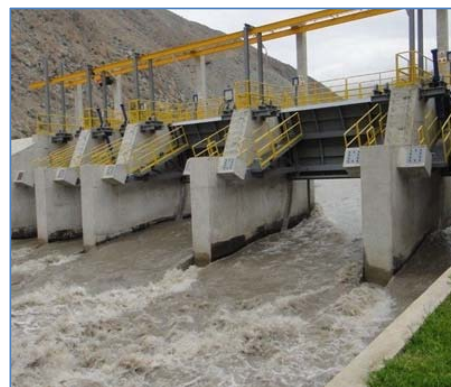
Compuertas radiales
