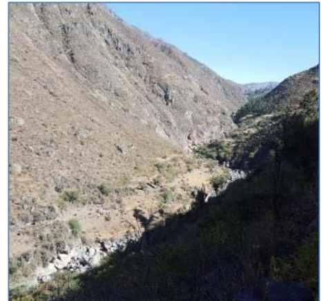
Primer Tramo del Canal de Conducción
