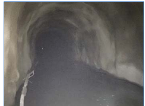
Culminación de excavación del Túnel de Conducción
