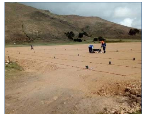
Soldadura de la Red de Malla de Tierra Profunda (S.E. Pumiri)
