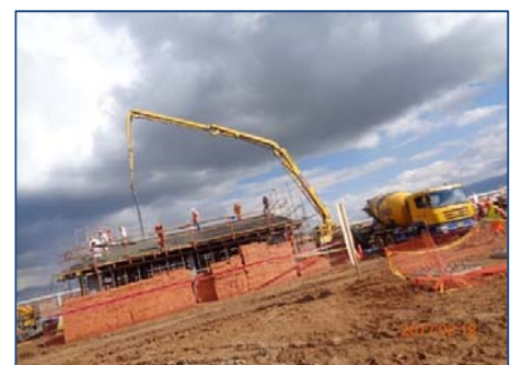
Construcción del Edificio de Control
