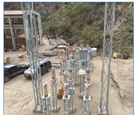
Obras S.E. Potrero
