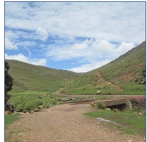
Zona de presa, río Acco
