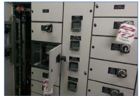
Instalación de Tablero Eléctrico
