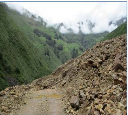
Replanteo de trazo topográfico
