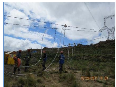
Tendido de Conductor
