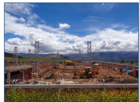
Montaje de pórticos metálicos
