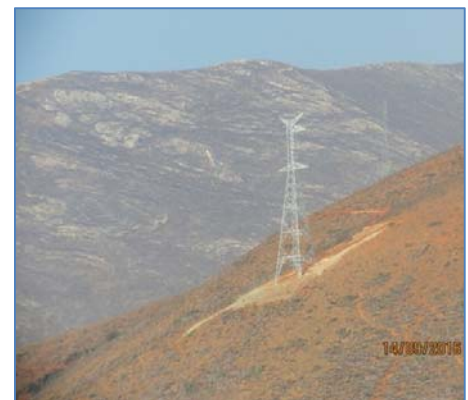
Torre de Suspensión de Simple Terna
