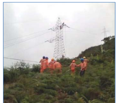
Levantamiento de conductor en torre T7
