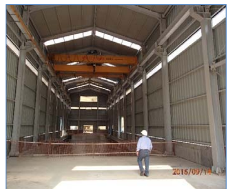
Casa de Máquinas
