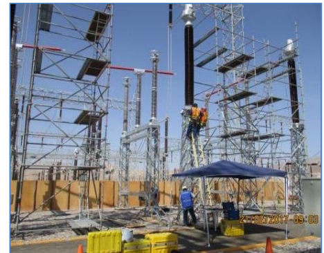
Pruebas Individuales de Equipos (S.E. Montalvo)
