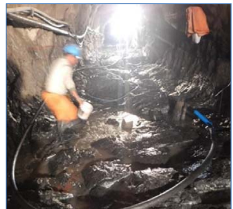
Vaciado de solado en piso del Túnel de Conducción
