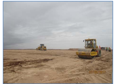
Inicio de Obras Civiles
