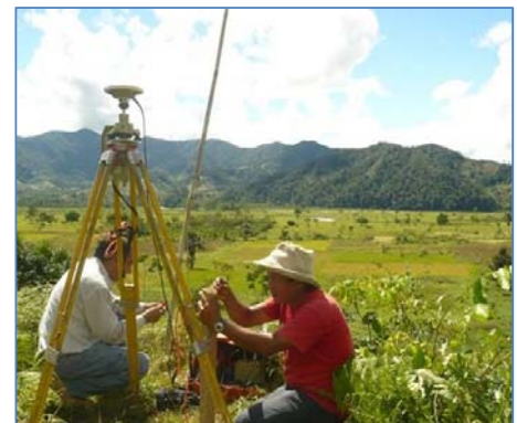
Trabajos topográficos – Zona de Captación
