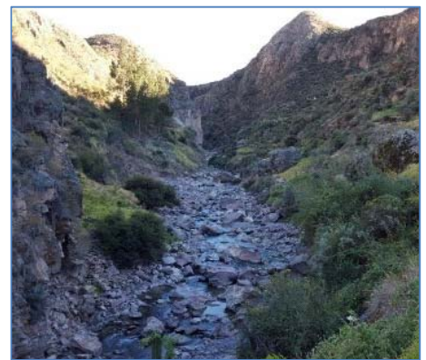
Zona del Canal de Aducción
