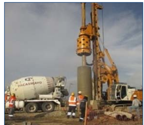
Vaciado de concreto para T08 (Hito d))
