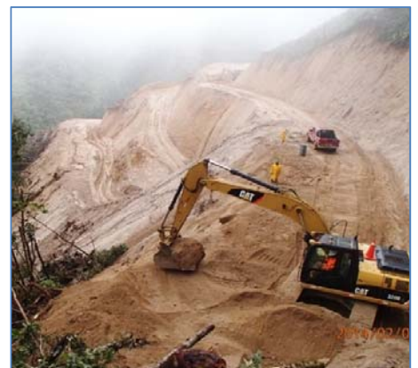
Apertura de trocha de acceso a Casa de Máquinas
