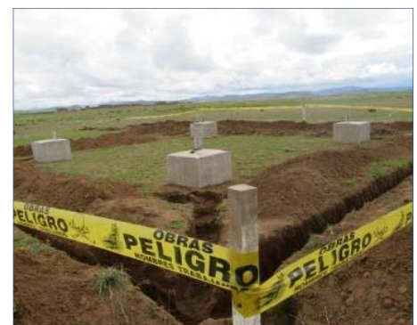
Área de Excavación de Puesta a Tierra
