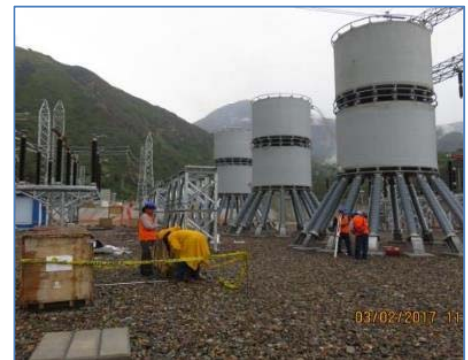
Montaje de Capacitor Shunt (S.E. Colcabamba)
