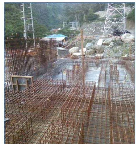
Armadura de la Subestación Elevadora
