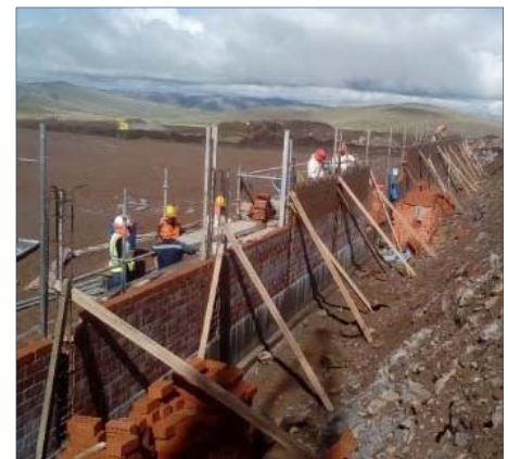
Encimado de Muros (S.E. Puno)
