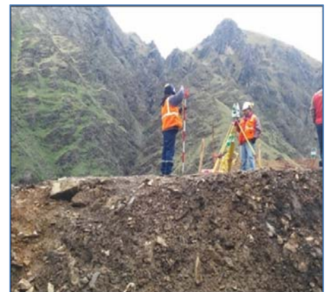
Replanteo topográfico
