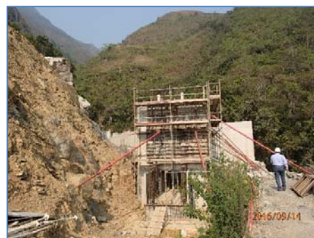
Cámara de Carga
