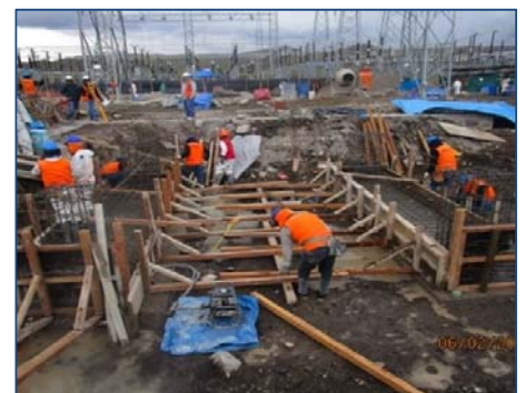
Trabajos en Fundaciones
