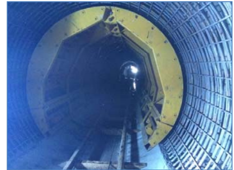
Reforzamiento en concreto del túnel de conducción
