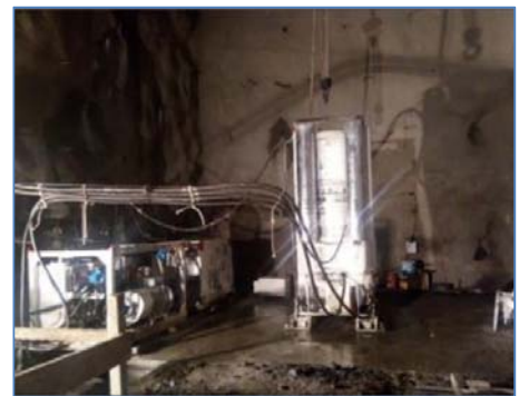
Instalación del equipo Raise Boring
