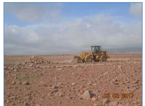
Inicio de Obras Civiles
