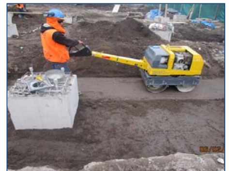
Trabajos en Fundaciones
