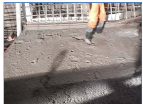
Vaciado de losa estructural en la Cámara de Carga
