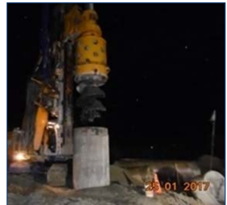
Perforación para estructura T08 (Hito d))
