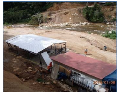
Construcción de Campamento Provisional
