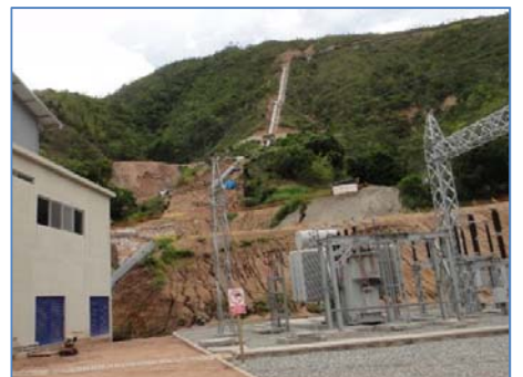
Casa de Máquinas, Tubería de Presión y Subestación
