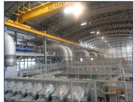
Vista de Montaje de Tubos de Escape
