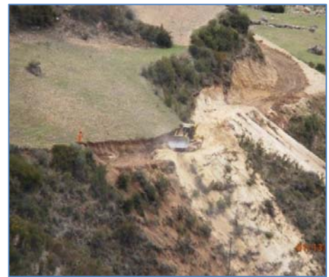
Obras en plataforma de Canal de Aducción
