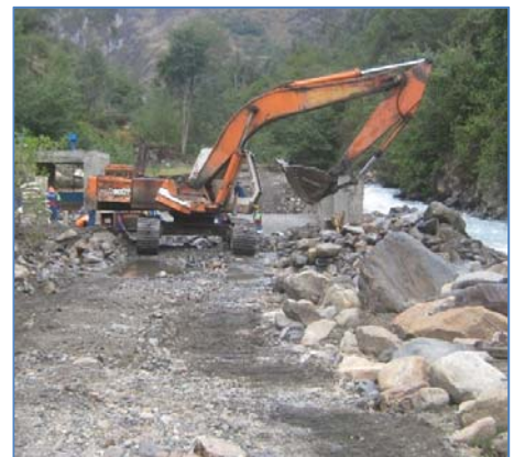
Trabajos barraje en bocatoma
