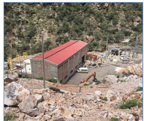
Vista panorámica de la Casa de Máquinas y Subestación
