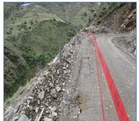
Replanteo de trazo topográfico
