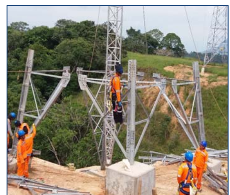
Montaje de Torres
