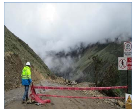
Señalización y replanteo topográfico
