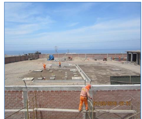
Obras Civiles en la S.E. Chala
