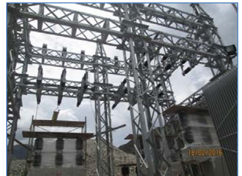
Pórtico de salida en la S.E. 8 de Agosto
