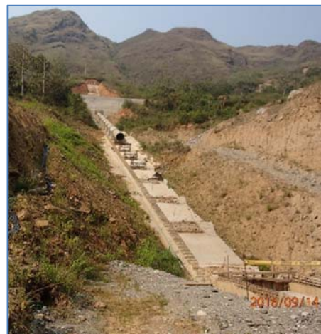
Montaje de la Tubería de Presión
