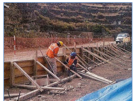
Construcción del campamento
