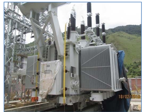
Montaje del Transformador de Potencia
