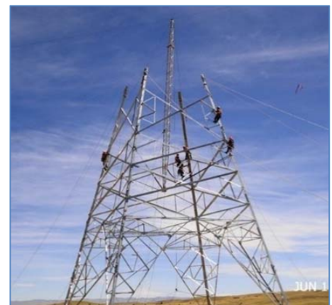
Montaje de torre T116
