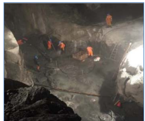
Casa de Máquinas – Limpieza para vaciado de solados
