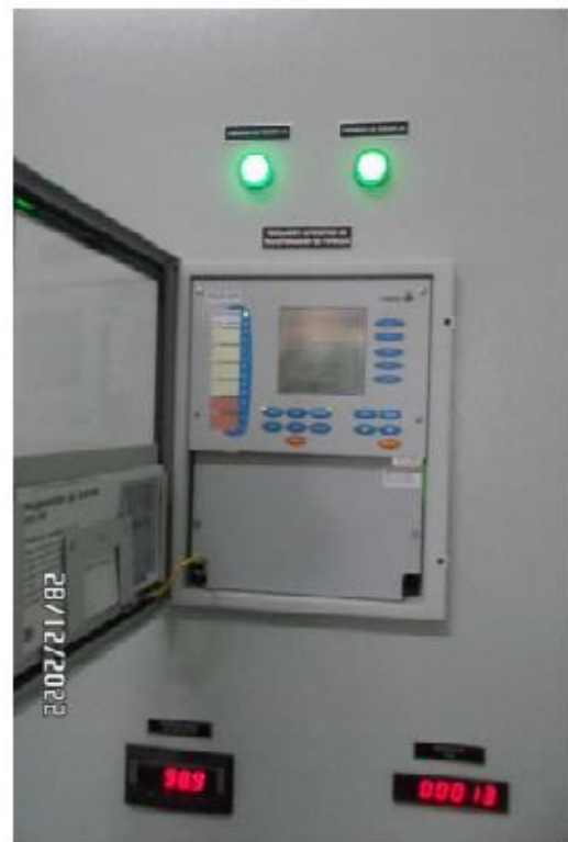
Foto 9. SET La Pampa (Camaná). Regulador automático de transformador de potencia.
