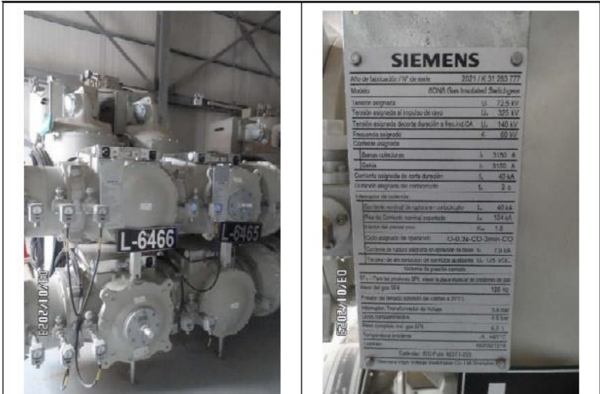
Foto 4. SET Pachacútec. Celda de línea (L-6466) 60 kV. Encapsulada (GIS), interior, simple barra.
