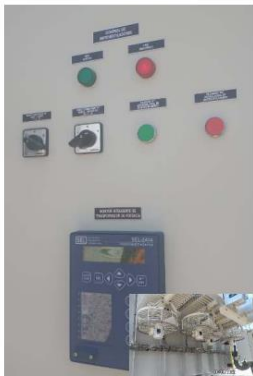
Foto 8. SET La Pampa (Camaná). Tablero de control de motoventiladores.
