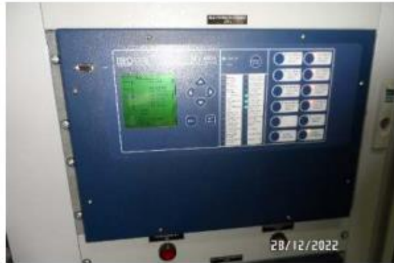
Fotos 6 y 7. SET La Pampa (Camaná). Equipos de medición, protección y control en sala de celdas de SEAL.
