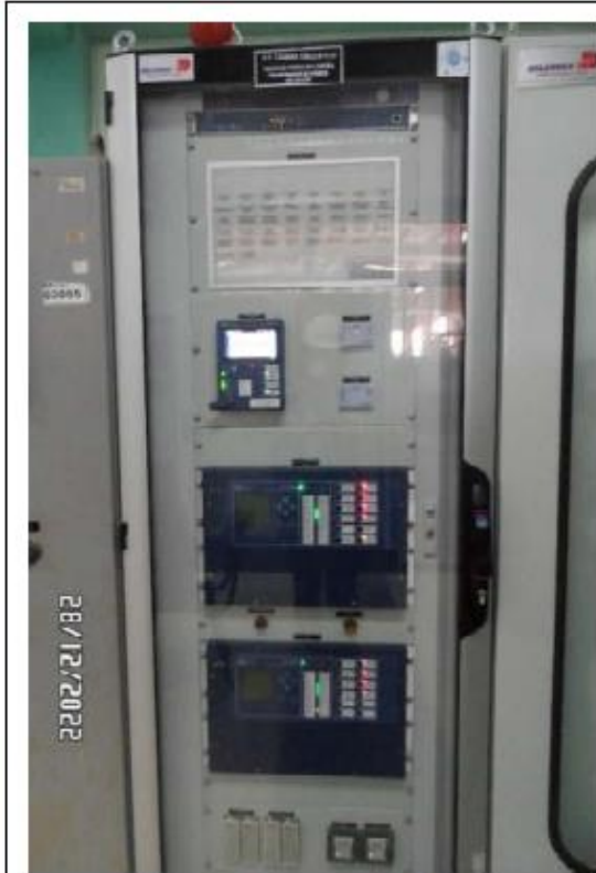
Foto 5. SET La Pampa (Camaná). Tablero de protección y control de transformador de 30 MVA.
