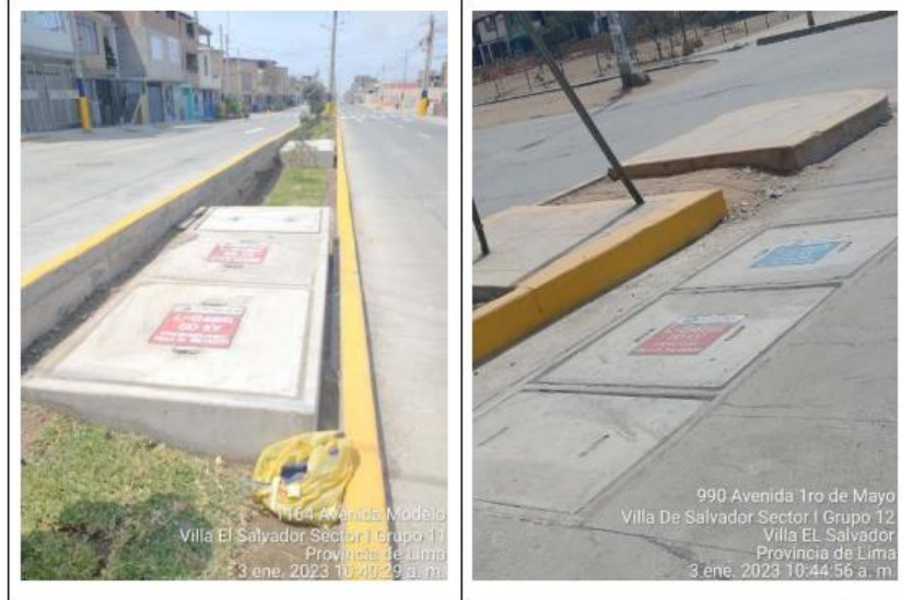
Foto 1. LT 60 kV Pachacútec-Villa El Salvador (L-6465/L-6466). Cámara de empalme CE-01.
