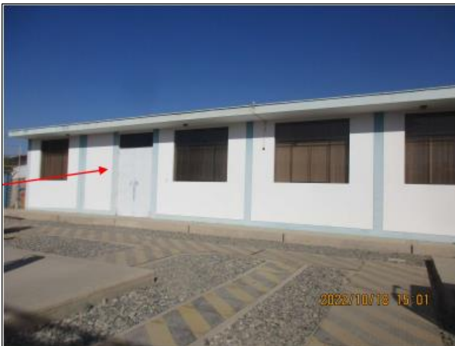
Fotografía N° 2. Sala de Celdas - SET Tacna, ElectroSur
