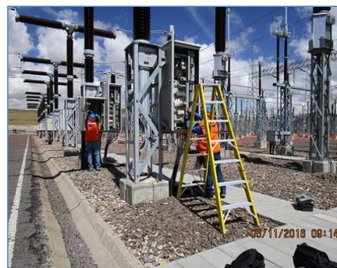
Trabajos realizados durante cortes
