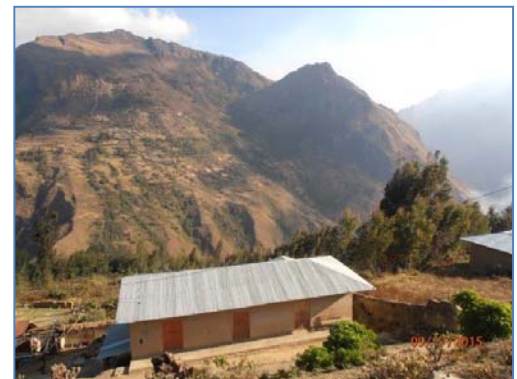
Zona de Casa de Máquinas
