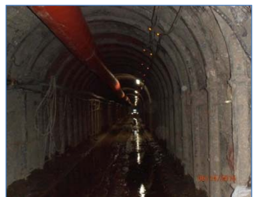
Túnel de la Ventana 2
