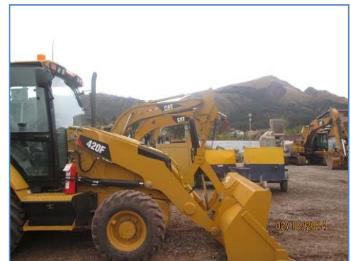
Maquinaria para la obra
