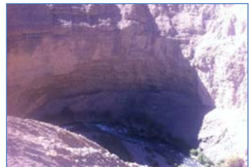
Zona del portal del túnel de descarga
