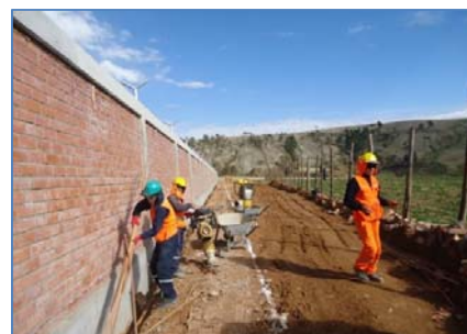
Trabajos de relleno de zanjas aledañas al cimiento
