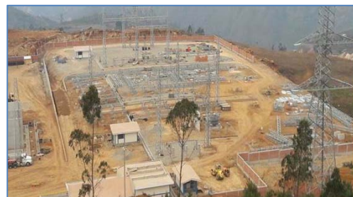
Construcción de la SE Cáclic
