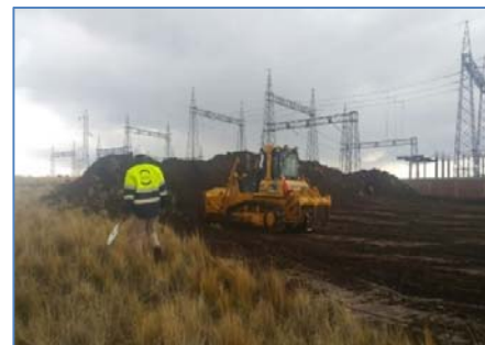
Ampliación SE Puno: material de desmorte
