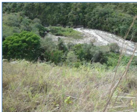
Vista Panorámica de la Casa de Máquinas
