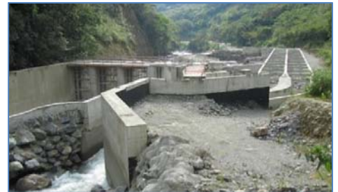
Trabajos en la Bocanata
