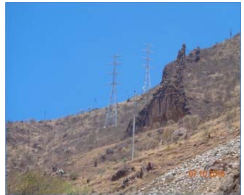
Vista de torres montadas
