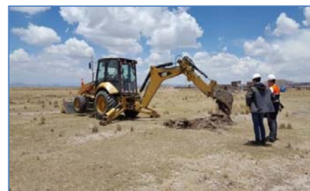
Cata de terreno y definición de cimentación
