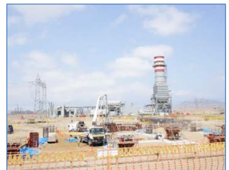
Construcción de cimentaciones
