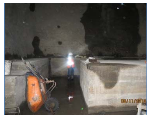
Construcción de bases de tableros de generadores
