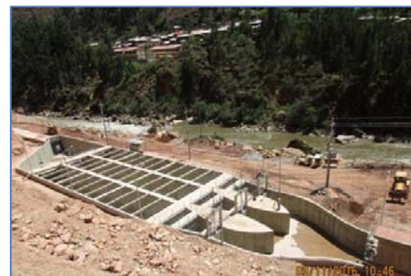
Trabajos en el Desarenador
