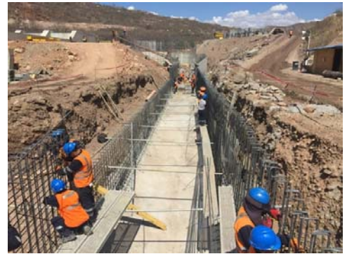
Obras del canal de conducción
