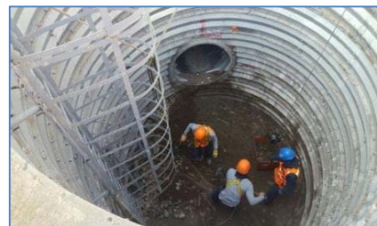
Avances en el tramo subterráneo
