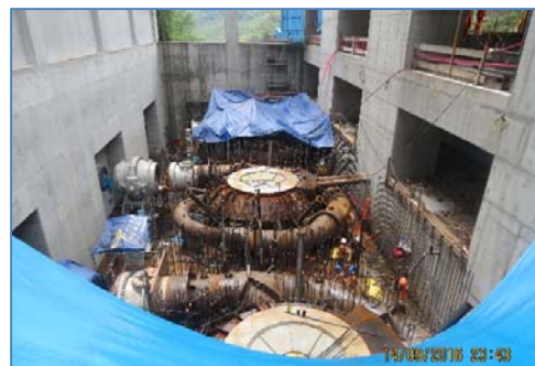
Montaje de válvulas esféricas y volutas
