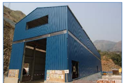
Construcción de la Casa de Máquinas
