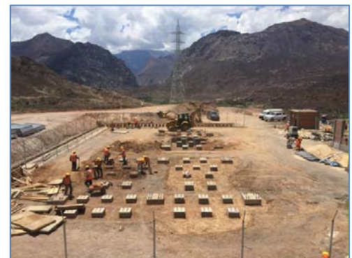
Obras en S.E. Aguas Calientes
