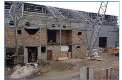
Construcción de Casa de Máquinas
