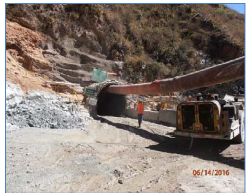
Vista del ingreso al Túnel Piloto
