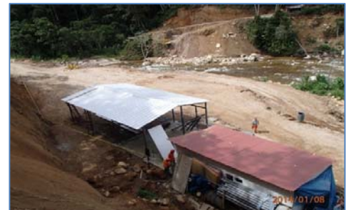
Construcción de campamento provisional
