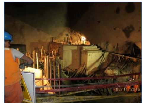
Construcción de Fundaciones de turbinas 1 y 2
