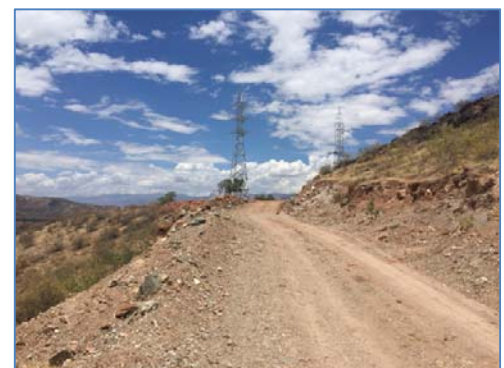
Torres de L.T. 60 kv
