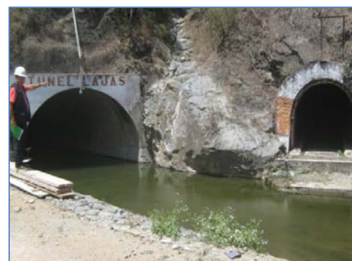
Bifurcación del Túnel Trasandino – Túnel Lajas
