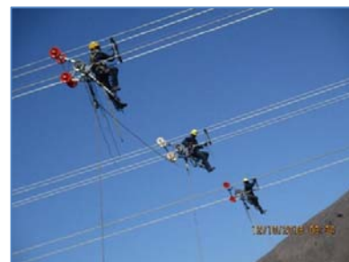
Instalación de separadores en línea de transmisión
