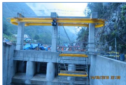
Circuito monorriel de izaje de compuertas
