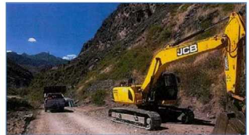
Movilización de equipos
