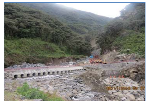
Construcción provisional de desvío del río Chiamayo
