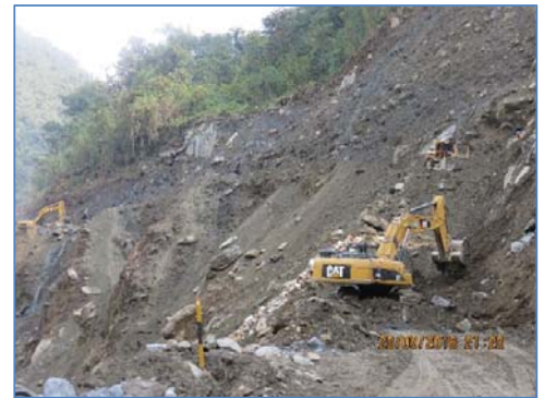
Trabajos de acceso para llegada a bocatoma
