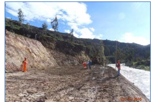
Vista de la Plataforma en el inicio del canal
