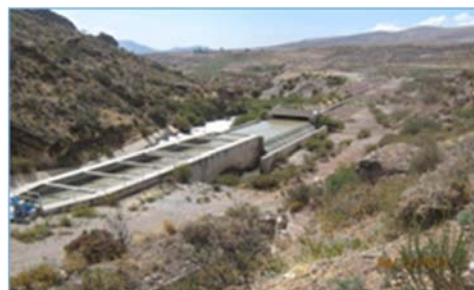
Salida del Túnel (Estructura Existente)
