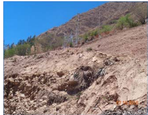
Trabajos de relleno, compactación y pre armado de la torre V51
