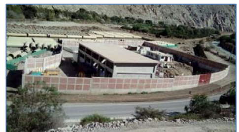
Casa de Máquinas
