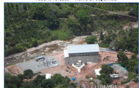
Vista de la Casa de Máquinas y Subestación Eléctrica
