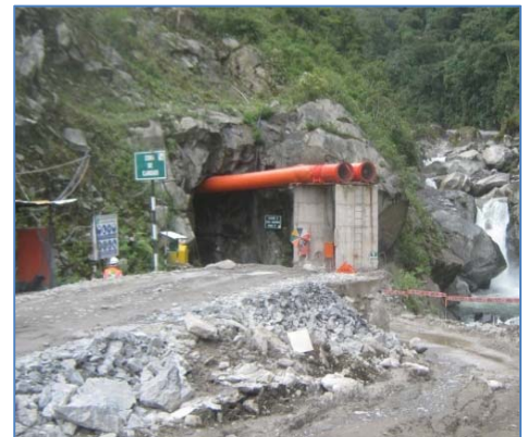
Túnel de Acceso a Casa de Máquinas C.H. Ángel II
