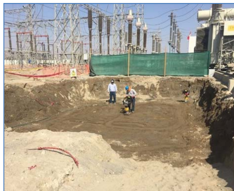
S.E. Ica: cimentación del transformador
