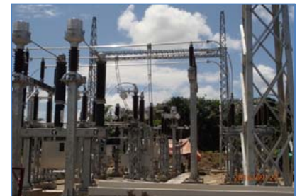
Montaje de equipos en la subestación
