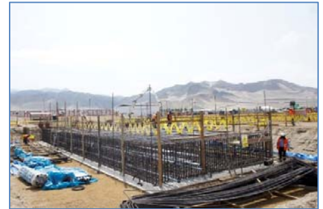
Construcción de bases para el Grupo
