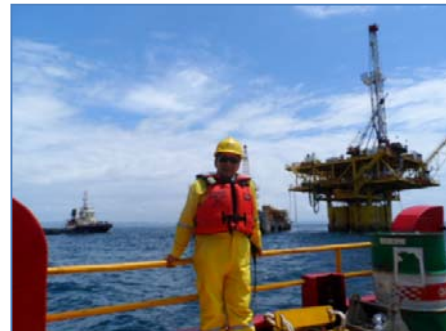
Vista Panorámica de la Plataforma Corvina CX11 (Lugar donde se inicia el gaseoducto)
