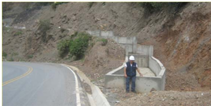
Vista del Canal de demasías en construcción
