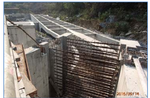
Construcción del Desarenador
