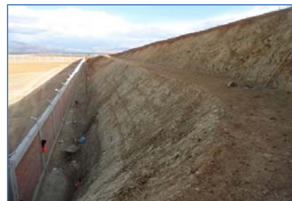
Talud de corte ejecutado, banqueta y talud superior
