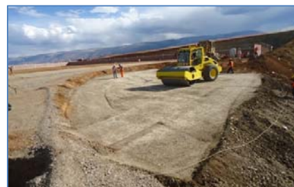
Trabajos de relleno estructural
