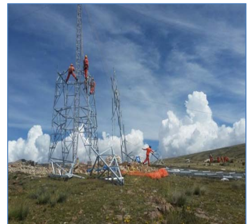
Montaje de la torre N° 129
