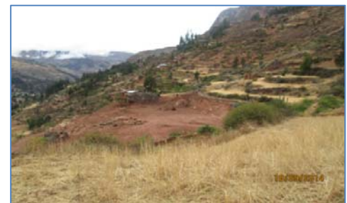
Desbroce y Nivelación de Terreno para Subestación
