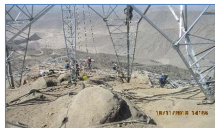
Avances en el tramo aéreo
