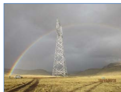
Torre T288 montada al 100%
