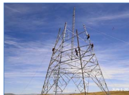
Montaje de la Torre T116
