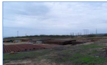
Zona de Ubicación de la C.T. Nueva Esperanza
