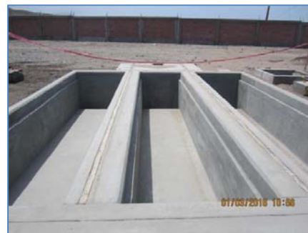
Fundación para el transformador de potencia S.E. Chala
