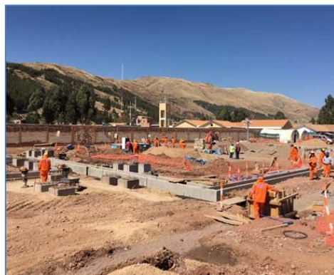
SE Combapata: avance de obras civiles
