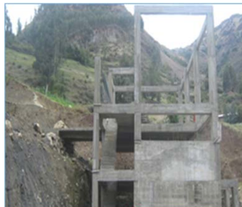
Casa de Máquinas, Obras Estructurales Concluidas
