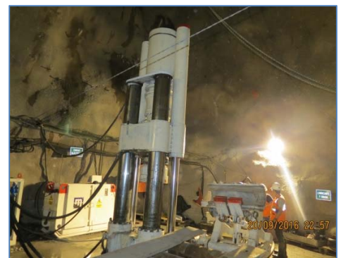
Equipo "Raise Boring" de perforación
