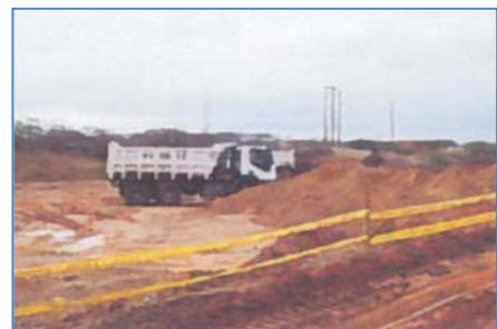
Movimiento de Tierras (Ubicación de la Central)
