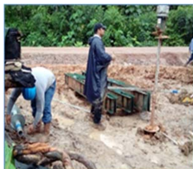
Prueba de Instalación de Pilotes
