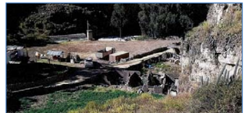
Trabajos preliminares en casa de máquinas
