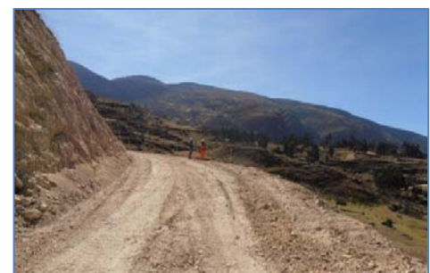
Carretera de Acceso Principal al Canal de Aducción
