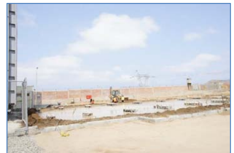
Bases para la Caldera de Recuperación
