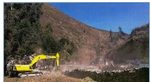
Trabajos preliminares en casa de máquinas
