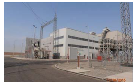
Nave de Turbina-Generador a Vapor
