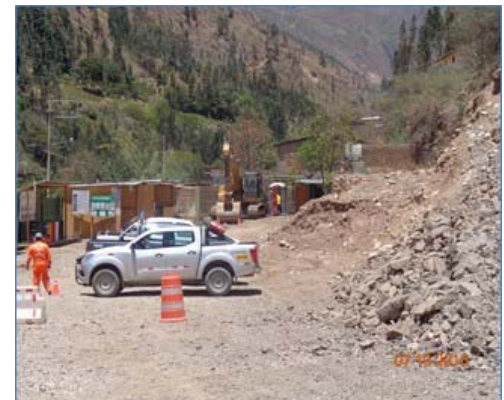
Área donde se instalará la Subestación GIS
