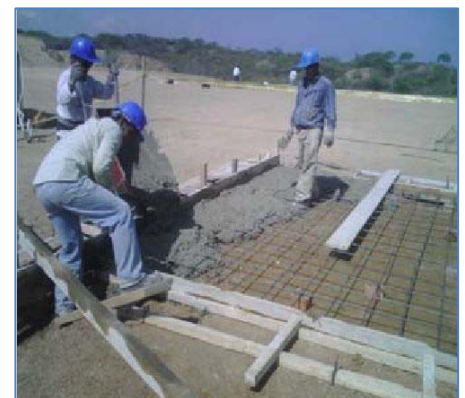
Cimentación de caseta de vigilancia
