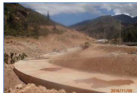
Canal de Conducción
