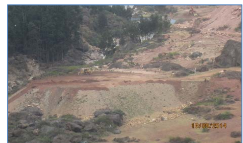
Desbroce y Nivelación de Terreno
