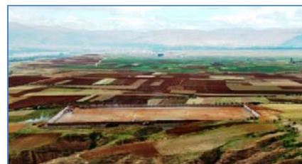
Plataforma de la Subestación
