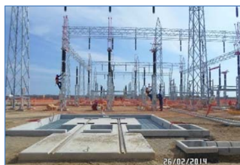
Siliconado de equipos - S.E. Pariñas
