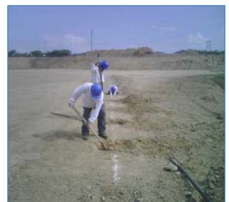
Obras preliminares del cerco perimétrico
