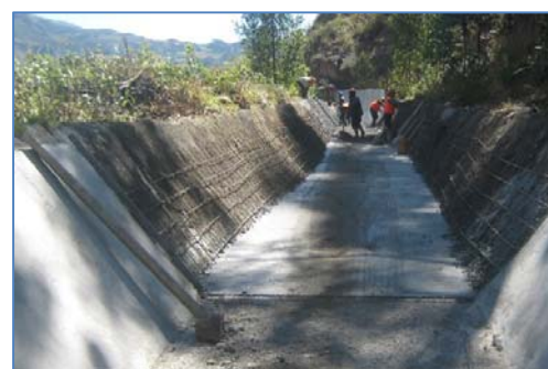
Revestimiento de losa de CA en el Canal de Conducción
