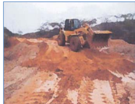
Corte del Terreno (Ubicación de la Central)
