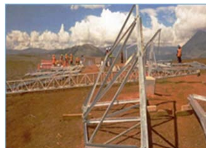
Montaje de la Torre T 220
