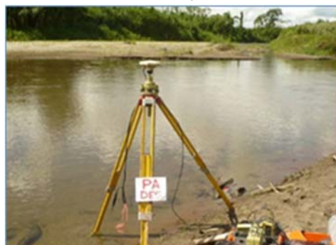
Zona de Descarga –Trabajos Topográficos
