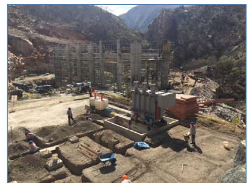
Obras en S.E. Potrero
