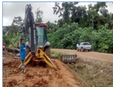
Equipo Básico para Instalación de Pilotes
