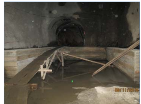
Construcción de bases del transformador trifásico
