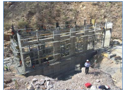
Construcción de la Casa de Máquinas
