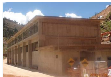
Casa de Máquinas
