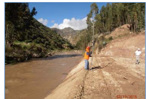
Vista de la Plataforma en la zona del barrage
