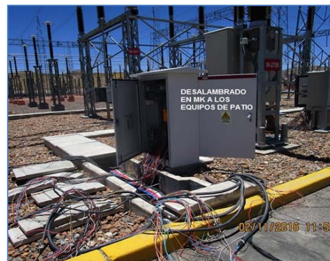
Trabajos realizados durante cortes
