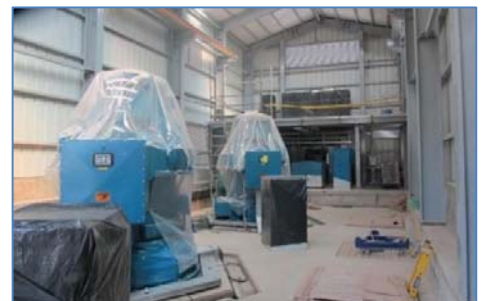
Montaje de Generadores
