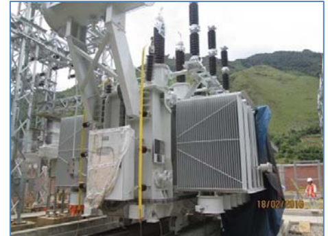
Montaje del transformador de potencia 55 MVA
