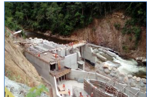
Trabajos en La Bocatoma
