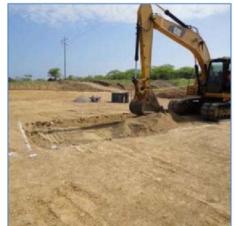
Obras preliminares, trabajos de excavación
