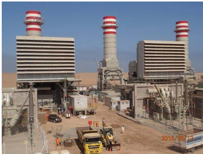
Ilustración 5: Grupos Generadores (C.T. Ilo 4 – Nodo Energético del Sur)
