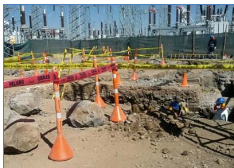
S.E. Puno Existente: Excavaciones
