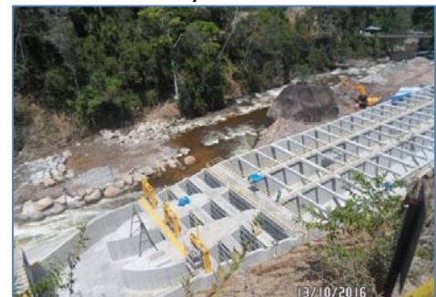
Trabajos en el Desarenador
