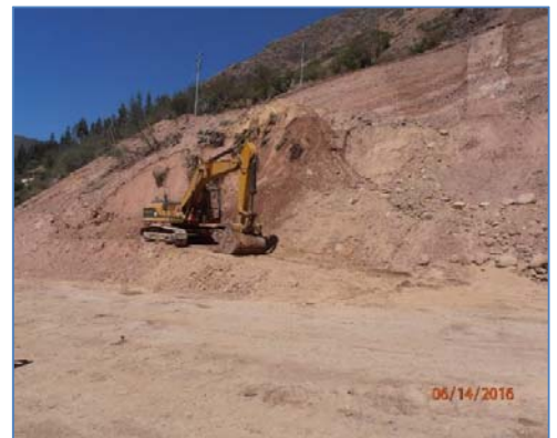
Área donde se edificará la casa de máquinas
