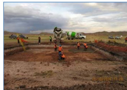
Cimentación tipo losa de torre T-1
