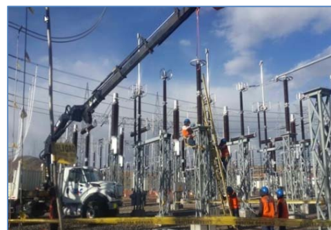
Trabajos realizados durante cortes
