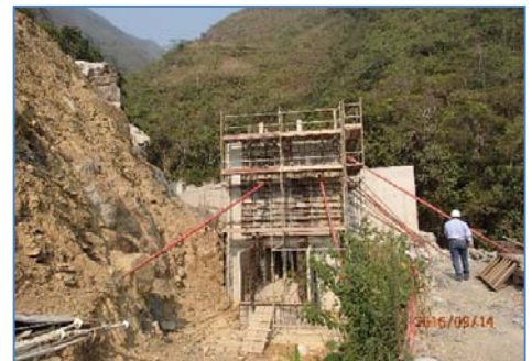
Construcción de la Cámara de Carga
