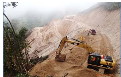
Apertura de trocha de acceso a casa de máquinas
