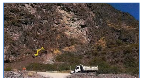
Habilitación de zona de explosivos
