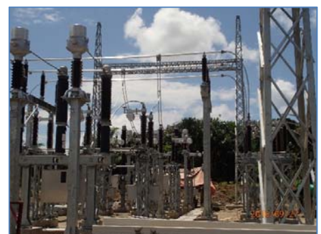
Montaje de equipos en la subestación
