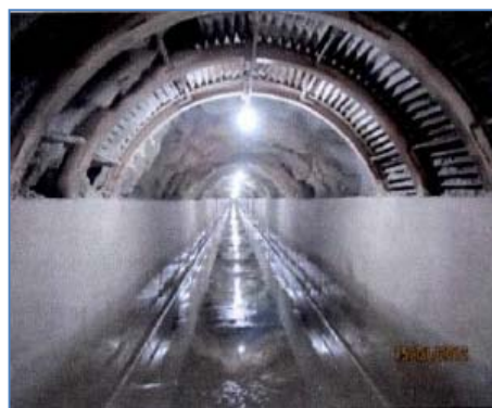
Túnel Huasahuasi I
