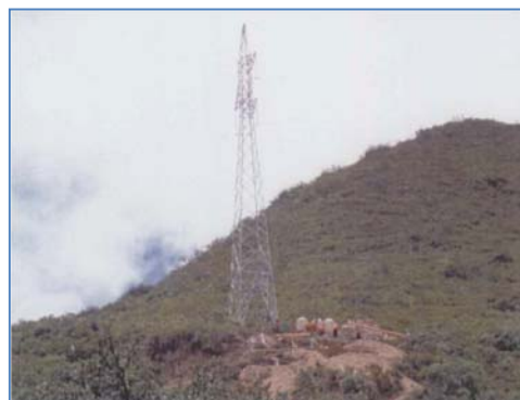
Vista de Torre TE-01
