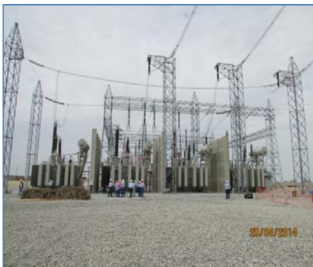
Auto transformadores monofásicos de 500/220 kV (4 x 200 MVA c/u) - S.E. La Niña
