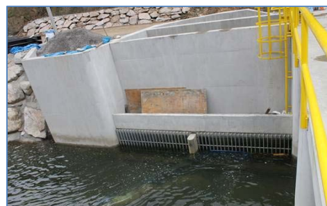
Ventana de captación
