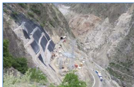
Patio de Llaves S.E. Cerro del Águila
