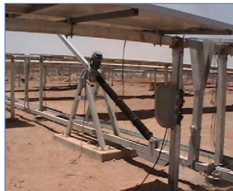
Instalación de Seguidor Solar
