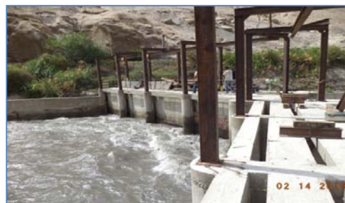
Obra de Captación
