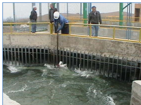
Zona de Captación
