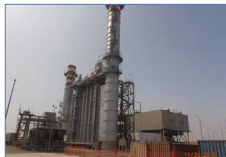
Vista de la CT Chilca 2
