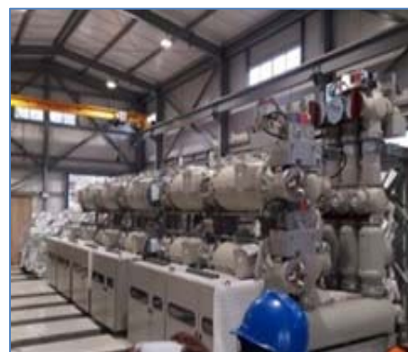
S.E. Friaspata: Instalación GIS
