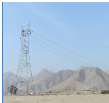
Estructura Autosoportada de la L.T. 500 kV S.E. Fénix – S.E. Chilca
