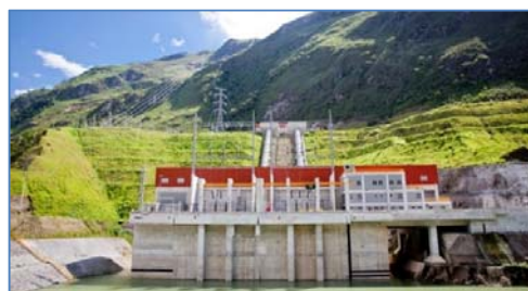
Casa de máquinas principal
