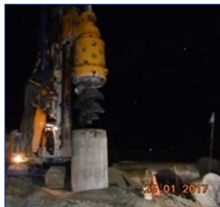
Perforación para estructura T08 (Hito d)
