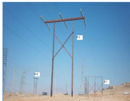
Ingreso a la S.E. Chiclayo Oeste
