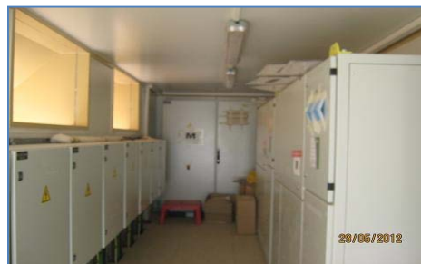
Centro de Transformación de Corriente Continua a Corriente Alterna
