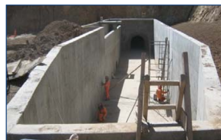
Acabados en la cámara de carga
