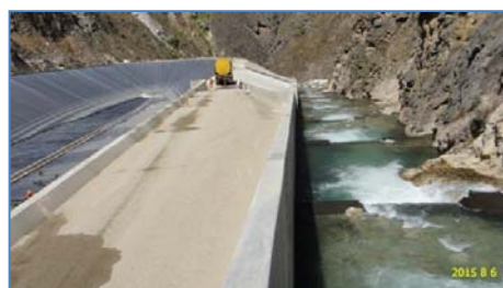
Reservoirio de Regulación Diaria (Sector Shapiringo)
