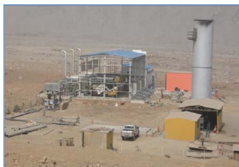
Central Termoeléctrica Huaycoloro
