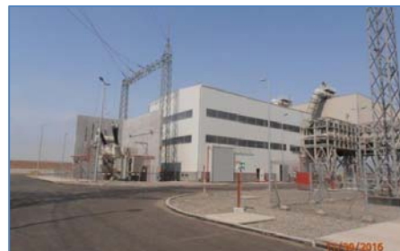
Nave de Turbina-Generador a Vapor
