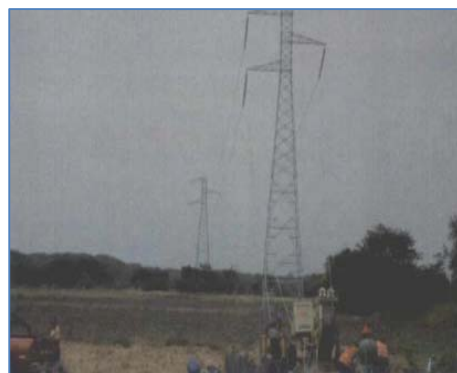
Estructura de la L.T concluida
