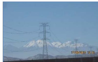
L.T. 220 kV San José – Cerro Verde
