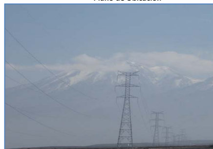
Estructuras autoportadas con doble circuito L2022 y L2023
