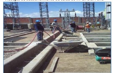
Tendido de cable de potencia 70 mm² Trafo T53-162 - Celda 22.9 kV en S.E. Puno
