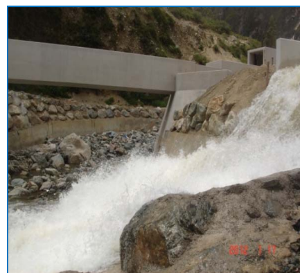
Puente Canal Huasahuasi II
