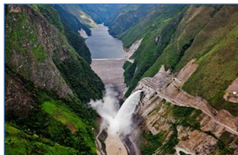
Vista general de la presa
