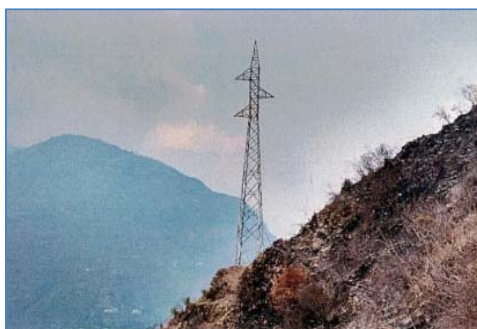
Montaje de Estructura E3 concluido
