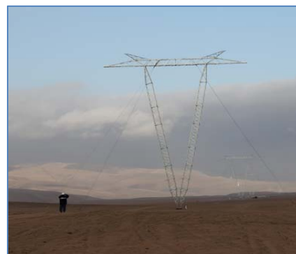
Torres tipo VSL Suspensión Atirantada (Ocoña – Montalvo)
