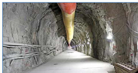
Túnel de Descarga
