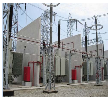
Transformadores 200 MVA c/u-S.E. Chilca 500 kV
