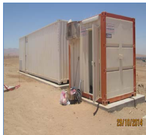
Casa de Control - P.S.F. Moquegua
