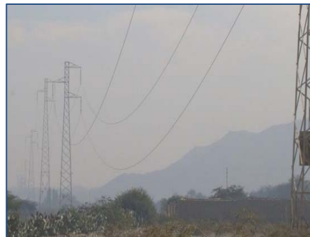
Torres de alineamiento con aisladores de suspensión
