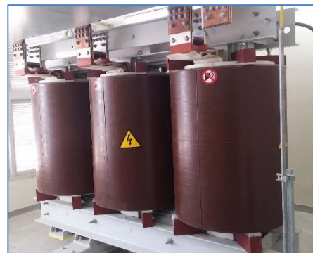
Transformador en Seco del Grupo de Generación N° 1
