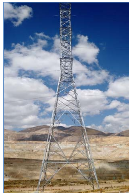
Torre T31N culminada y LT energizada
