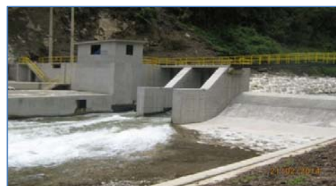
Barraje fijo y móvil de la Bocatoma
