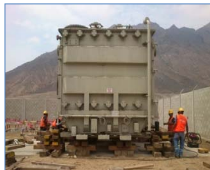
Montaje de Reactor de 40 MVAR (S.E. Trujillo)
