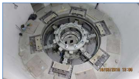
Trabajos previos al montaje del Generador N° 2
