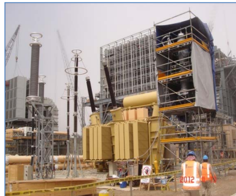
Montaje de Transformador de Potencia de T.G.
