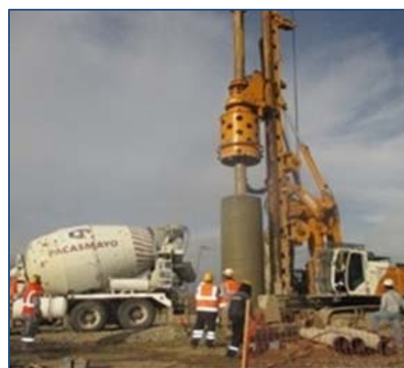
Vaciado de concreto para T08 (Hito d)
