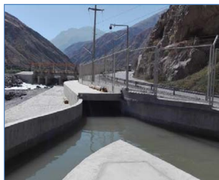
Bocatoma y Canal de Conducción
