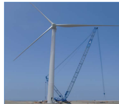
Montaje concluido del Aerogenerador
