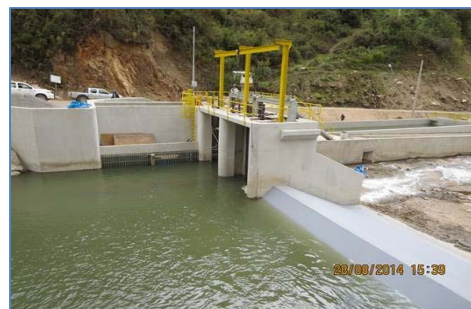
Bocatoma y Desarenador
