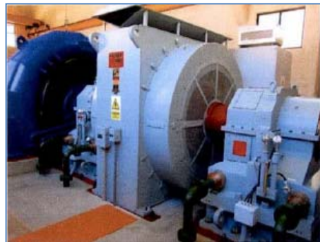
Grupo de Generación (Turbina Hidráulica Generador Eléctrico)
