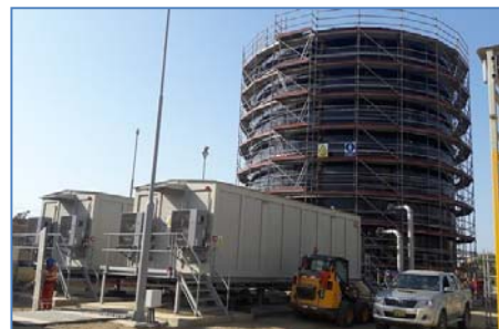
Avance de Obras
