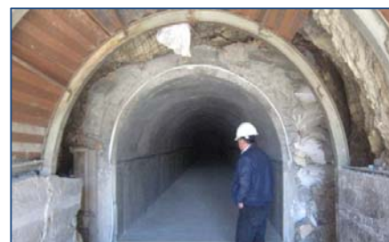
Vista del Túnel
