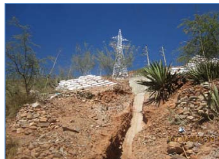
Buzón N° 8 y Torre N° 6 (Transición de Cable XLPE a Conductor Aéreo 138 kv), parte de la L.T. 138 kv Amarilis-Huánuco (L-1144)
