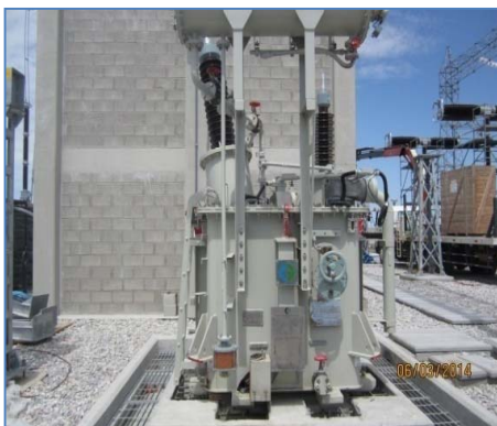
Reactor de PAT del neutro – Banco de reactores – 4 x 50 MVAR c/u
