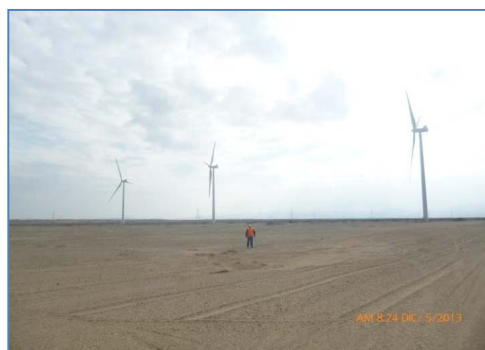
Vista de los aerogeneradores montados
