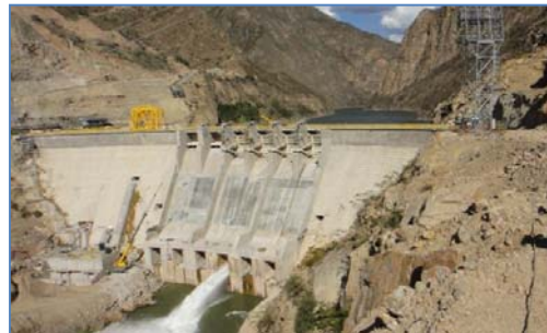
Vista posterior de la Presa
