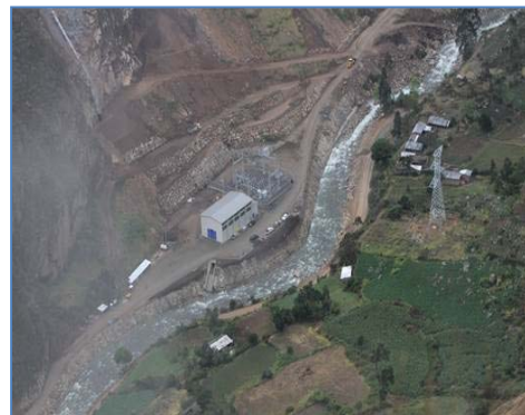
L.T. 220 kV SE Runatullo III – SE Concepción
