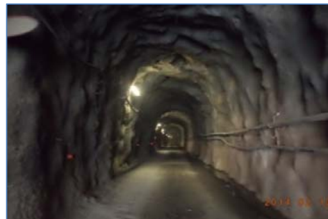
Túnel de Transferencia Huaura-Checras
