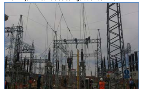
Trabajos de seccionamiento de celda 60 kV en S.E. Puno
