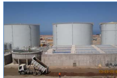
Tanque de Almacenamiento Combustible Diésel B5
