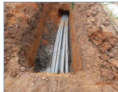
Tubería PVC para instalación de cables de energía en 10 kV
