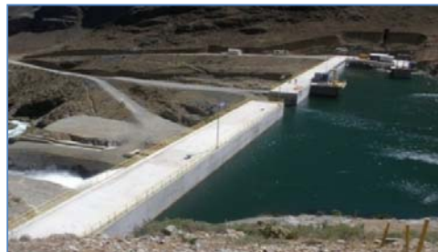
Presa Pallca y la Bocatoma
