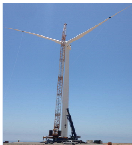
Montaje de Palas
