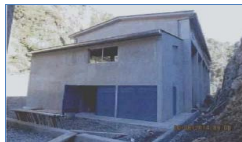
Construcción de la Casa de Máquinas
