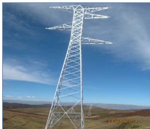
Vistas de Torres en la L.T.
