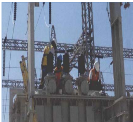
Montaje de bushing del Transformador de Potencia
