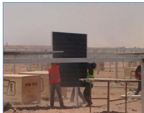
Instalación de Módulos Fotovoltaicos
