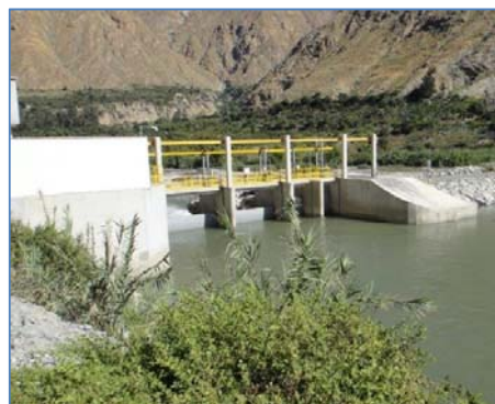
Vista de Bocatoma con sus compuertas radiales
