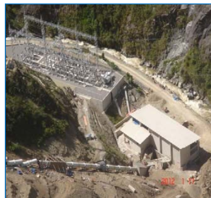
Casa de Máquinas y Tubería Forzada
