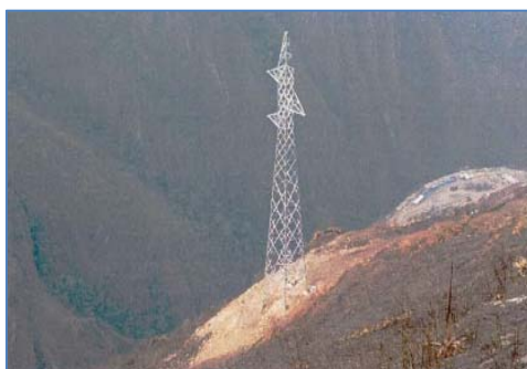
Montaje de Estructura metálica E4 concluido
