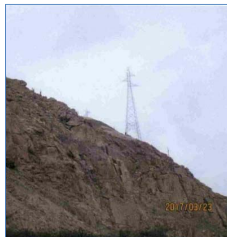
Instalación de torre N° 2
