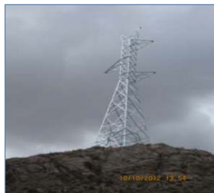
Torre N° 19 Tipo Angulo Anclaje (AA)
