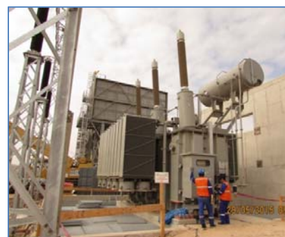
Montaje del Transformador de Potencia (S.E. Recka)
