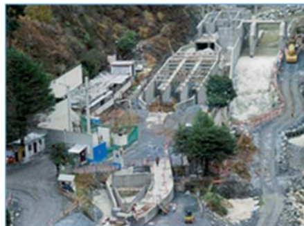
Barraje, Bocatoma, Desarenador y Canal de Conducción
