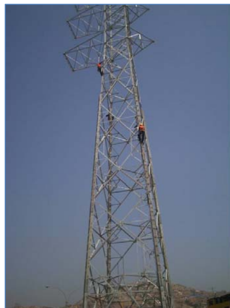
Montaje de Torre
