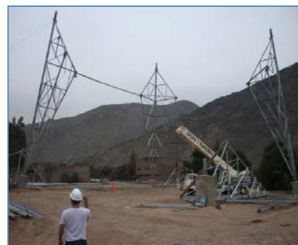
Montaje Súper Torre 170 m – 500 kV (cruce río Rímac)
