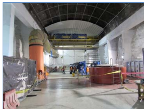
Casa de Máquinas (en caverna)
