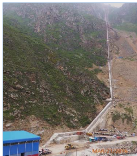
Tubería Forzada
