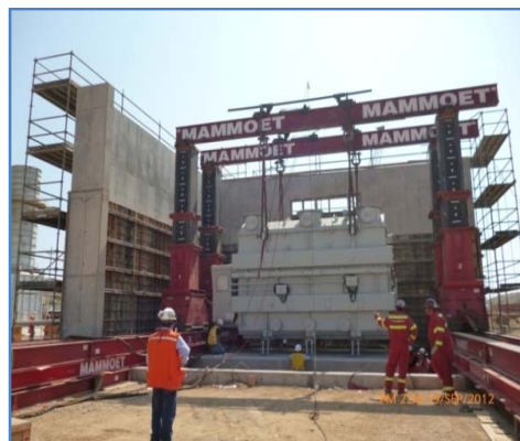
Montaje del Transformador de Potencia Concluido
