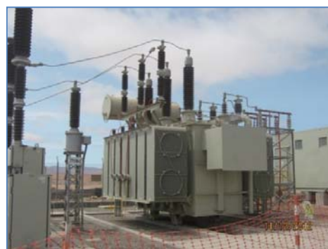
Transformador de Potencia de la S.E. Panamericana Solar
