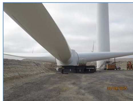
Montaje de Aspas
