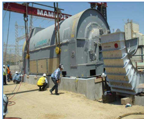
Montaje de Turbina a Gas y Generador
