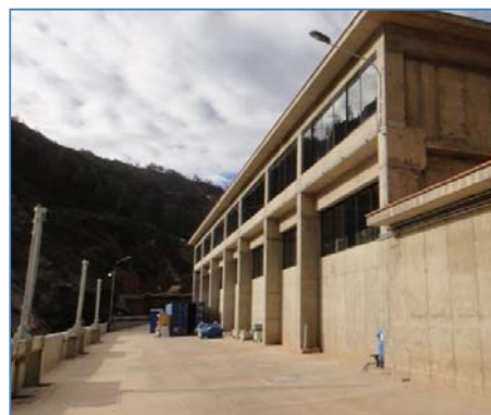
Casa de máquinas
