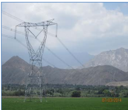
Torre N° 185 Tramo sector Limoncarro - Guadalupe
