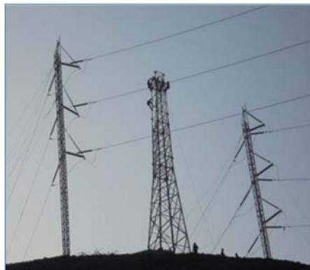
Desmontaje de Torre T44 de L-2246
