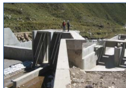
Vista panorámica Bocatoma
