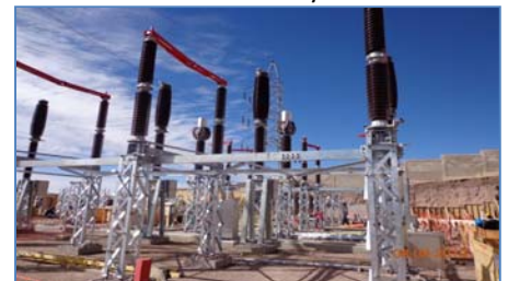
S.E. Ayaviri - Cambio de Configuración de “T” a “PI”
