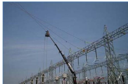
Conexión de la L.T. en la S.E. Chilca
