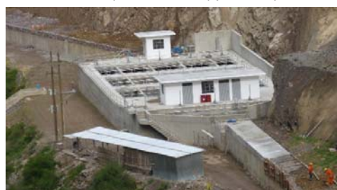
Vista Panorámica del Desarenador
