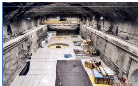
Vista de la Casa de Máquinas
