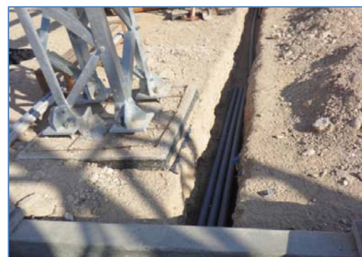
Trabajos en Subestación Marcona
