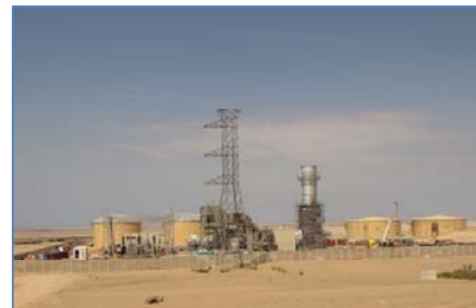
Vista panorámica de la central
