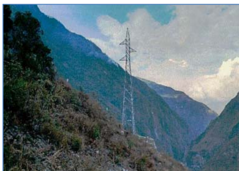
Montaje de Estructura E8 concluido
