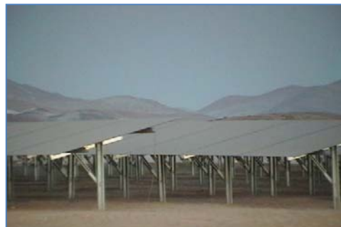
Instalación de Módulos Fotovoltaicos
