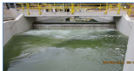
Vista del canal de conducción
