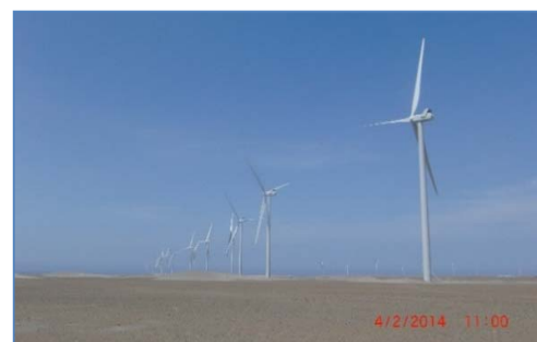
Vista de los Aerogeneradores montados
