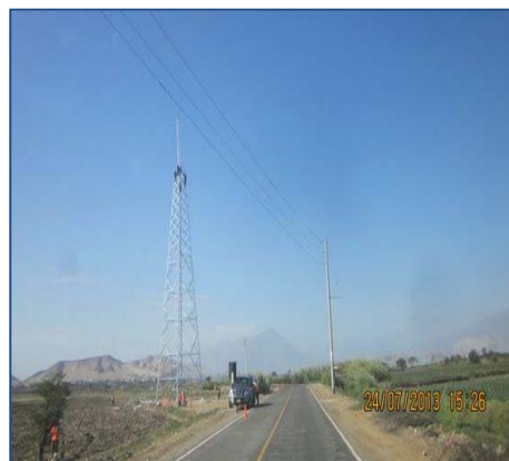
Vista de Montaje de la L.T.
