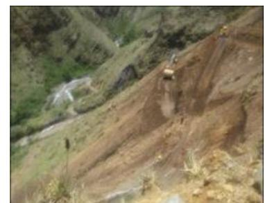
Limpieza a nivel de subrasante y perfilado de talud
