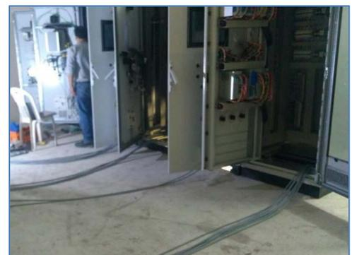
Cableado de equipo en Sala de Control
