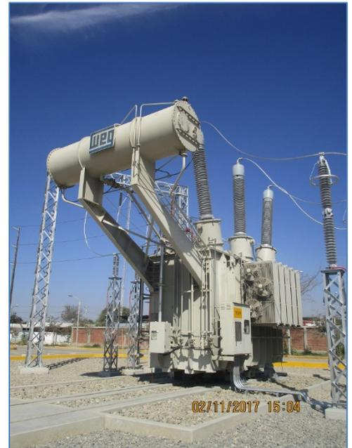
**Transformador provisional de 220/60 kv – 50 MVA**
