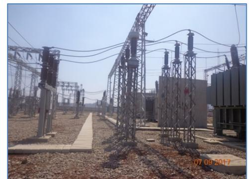
S.E. Guadalupe: cambio de configuración en 60 kv de simple a doble barra
