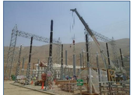
Montaje de Bushing en GIS 500 kV de la S.E. Carapongo
