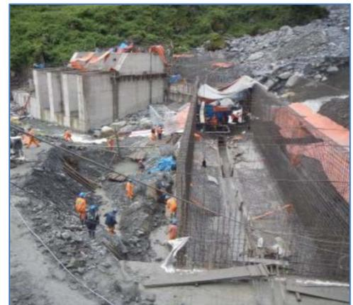
Desarenador: armado de acero de muros
