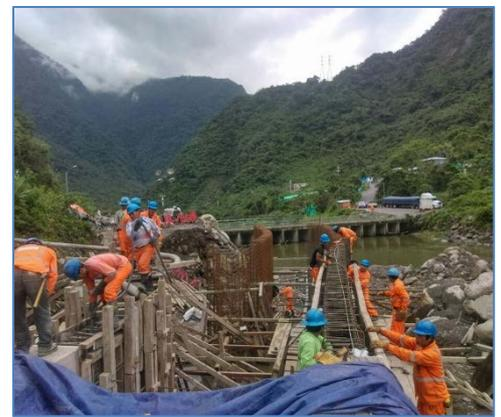
Vaciado de muros del canal de descarga
