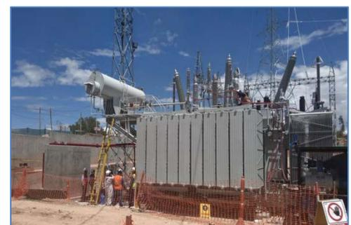
S.E. Mollepata: pruebas transformador de potencia
