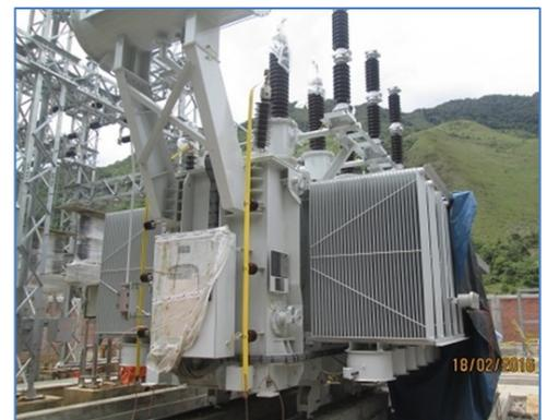
Montaje del Transformador de Potencia 55 MVA
