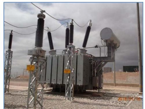
Transformador de potencia de 50 MVA
