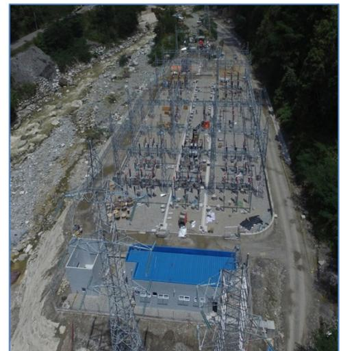
Subestación La Virgen 138 kV de doble barra
