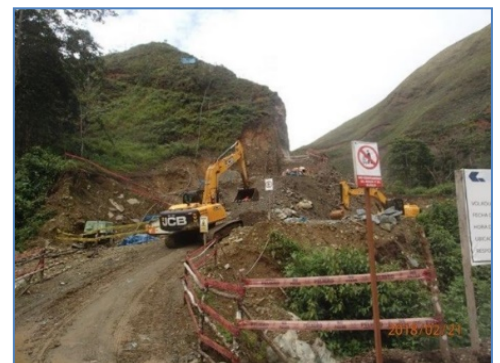
Excavación de la zona de conducción
