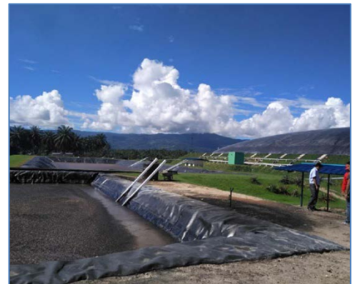
Planta de tratamiento de aguas residuales
