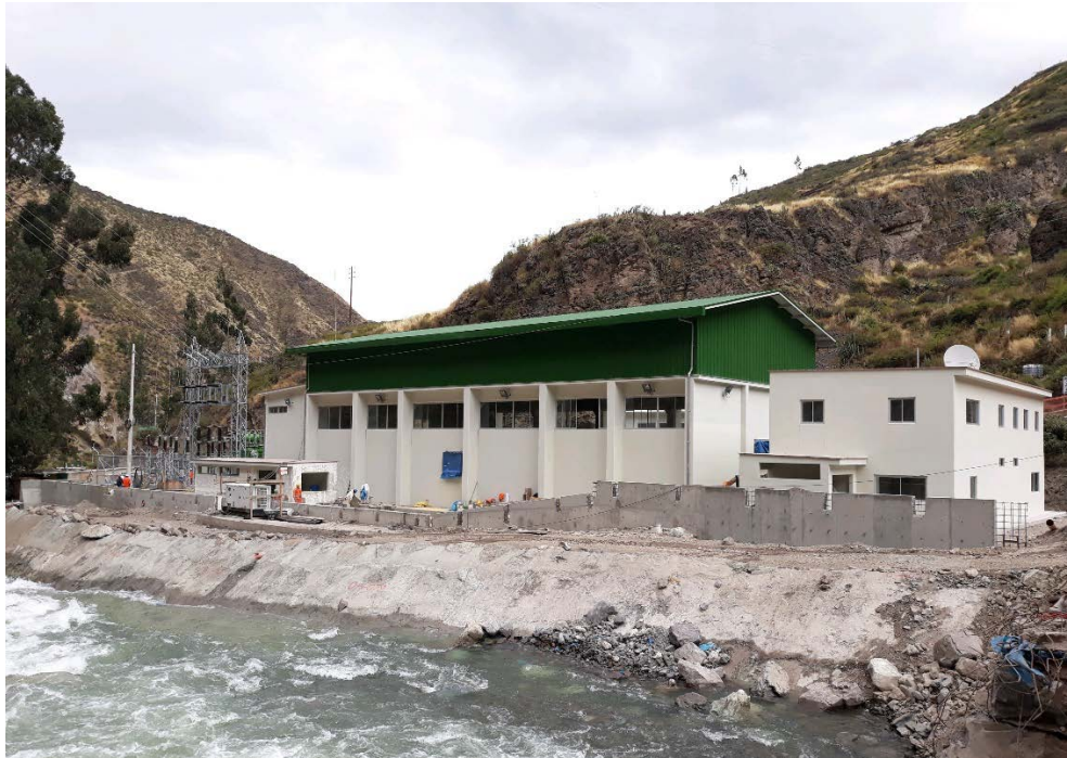
Ilustración 2: Casa de Máquinas y Patio de LLaves (C.H. Carhuac)
