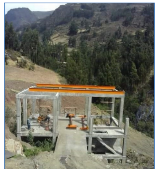
Casa de Máquinas
