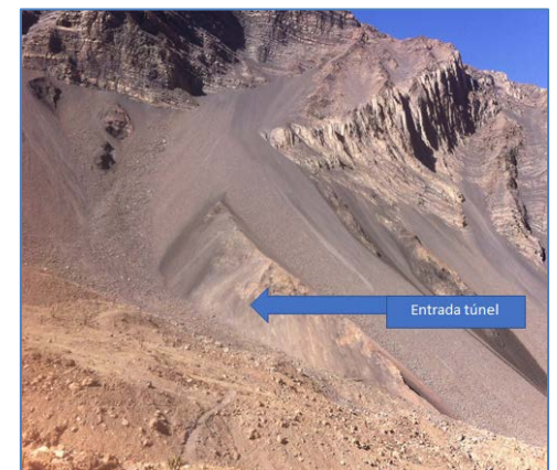
Entrada al Túnel de Conducción
