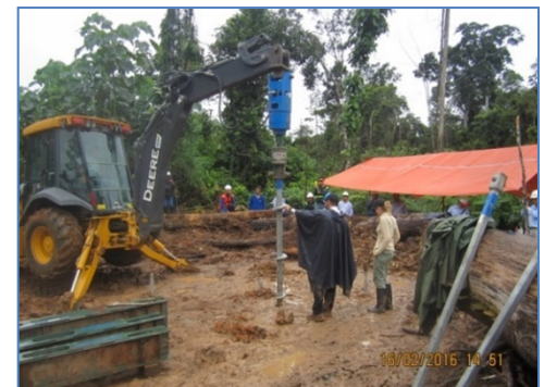
Prueba de pilotes helicoidales
