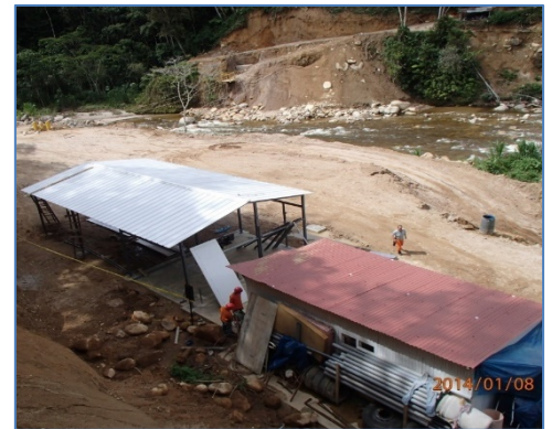
Construcción de campamento provisional
