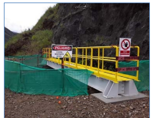
Pórtico de Izaje de Chimenea de Equilibrio
