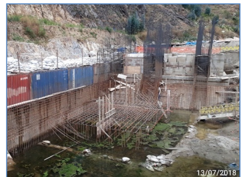
Bocatoma – Pilares de barrage móvil
