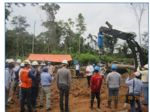
Prueba de pilotes helicoidales
