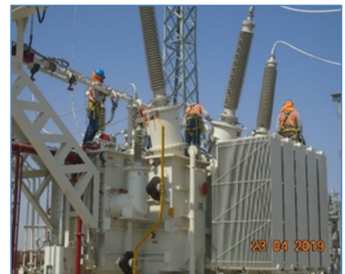
Limpieza y aplicación de pintura en zonas corroidas
