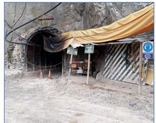
Ventana 3 – Ingreso a frentes 4 y 5 del Túnel
