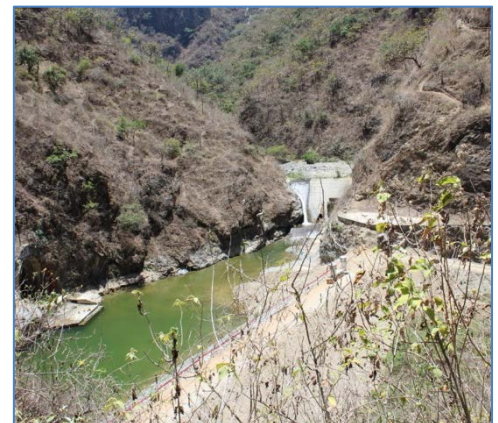
Vista de dique y salida de túnel trasandino
