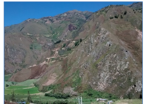
Zona de entrada al Túnel de Conducción
