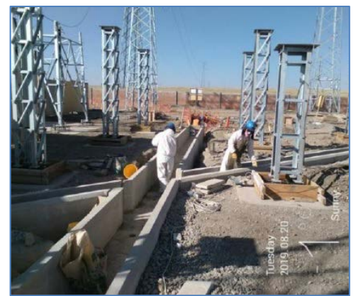
Acabado de canaletas en muros
