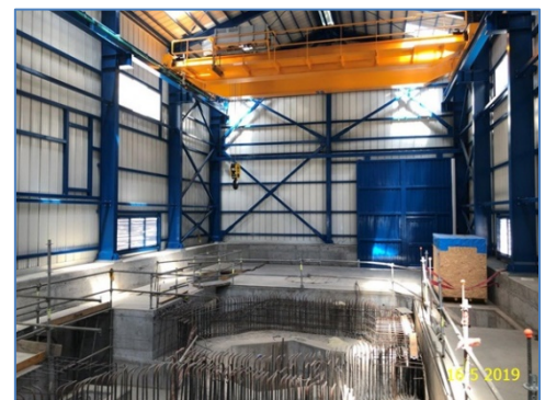
Interior de la Casa de Máquinas
