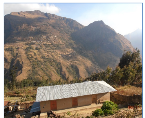
Zona de la Tubería Forzada
