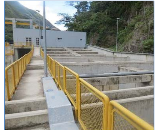
Dos Naves de Desarenadores
