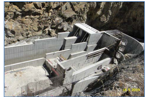
Construcción de la bocatoma
