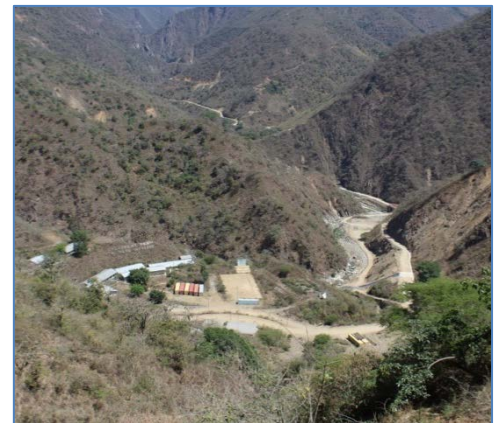
Vista aérea de caminos de acceso hacia Campamentos
