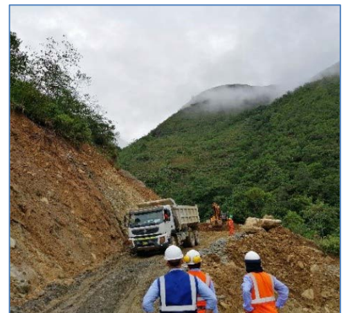
Camino de acceso a Bocatoma
