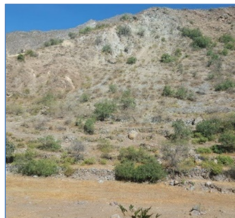
Zona de Tubería Forzada
