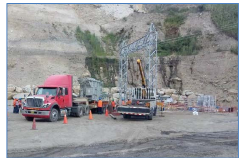
Obras en S.E. Manta
