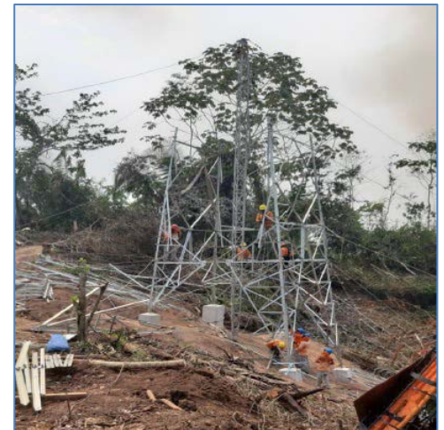
Montaje de torres
