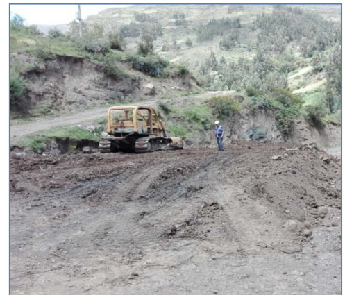
Excavación y explanación para Canal de Conducción
