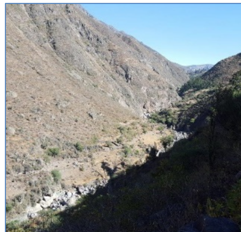
Primer tramo del Canal de Conducción
