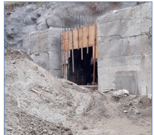
Inicio del Túnel de Aducción
