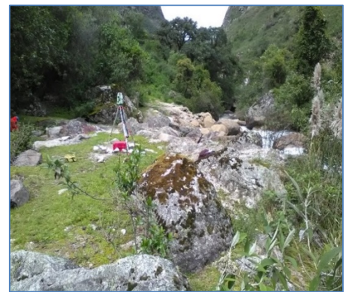
Replanteo de trazo topográfico
