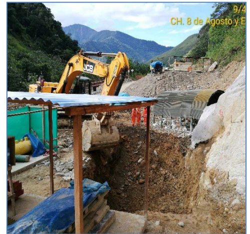
Pozo de sedimentación Túnel 2
