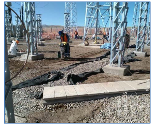
Explanación, relleno y compactación
