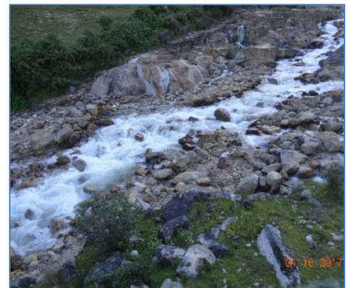
Vista ubicación de Toma H2 y Desarenador
