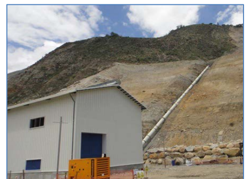
Vista de la Casa de Máquinas y Tubería de Presión
