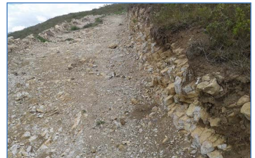
Acceso construido para estudio geotécnico
