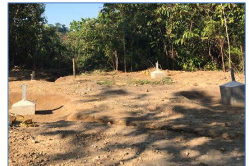
Releno y compactación de fundaciones
