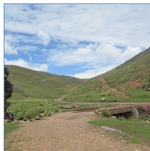
Zona de Presa, río Acco Acco
