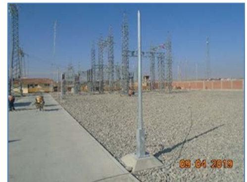
Montaje de postes para alumbrado
