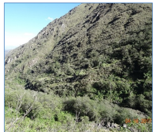
Vista panorámica de línea de conducción
