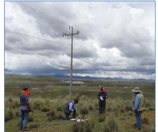
Medición de resistividad
