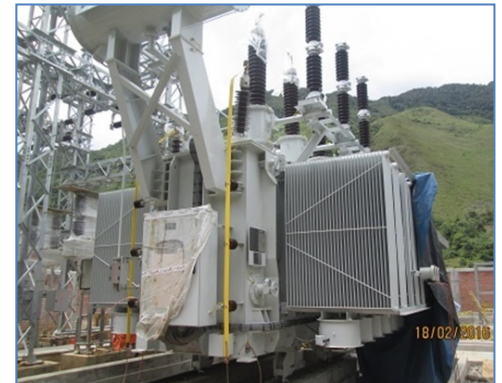
Montaje del Transformador de Potencia 55 MVA
