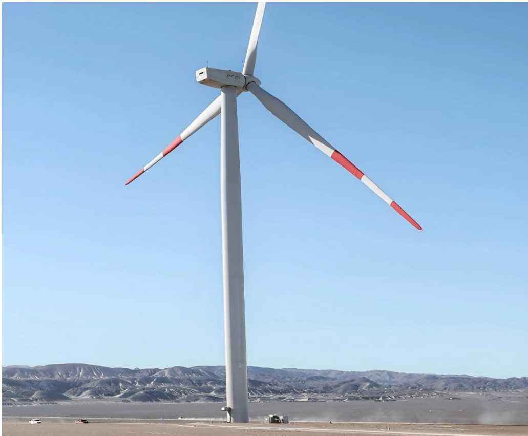
Foto: Aerogenerador (Central Eólica Wayra I 132,3 MW, Ica-Perú). Fuente: Osinergmin.
