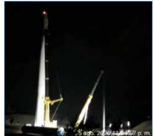
H2-Montaje T1-T2 concluido
