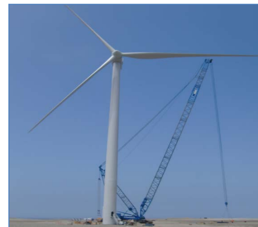
Montaje concluido del Aerogenerador
