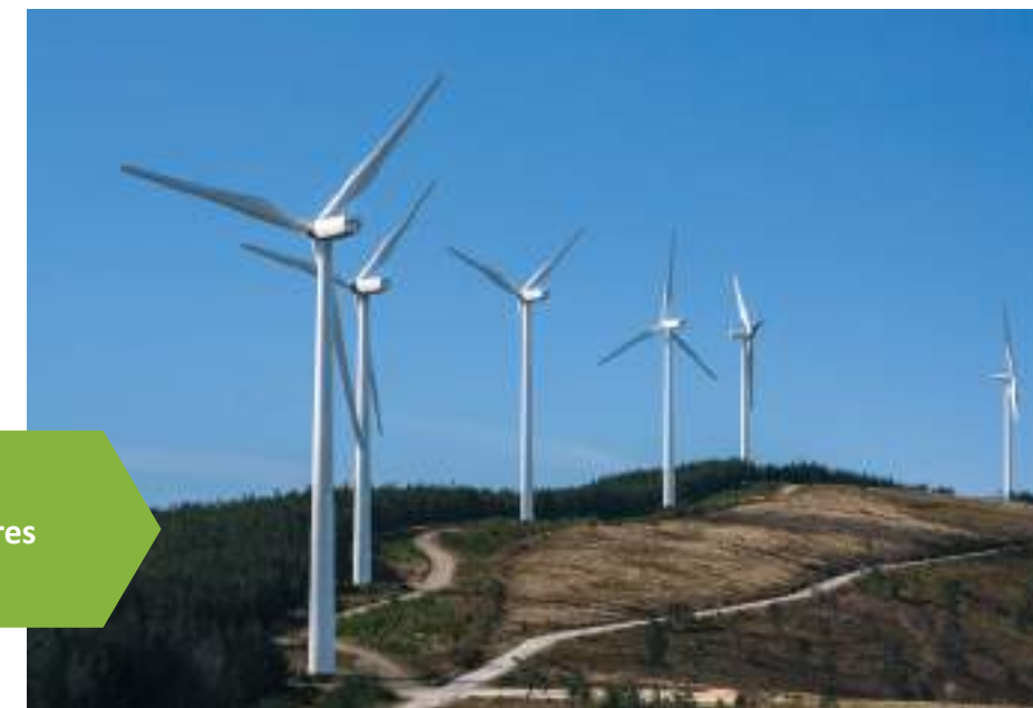
Turbinas eólicas (Portugal). Foto: Shutterstock.
