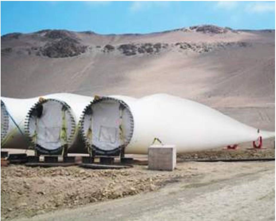
Aspas listas para montaje en la CE Tres Hermanas (Ica). Foto: Osinergmin.
