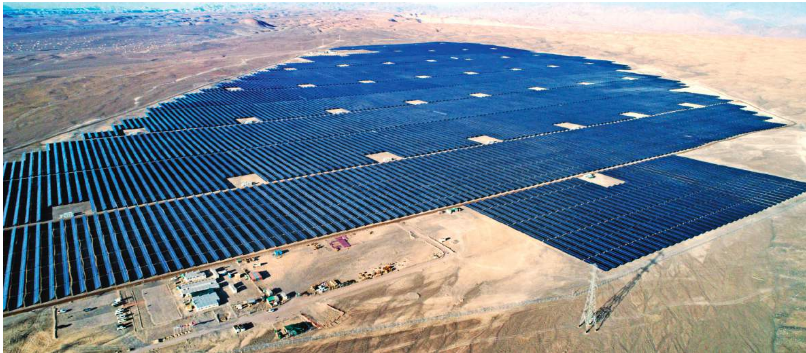
Vista aérea de la Central Solar Rubí (Moquegua). Foto: Osinergmin.
