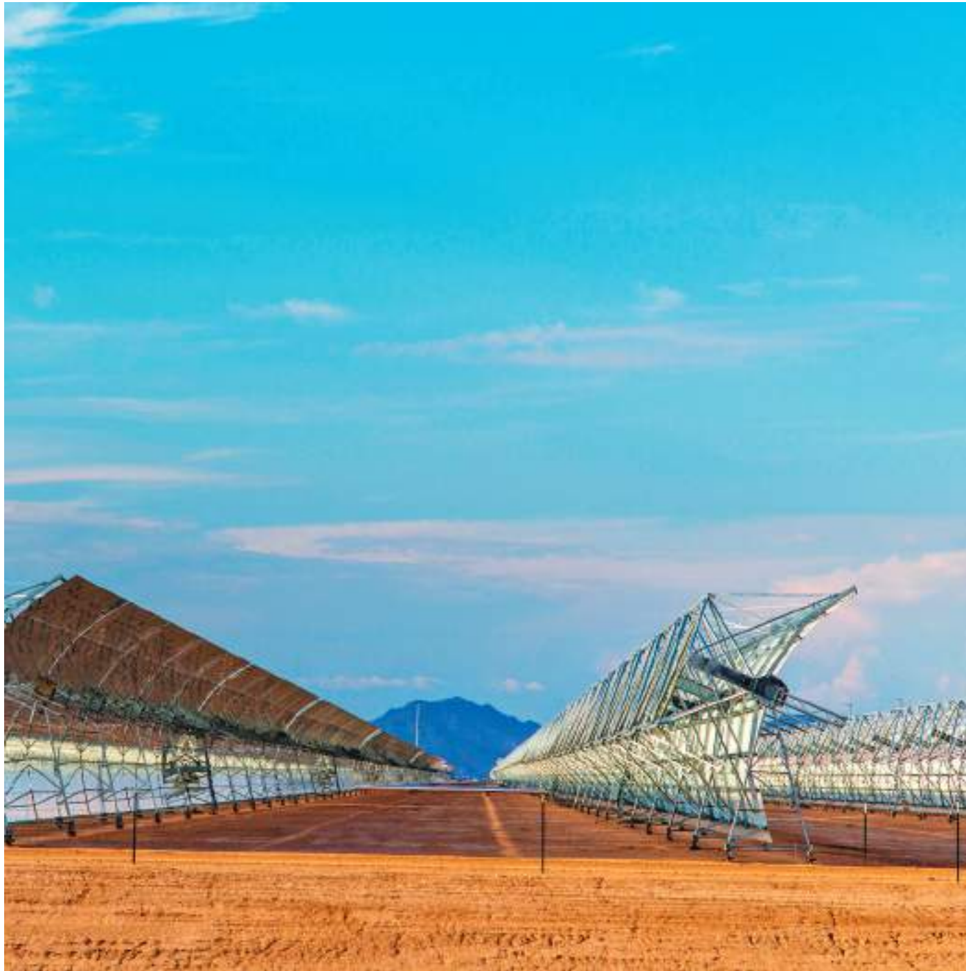
Planta de recolección térmica solar Solana (Arizona). Foto: Shutterstock.
