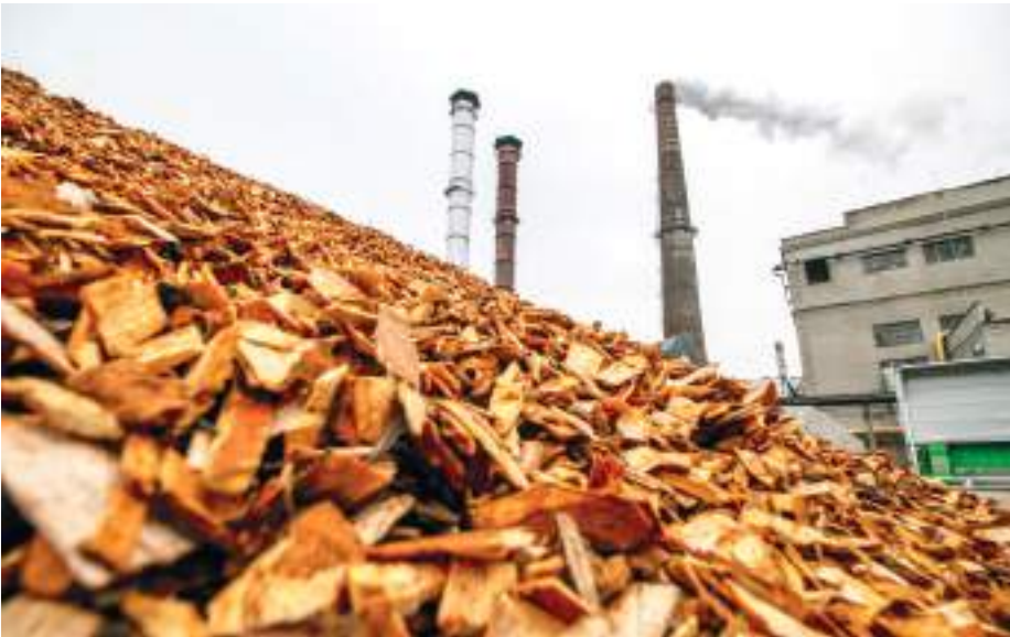
Central eléctrica de biomasa en Kaunas (Lituania). Foto: Shutterstock.
