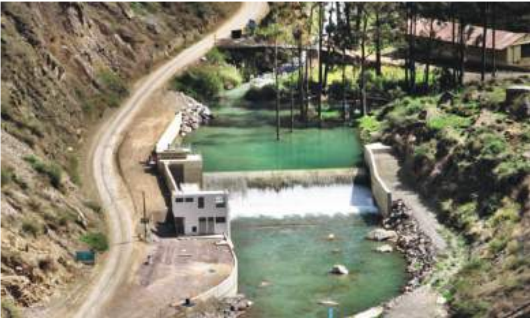
Bocatoma de la Central Hidroeléctrica Chancay (Lima). Foto: Osinergmin.
