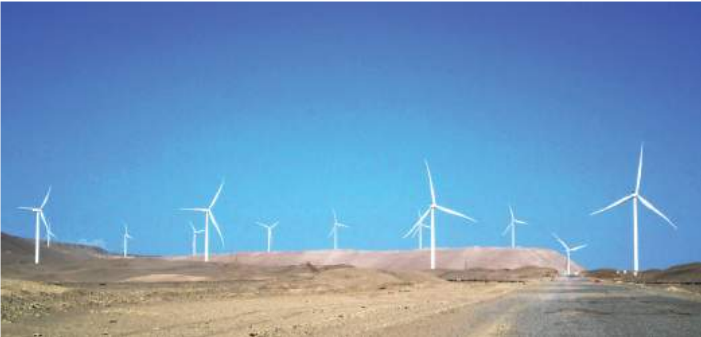
Aerogeneradores de la CE Tres Hermanas (Ica). Foto: Osinergmin.
