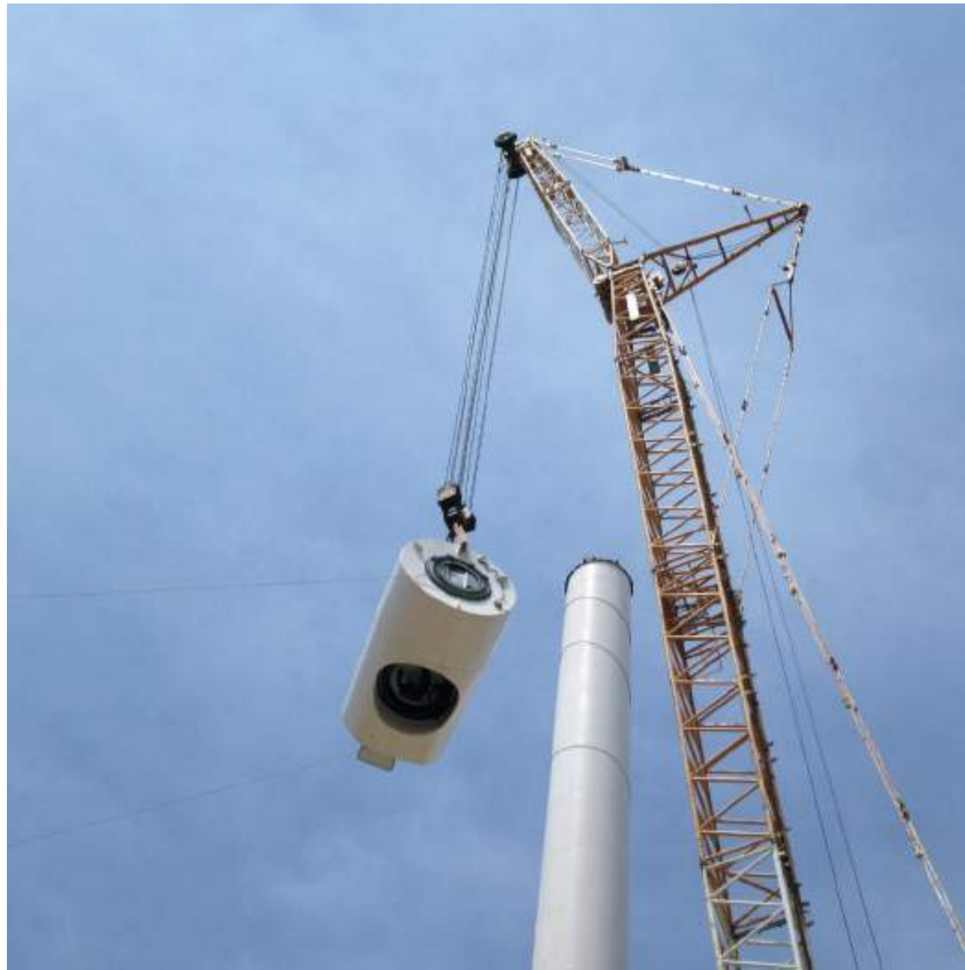
Montaje de una góndola o nacelle de la Central Eólica Tres Hermanas (Ica). Foto: Osinergmin.
