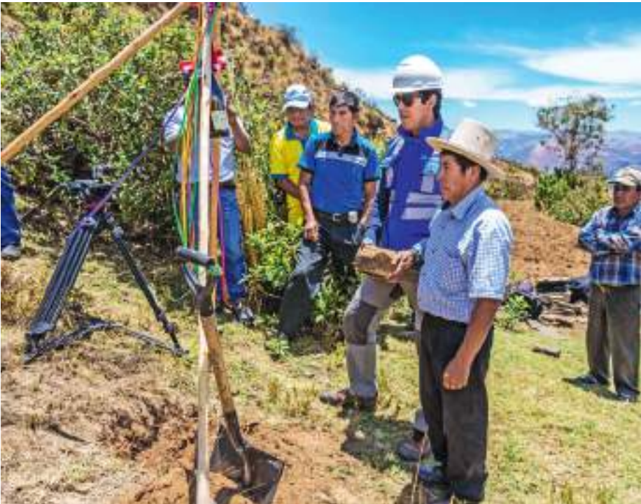
Primera piedra de Hydrika para la construcción de minicentrales hidráulicas (Áncash). Foto: IBT Group 15 .
