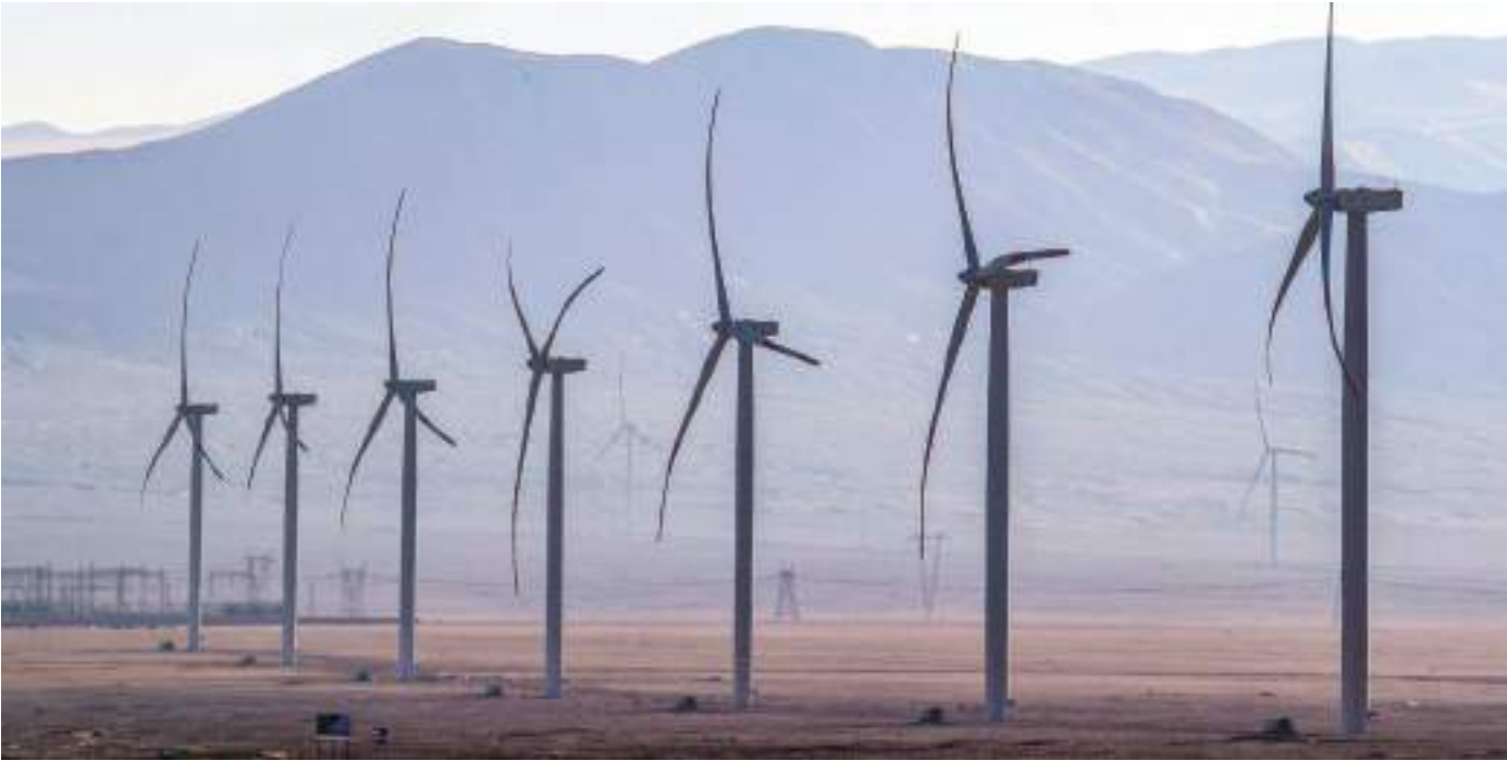
Aerogeneradores de la Central Eólica Wayra I (Ica). Foto: Minem.
