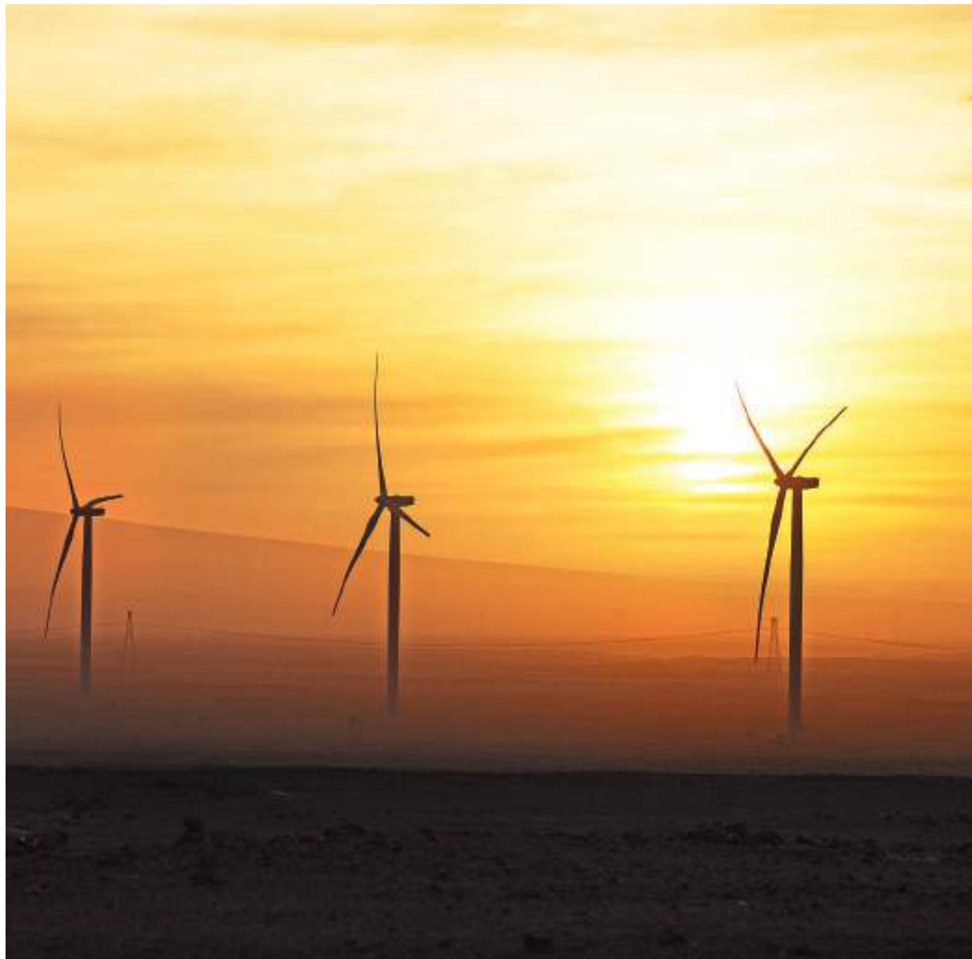
Fila de aerogeneradores de la Central Eólica Wayra I (Ica). Foto: Enel Perú.
