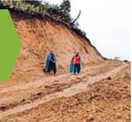
Trazo y replanteo de la CH Huatziroki I (Junín). Foto: Osinergmin.
