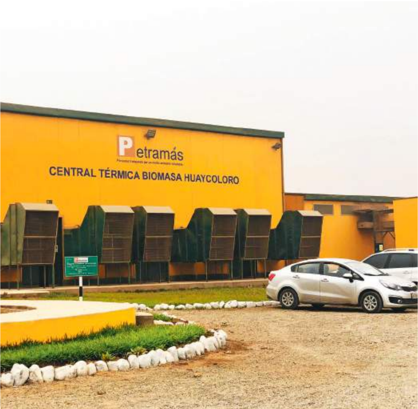
La Central de Biomasa Huaycoloro pertenece a la primera subasta y se encuentra actualmente en operación (Lima). Foto: Sociedad Peruana de Renovables (Petramás).
