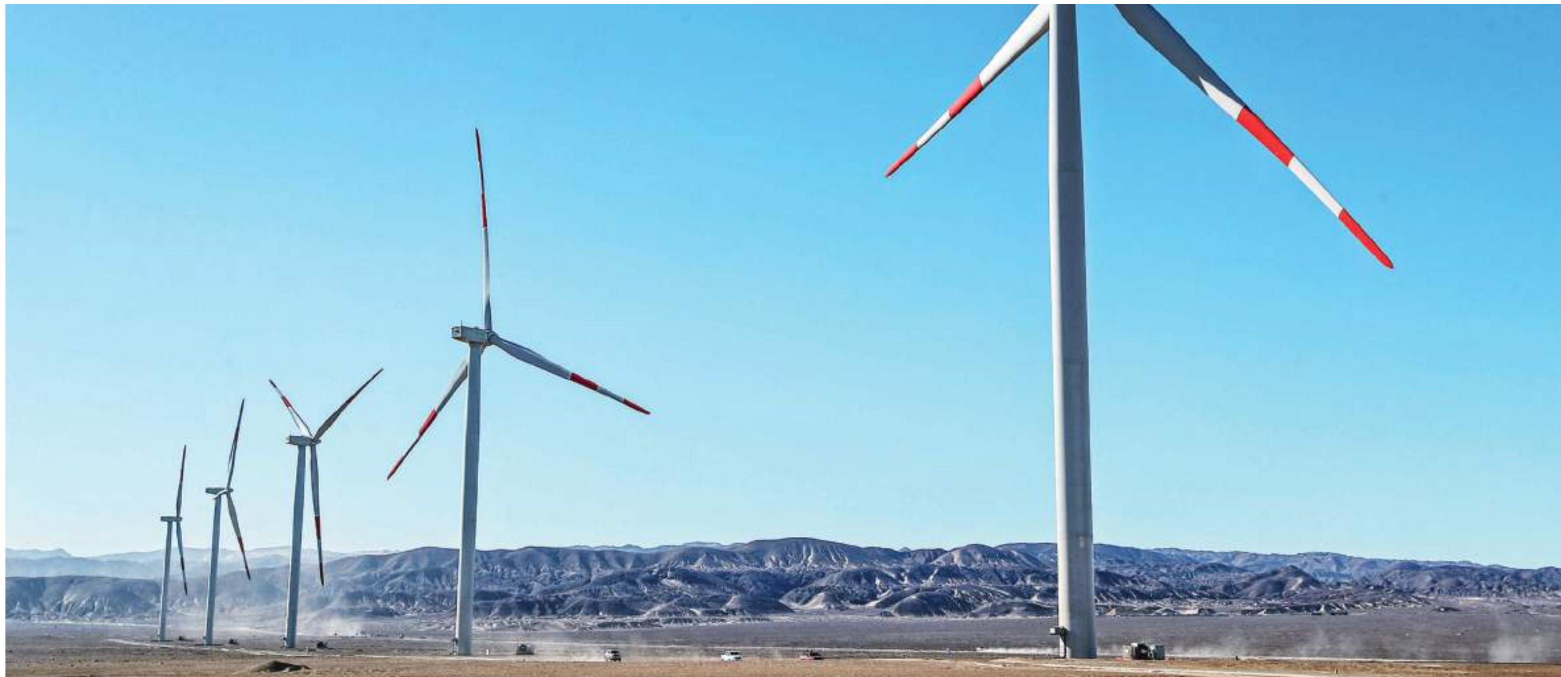
Fila de aerogeneradores de la Central Eólica Wayra en Nazca (Ica). Foto: Minem.
