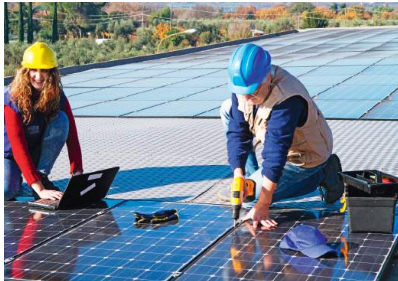
Instalación de un panel fotovoltaico. Foto: Shutterstock.
