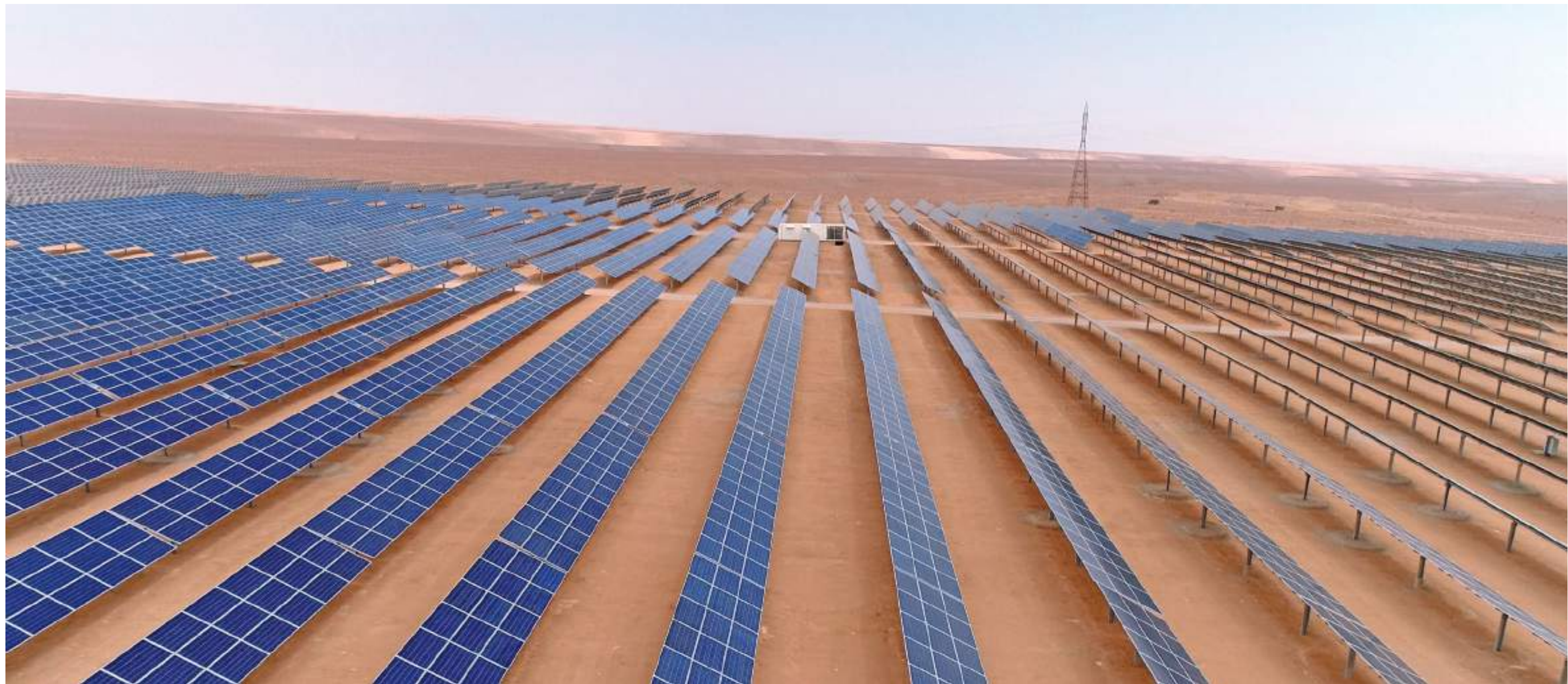
Paneles fotovoltaicos de la Central Solar Intipampa (Moquegua). Foto: Engie Energía Perú.
