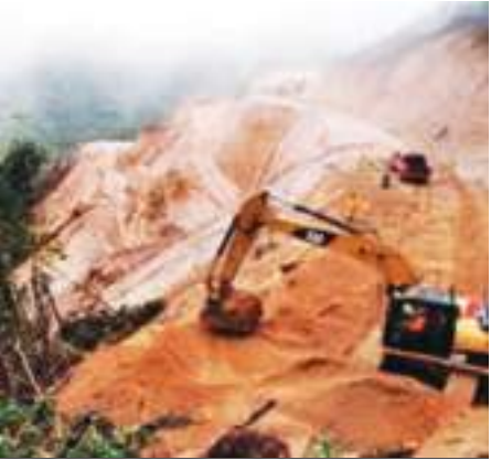
Apertura de trocha de acceso a la casa de máquina de Central Hidroeléctrica Huatziroki I (Junín). Foto: Osinergmin.
