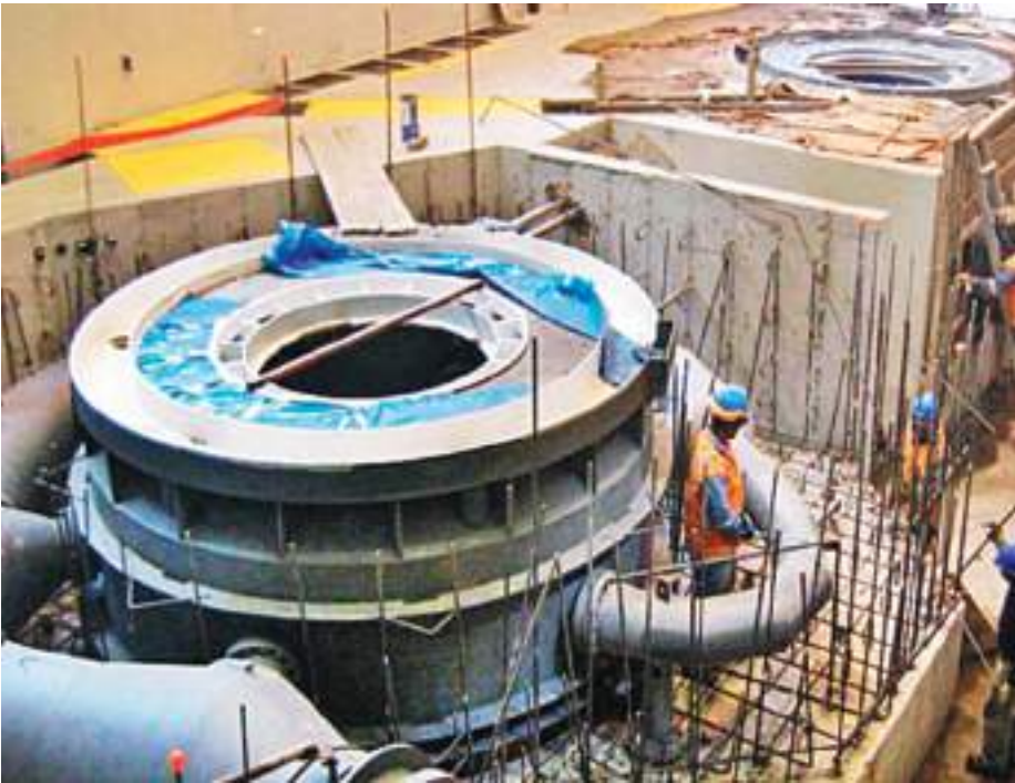
Cimentación del generador y la turbina de la Centra Hidroeléctrica Runatullo II (Junín). Foto: Osinergmin.
