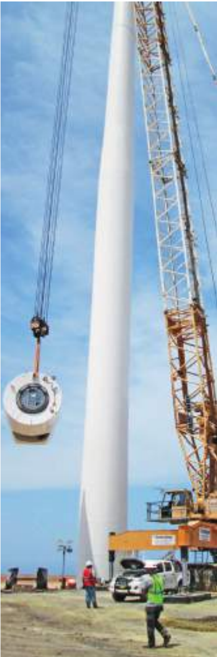
Izaje de una nacelle de la Central Eólica Tres Hermanas (Ica). Foto: Osinergmin.
