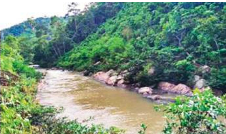
Zona de bocatomas de la Central Hidroeléctrica Shima (San Martín). Foto: Osinergmin.
