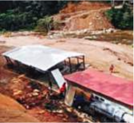
Construcción de campamento tradicional de la CH Huatziroki I (Junín). Foto: Osinergmin.
