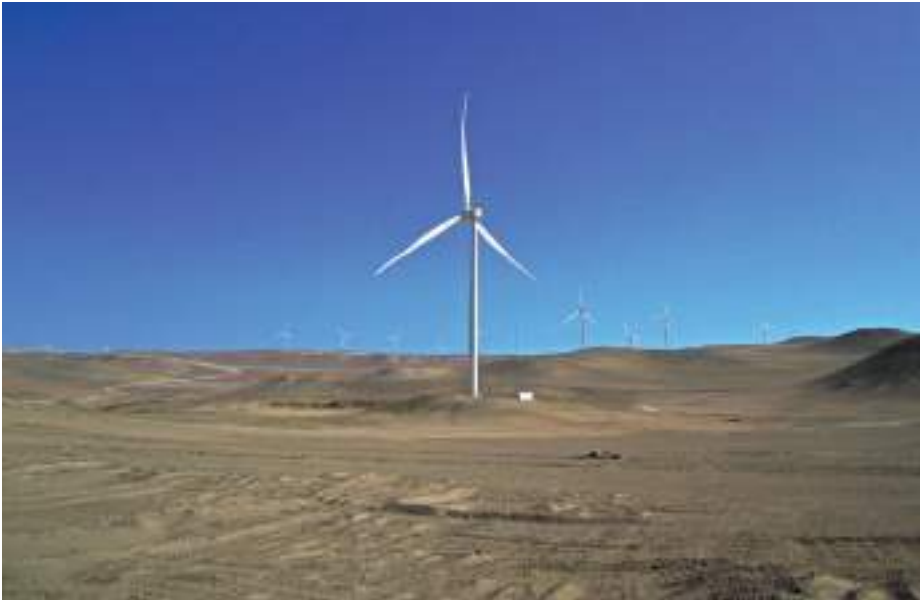
Aerogenerador de la Central Eólica Tres Hermanas (Ica). Foto: Osinergmin.
