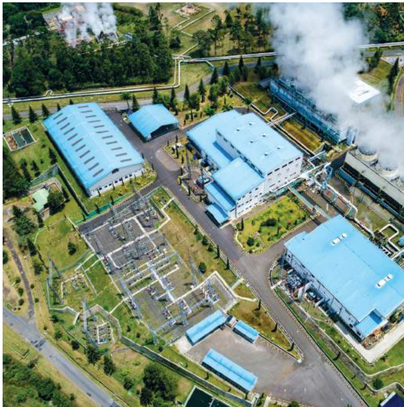
Vista aérea de la planta geotérmica de Kamojang (Indonesia). Foto: Shutterstock.
