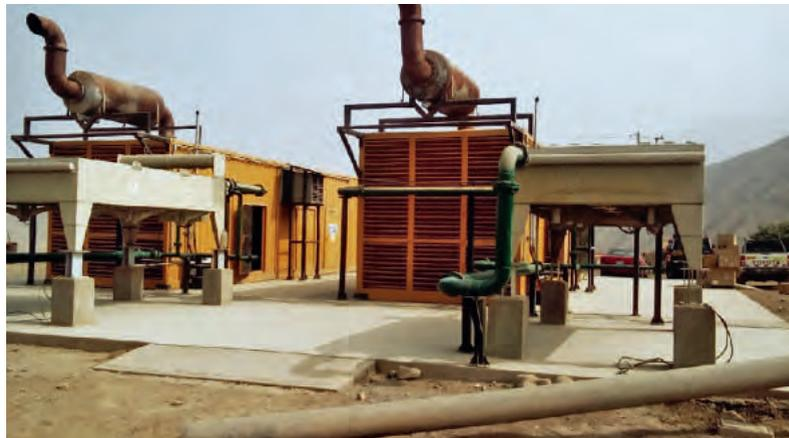
Foto: Biomasa La Gringa, Sistema de enfriamiento de motores-Peru. Fuente: DSE-Osinergmin.
