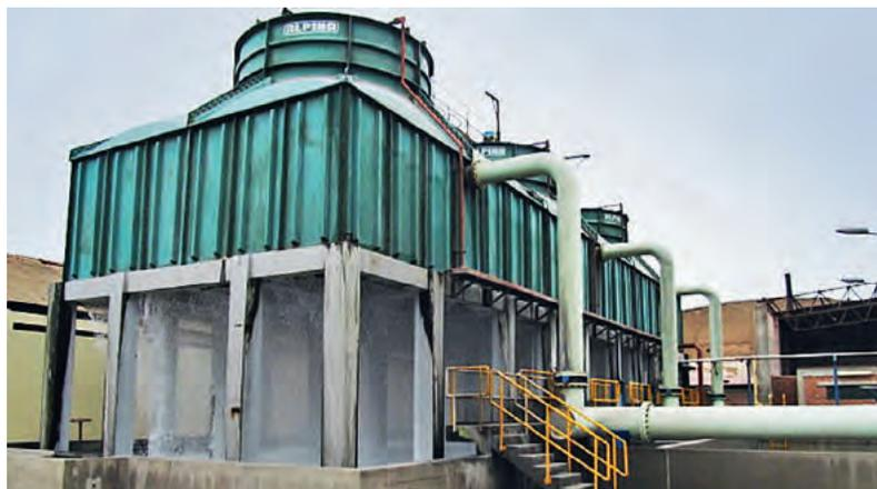
Foto: Biomasa Paramonga, radiadores del sistema de refrigeración de TV1-Peru. Fuente: DSE-Osinergmin.
