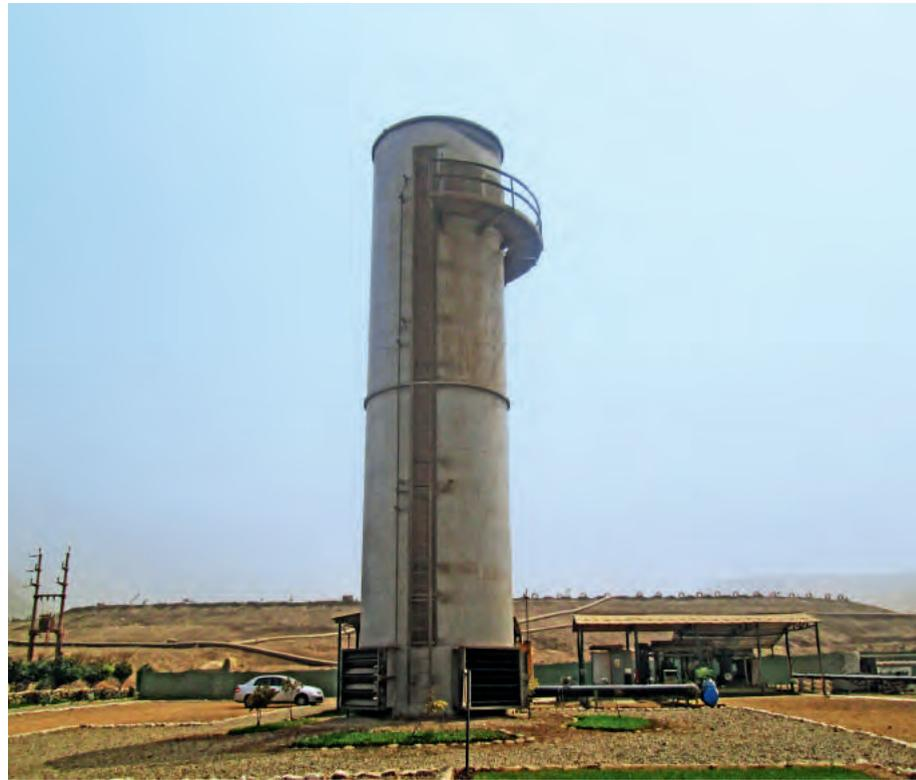
Foto: La Gringa V, Perú. Estación de quemado de excedentes de biogás. Fuente: Osinergrmin.
