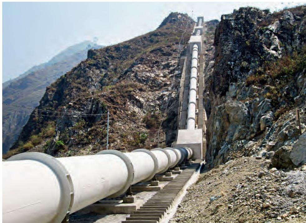
Foto: Mini Hidro-Huasahuasi (tubería forzada HHI). Fuente: Shutterstock.
