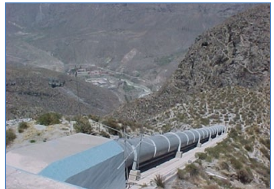
Tubería forzada
