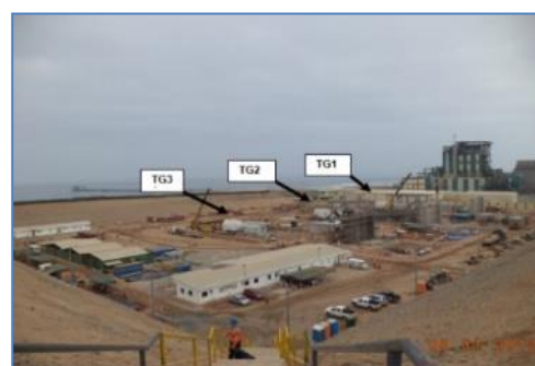
Vista panorámica de la construcción de la Central
