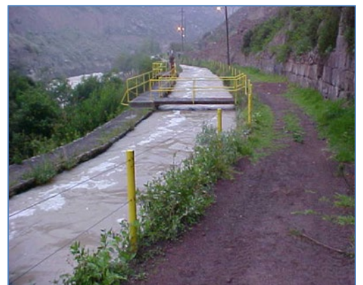
Canal de Aducción
