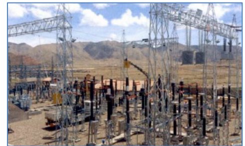
Trabajos de desconexión de bajantes provisionales en barra 138 kV de S.E. Ayaviri
