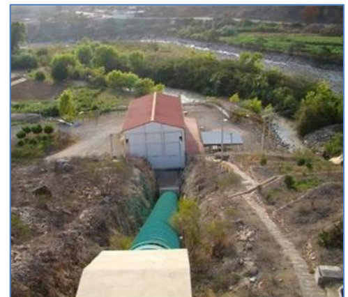
Tubería de Presión
