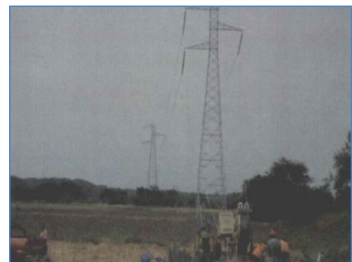
Estructura de la L.T concluida
