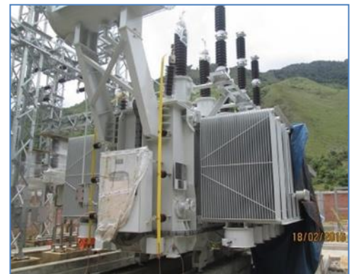
Montaje del Transformador de Potencia 55 MVA
