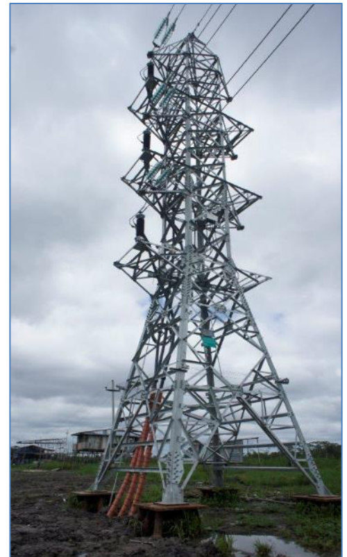
Torre de transición del tramo aéreo al subterráneo
