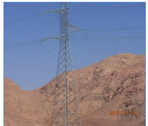
Torre de Línea de Transmisión
