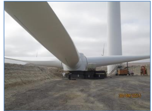
Montaje de Aspas
