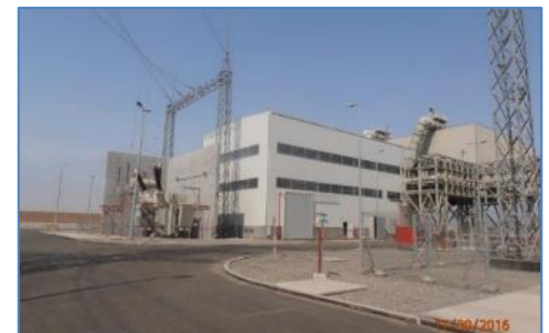
Nave de Turbina-Generador a Vapor
