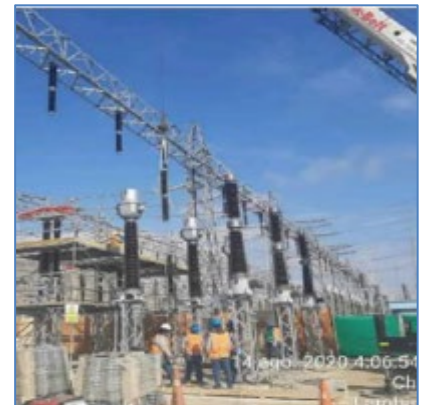
Montaje de seccionador pantógrafo en S.E. Reque
