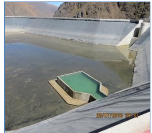
Reservorio de regulación Rapacán
