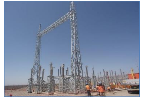
Montaje electromecánico de la S.E. Flamenco
