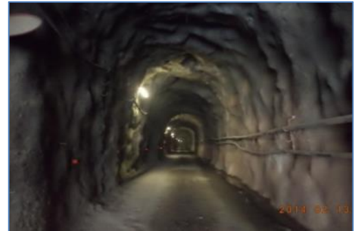
Túnel de Transferencia Huaura-Checras
