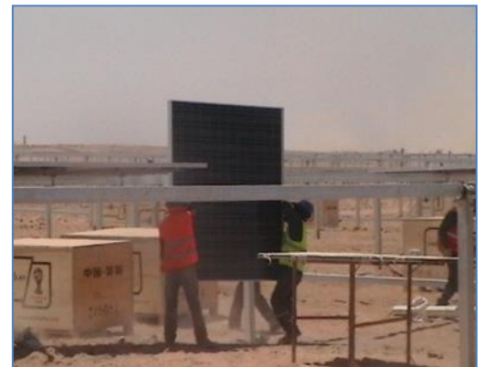
Instalación de Módulos Fovoltáicos
