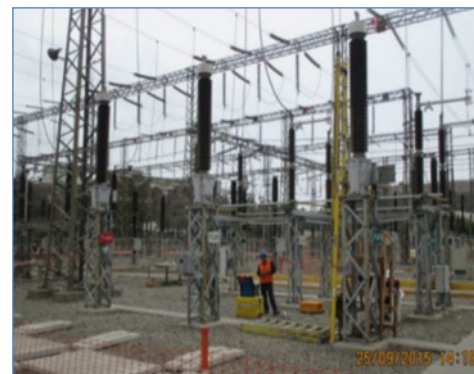
Pruebas SAT en Equipos Primarios (S.E. Ventanilla)
