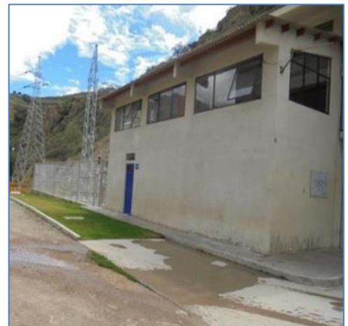
Casa de Máquinas
