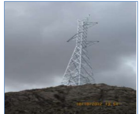
Torre No 19 Tipo Angulo Anclaje (AA)
