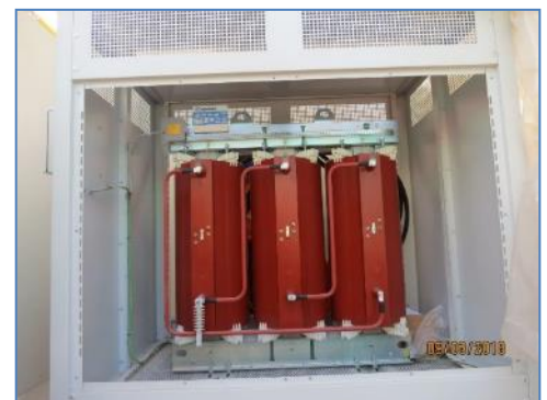
Transformador trifásico seco 0,4/10 kV
