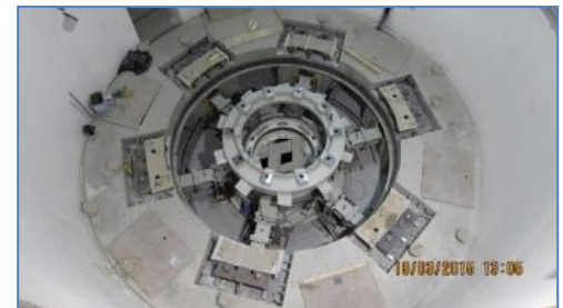
Trabajos previos al montaje del Generador N° 2
