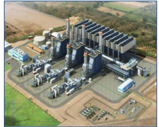
Vista General de la central
