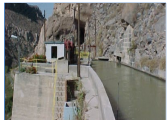
Cámara de Carga
