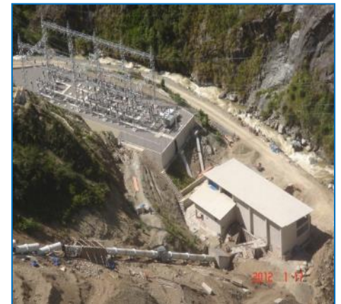
Casa de Máquinas y Tubería Forzada
