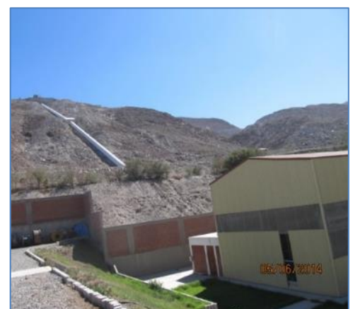
Casa de Máquinas
