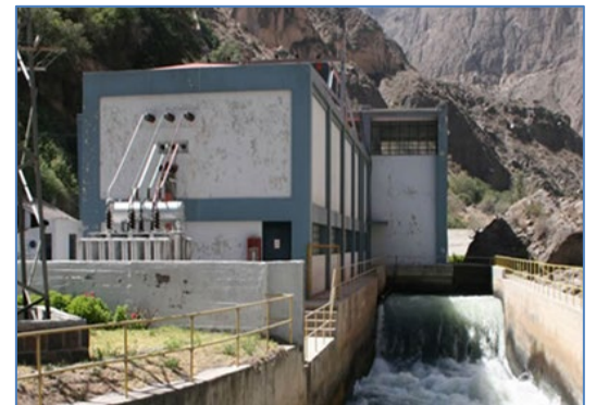
Salida de agua turbinada
