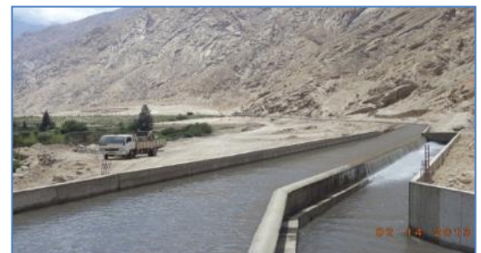
Canal de Conducción Concluido
