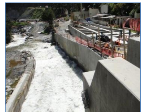
Canal de Descarga y Desarenador
