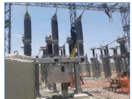
Siliconado de equipos de patio S.E. Reque
