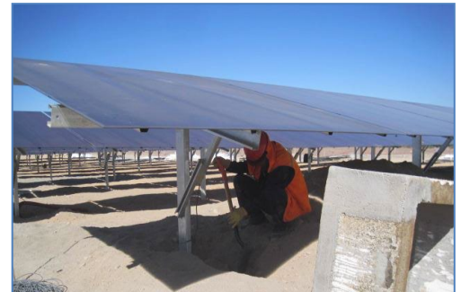
Disposición Final de Módulos Fotovoltaicos
