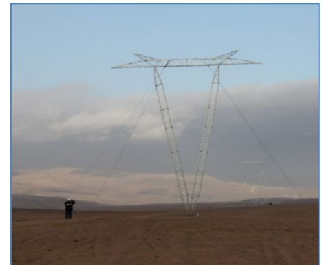
Torres tipo VSL Suspensión Atirantada (Ocoña – Montalvo)
