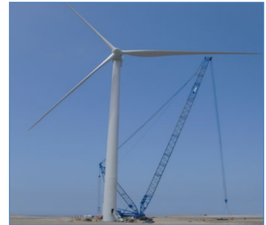
Montaje concluido del Aerogenerador
