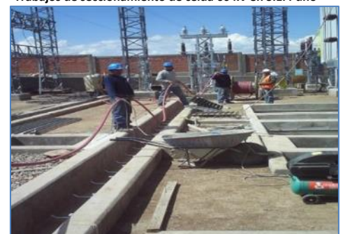
Tendido de cable de potencia 70 mm 2 Trafo T53-162 - Celda 22.9 kV en S.E. Puno
