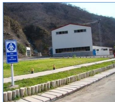
Casa de Máquinas
