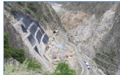
Patio de Llaves S.E. Cerro del Águila
