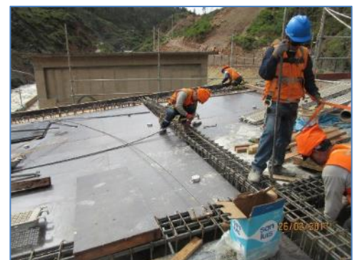
Techo S.E. Marañón
