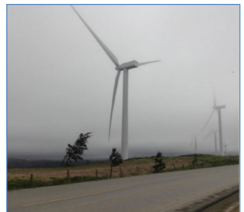
Aerogenerador D6 Y D7
