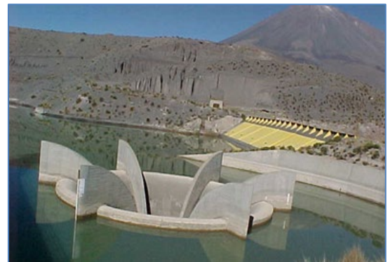
Reservorio Aguada Blanca
