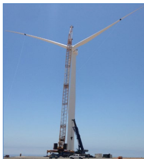
Montaje de Palas
