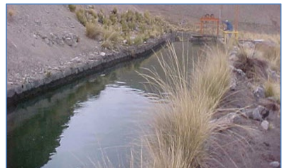
Cámara de Carga
