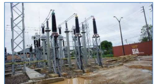
Llegada de conductores a S.E. Iquitos ELOR
