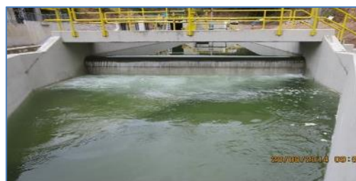
Vista del canal de conducción
