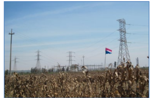
Trabajos durante la etapa de replanteo
