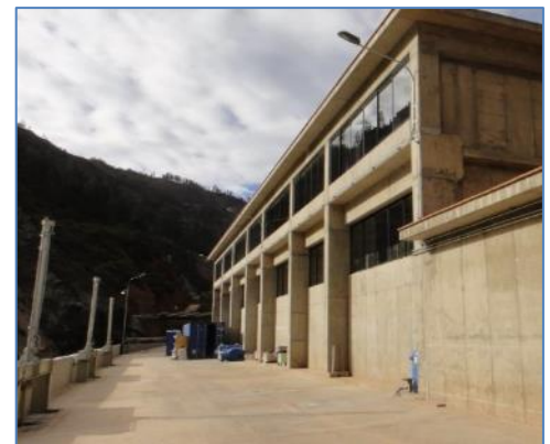
Casa de Máquinas
