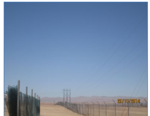
Vista de los postes de madera
