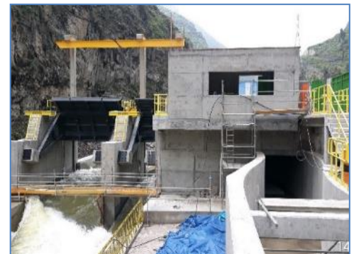
Barraje de Bocatomá y Sala de Control
