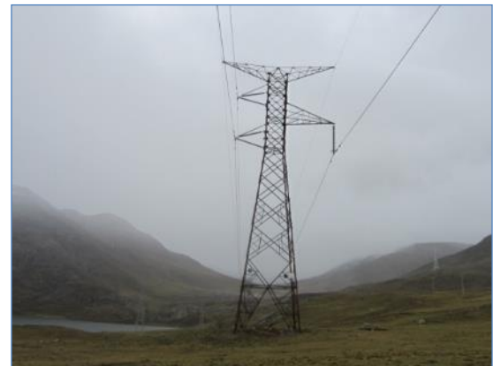
Torre de la LT 220 kV Pachachaca – Pomacocha (Ampliación de capacidad de 152 MVA a 250 MVA)
