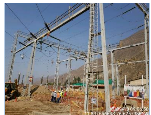
Avance de obras en S.E. Callahuanca
