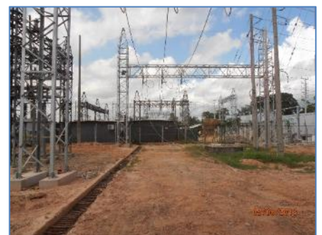
Vista de la Primera Torre
