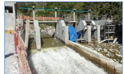
Ejecución de la Segunda Fase del Barraje Móvil
