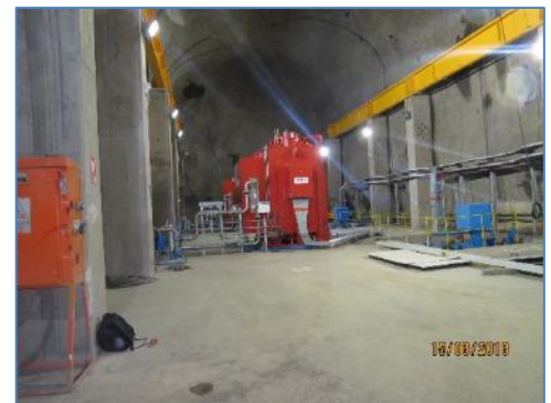
Casa de máquinas concluida
