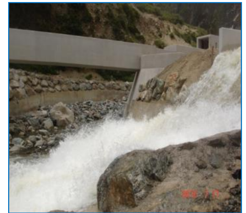
Puente Canal Huasahuasi II
