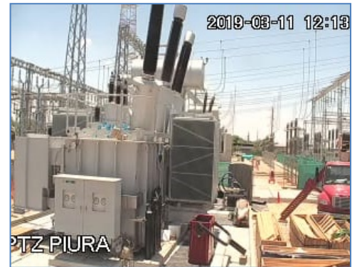
Montaje del transformador de 100 MVA
