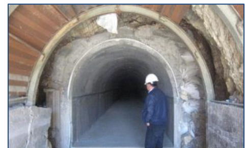
Vista del Túnel
