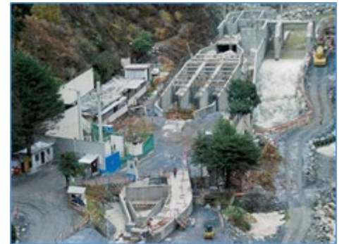
Barraje, Bocatoma, Desarenador y Canal de Conducción
