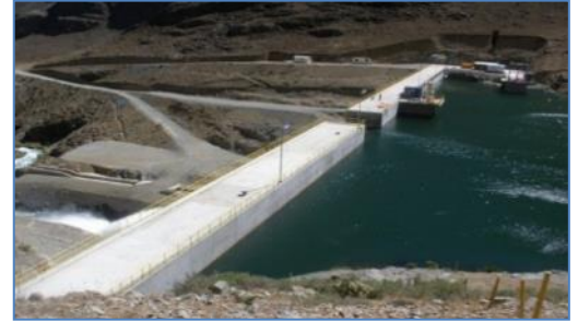
Presa Pallca y la Bocatoma
