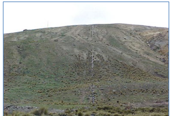
Tubería a presión
