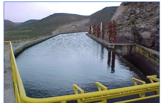
Cámara de Carga
