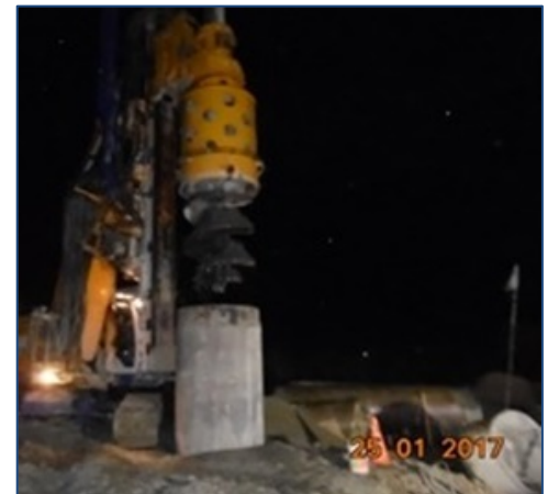
Perforación para estructura T08 (Hito d)
