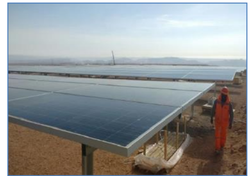
Montaje de paneles solares
