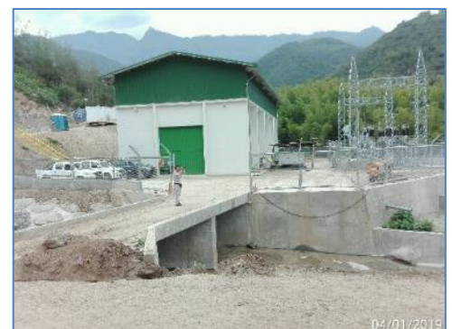
Casa de Máquinas
