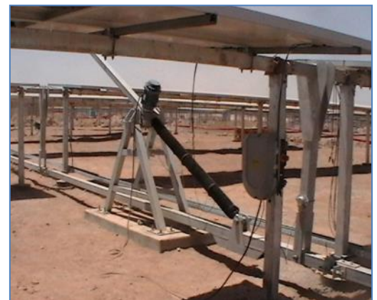
Instalación de Seguidor Solar
