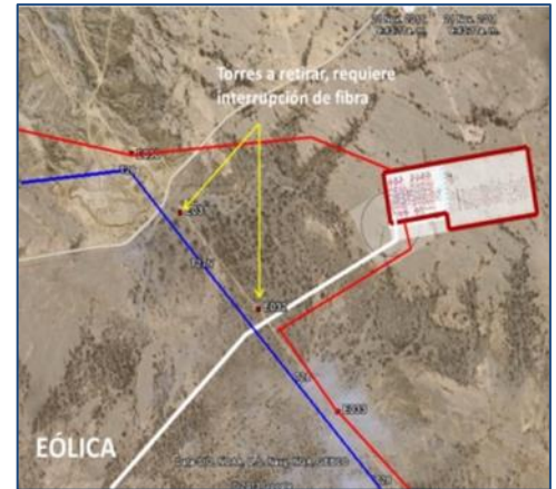
Ubicación de la Subestación
