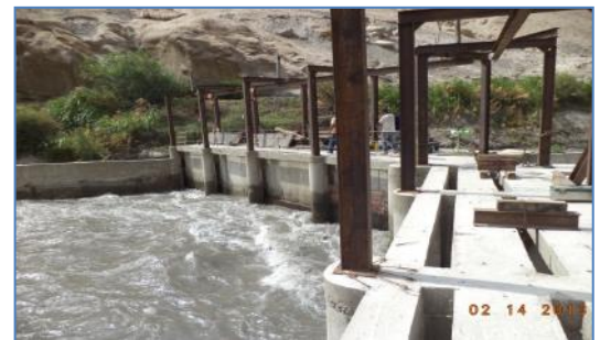
Obra de Captación
