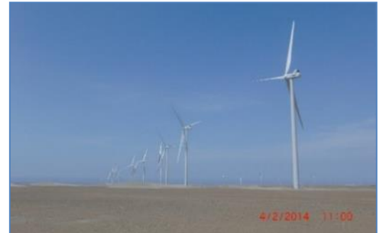
Vista de los Aerogeneradores montados
