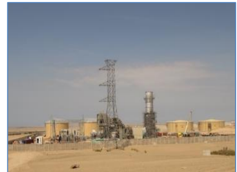
Vista panorámica de la central
