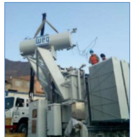
Montaje de Tanque de transformador en S.E. Huánuco
