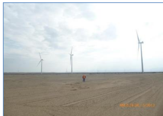
Vista de los aerogeneradores montados
