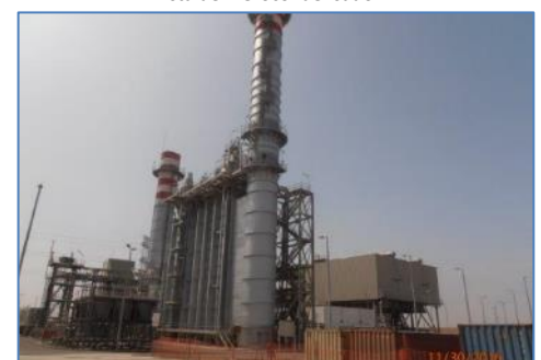
Vista de la C.T. Chilca 2
