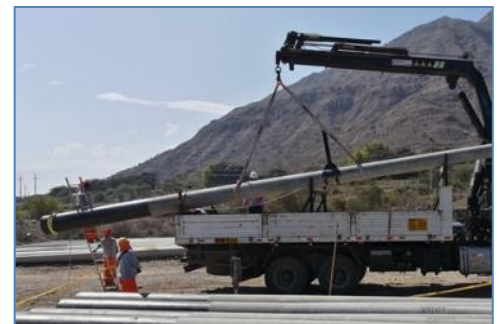
Transporte de postes para su montaje
