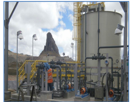
Vista general de las instalaciones
