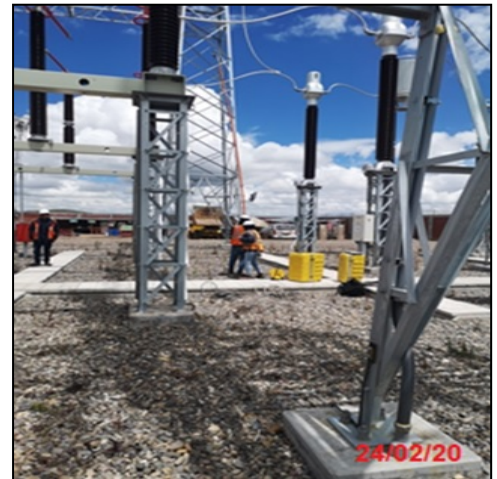
Ejecución de Pruebas en Patio de Llaves de S.E. Puno
