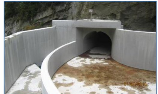
Ingreso al Túnel N° 1
