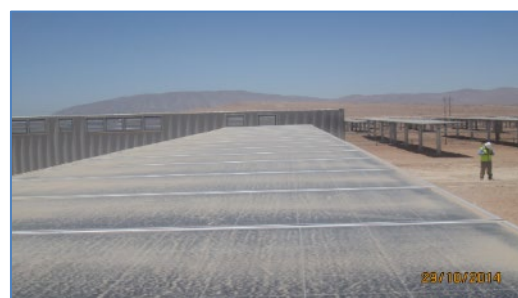
Vista de los módulos instalados
