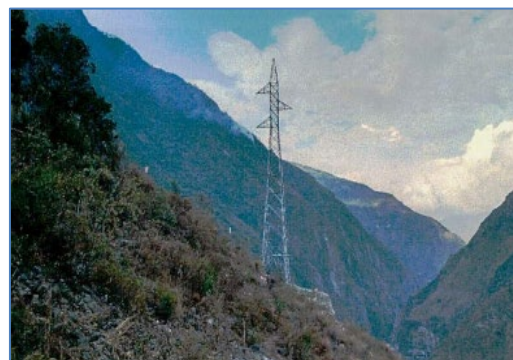
Montaje de Estructura E8 concluido
