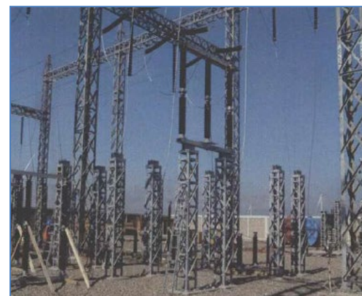
Vista de montaje de polos de seccionador tripolar 220 kV
