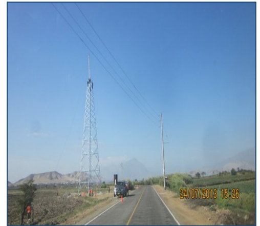
Vista de Montaje de la L.T.
