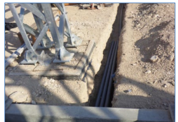
Trabajos en Subestación Marcona
