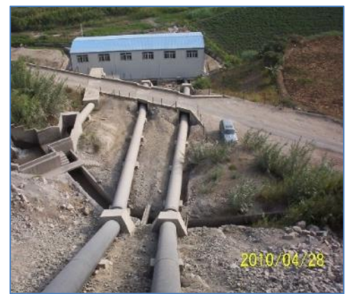
Casa de Máquinas
