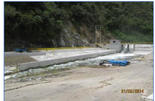
Vista de la Bocatoma
