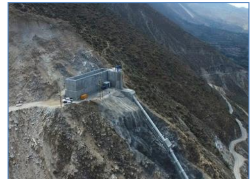
Cámara de carga construida
