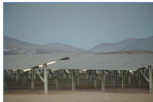
Instalación de Módulos Fotovoltaicos
