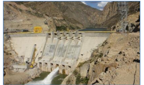
Vista posterior de la Presa
