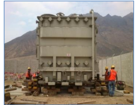
Montaje de Reactor de 40 MVAR (S.E. Trujillo)
