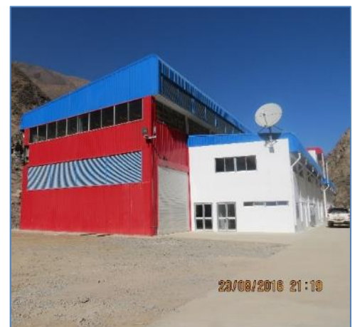
Vista de la Casa de Máquinas
