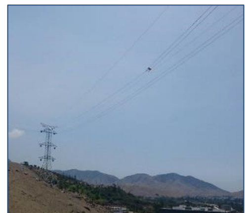
Tendido de conductor
