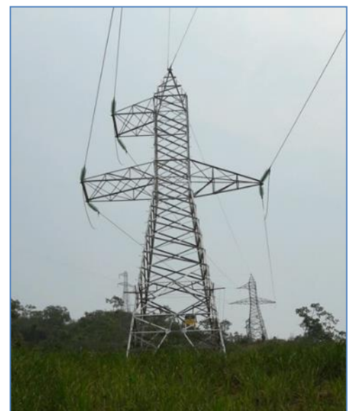
Estructura de salida de S.E. Renovandes H1
