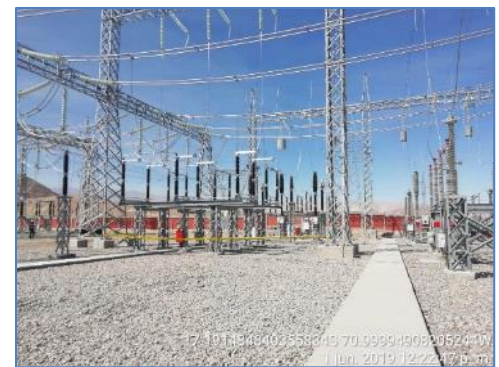
Bahía de salida L.T. 220 kV Montalvo – Los Héroes
