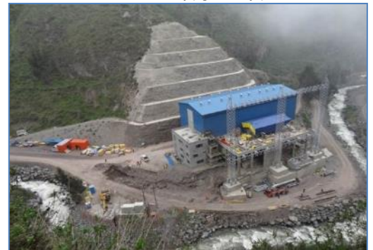
Casa de Máquinas y Subestación
