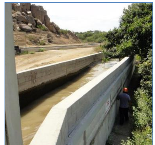
Canal de Derivación hacia la Cámara de Carga
