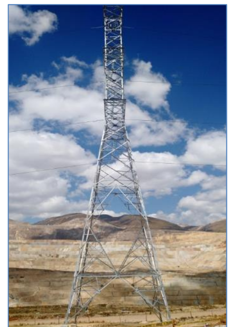
Torre T31N culminada y LT energizada
