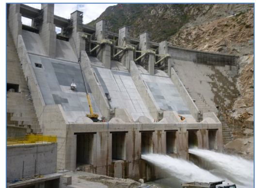
Vista de la Presa
