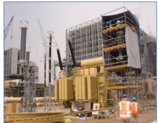
Montaje de Transformador de Potencia de T.G.
