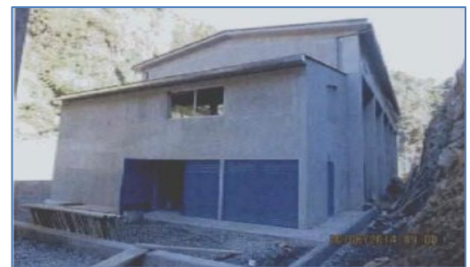
Casa de Máquinas
