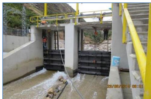
Compuertas del barraje móvil
