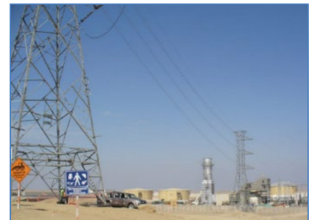
Torre 11 y Torre 4
