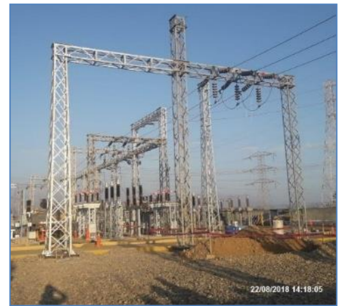
Excavaciones en S.E. Guadalupe
