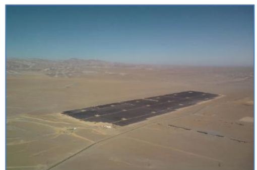
Vista panorámica de la central
