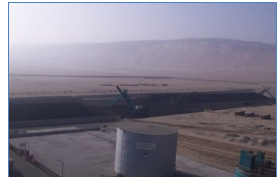
Planta de almacenamiento de agua
