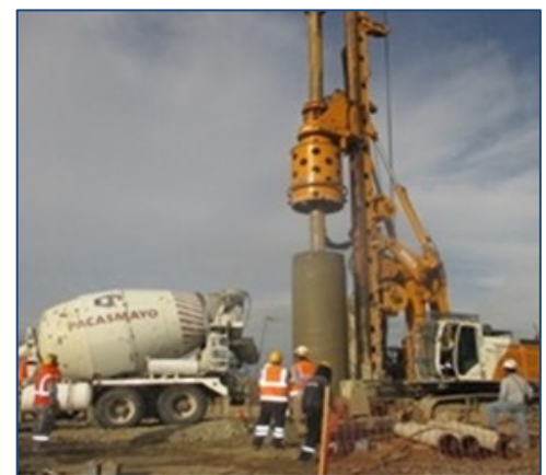
Vaciado de concreto para T08 (Hito d)
