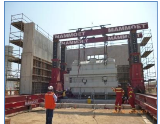
Montaje del Transformador de Potencia Concluido
