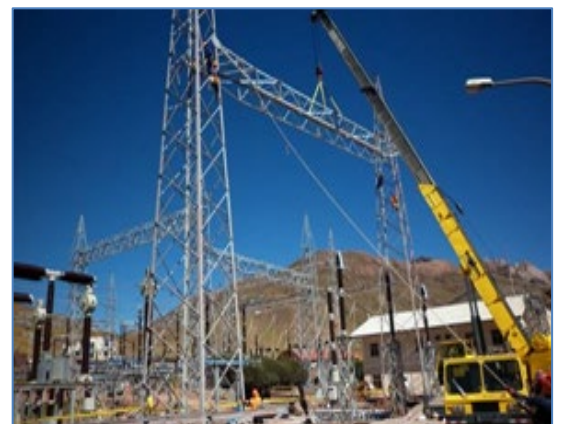
Montaje de una viga en Plataforma I SE Pomacocha
