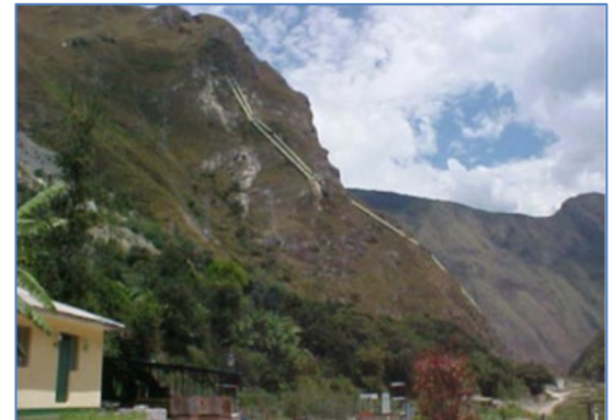
Vista Tubería forzada
