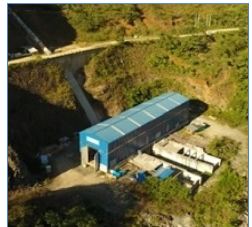
Vista de Tubería Forzada y Casa de Máquinas
