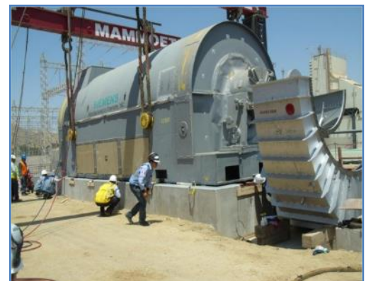
Montaje de Turbina a Gas y Generador
