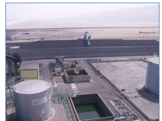
Planta de tratamiento de agua
