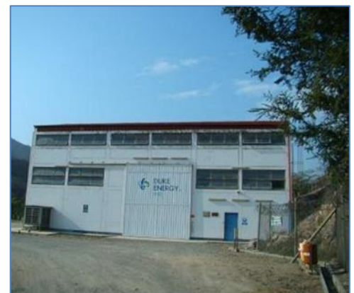
Casa de Máquinas
