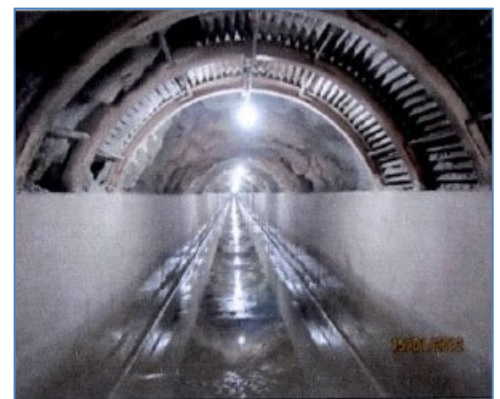
Túnel Huasahuasi I
