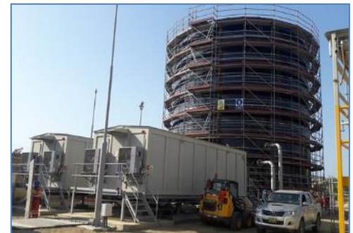
Avance de Obras
