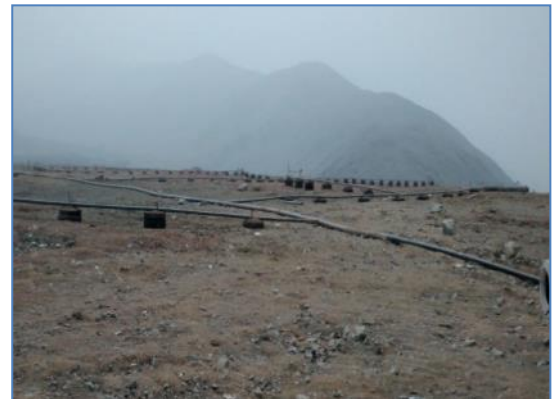
Pozos de extracción de gas
