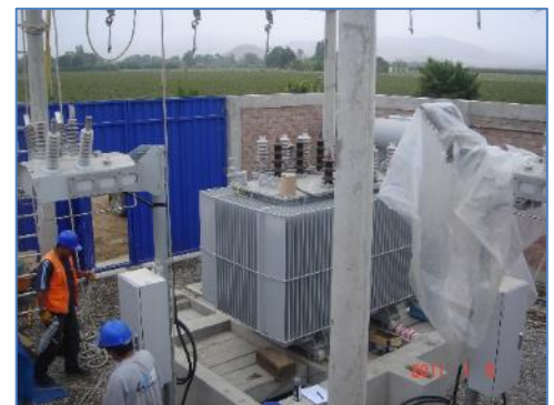
Instalación de Transformador de Potencia
