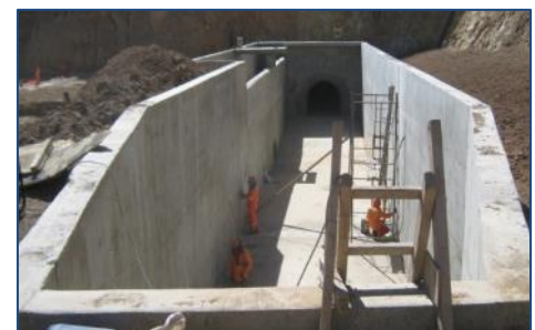
Acabados en la Cámara de Carga
