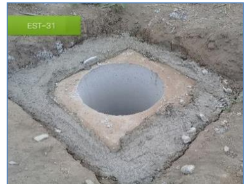
Vertido de concreto de primera fase concluido
