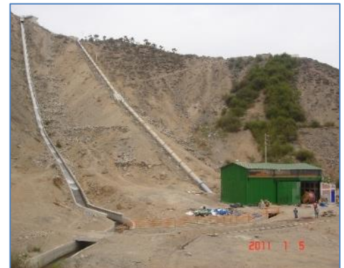
Casa de Máquinas
