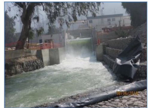
Vertedero del Canal de Descarga
