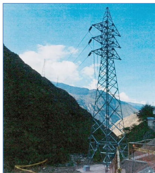
E14, E13 y E12: Montaje de Estructura en proceso
