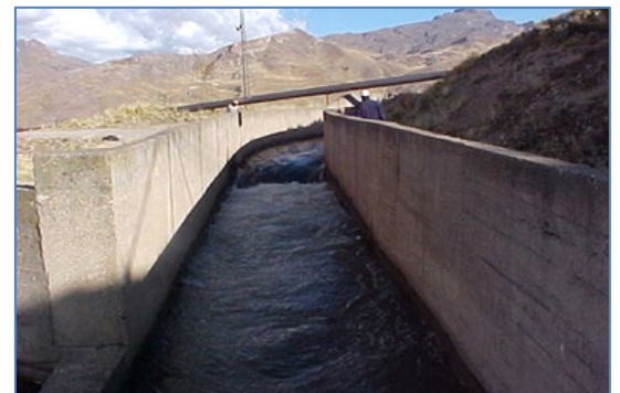
Canal de aducción
