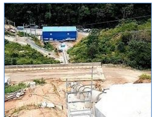
Vista Tubería Forzada y Casa de Máquinas
