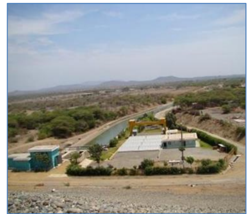
Vista Panorámica de la Central
