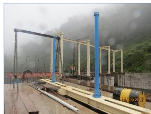
Cilindros de canales 1 y 2
