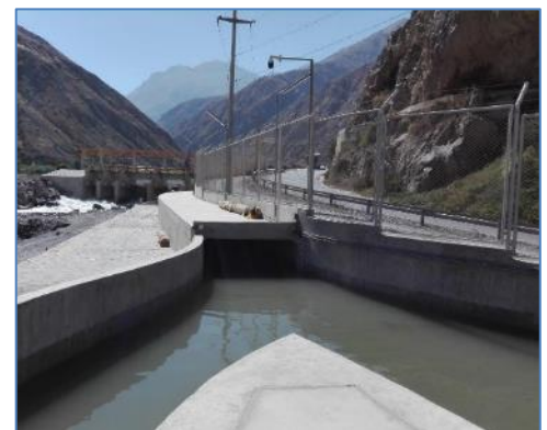
Bocatoma y Canal de Conducción
