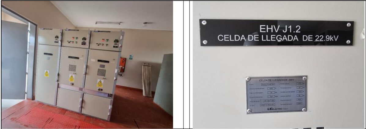
Fotografía N° 2. Celda de Transformador 22.9 kV - SET El Carmen, Electro Dunas
