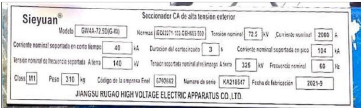
Fotografía N° 3. Placa del Seccionador de Barra Instalado TR4 - SET El Chavarría, Enel DP
