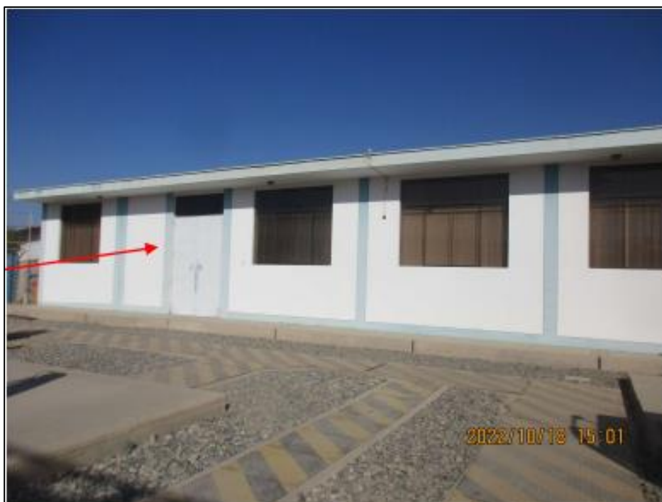
Fotografía N° 2. Sala de Celdas - SET Tacna, ElectroSur
