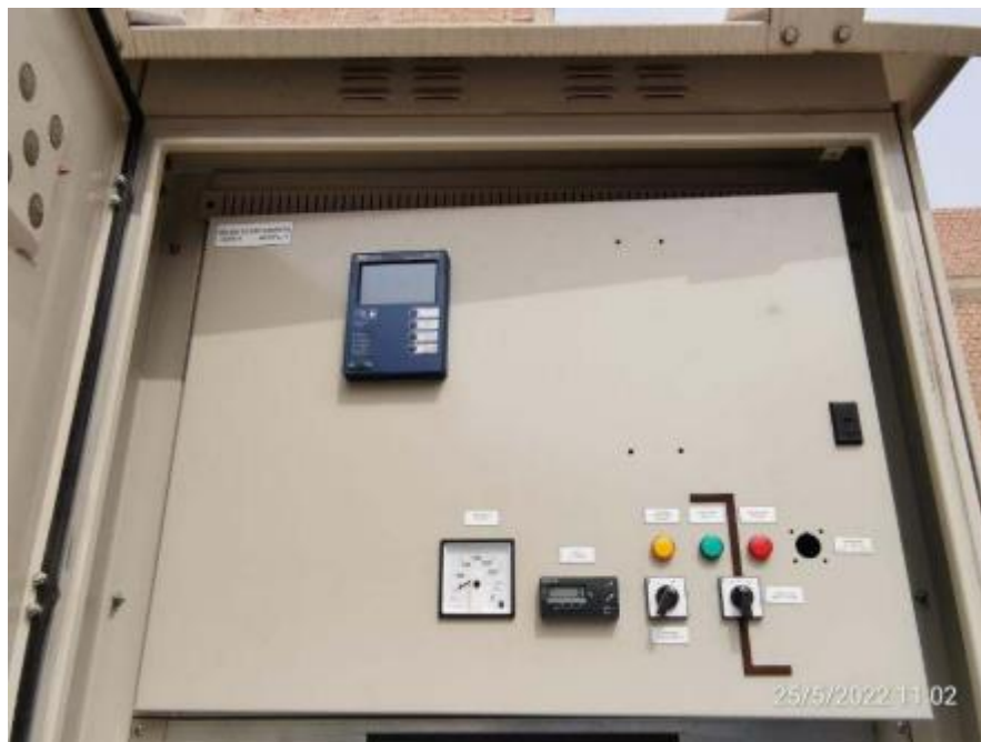
Fotografía N° 10. Vista de los equipos de medición y protección instalados en la celda de acoplamiento en 10 KV SET Filadelfia, Enel DP
