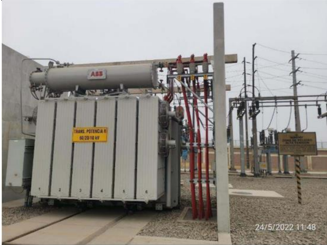
Fotografía N° 2. Vista del Transformador TR2 dado de Baja (Vista Frontal) SET Huaral, Enel DP
