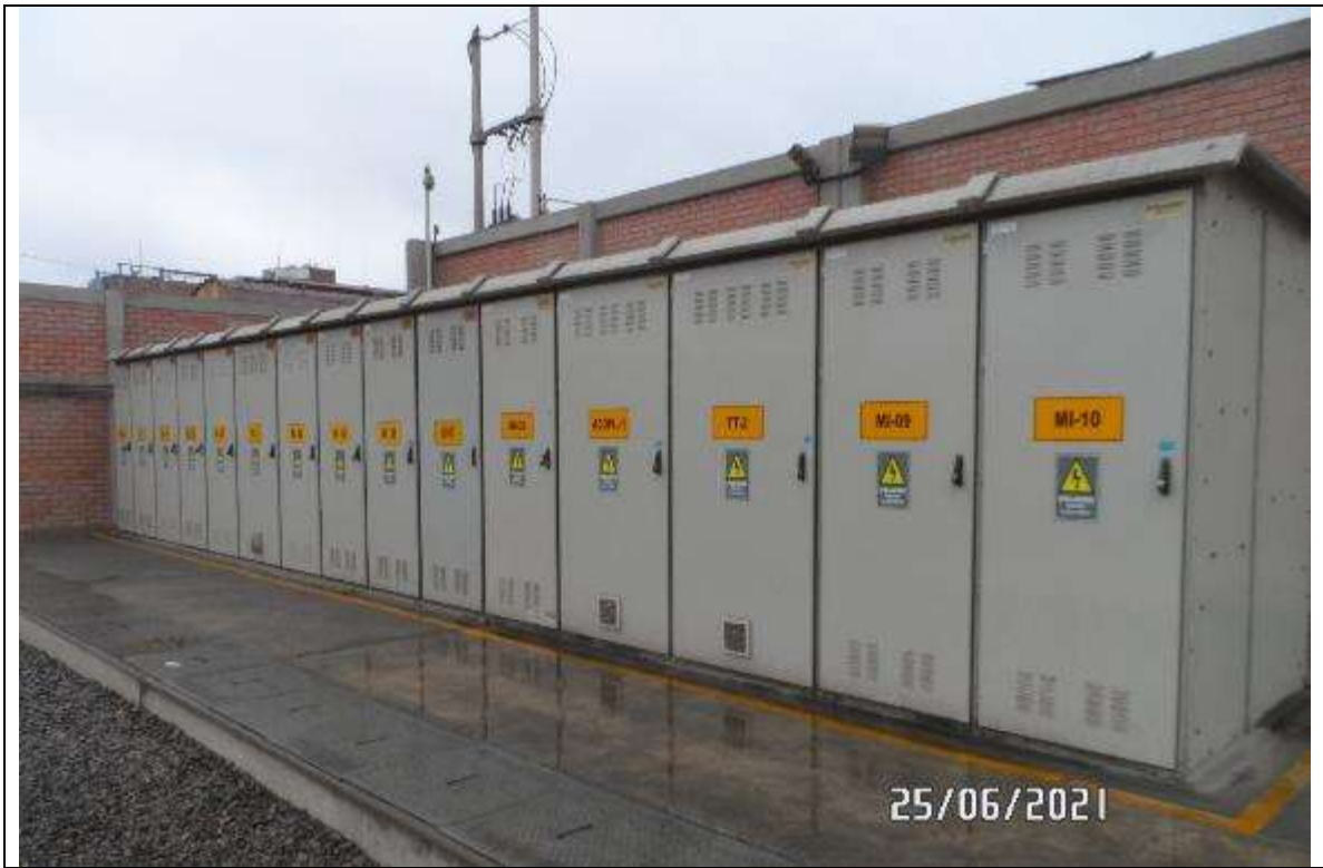
Foto 1. SET Mariátegui. Celdas metal clad 10 kV, instalación exterior, simple barra.
