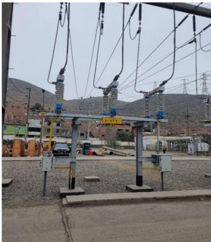
Fotografía N° 2. Seccionador de barra de la celda de línea L-617 SET Chavarria, Enel DP
