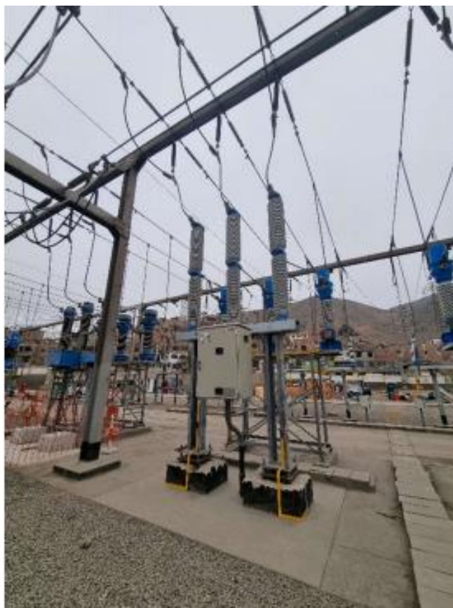
Fotografía N° 4. Base de soporte no concluida de la celda de línea L-617 SET Chavarria, Enel DP
