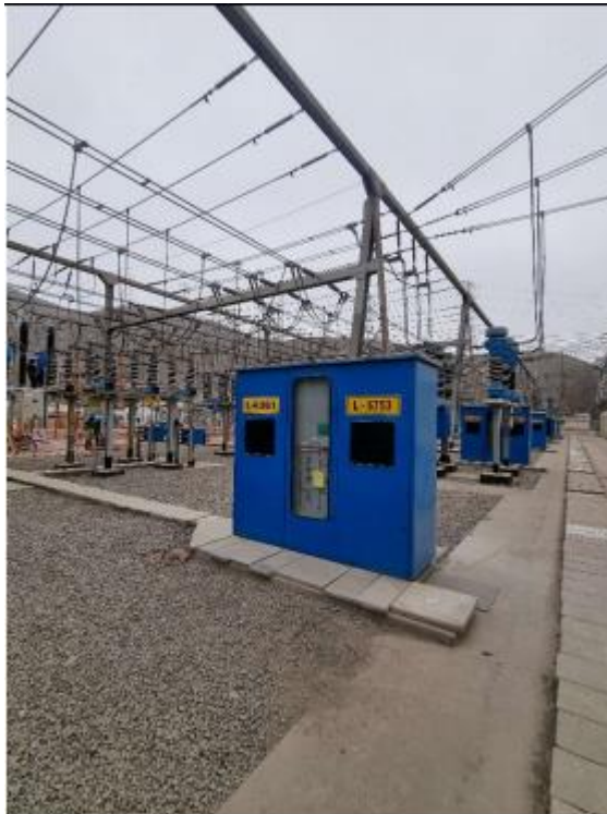
Fotografía N° 8. Gabinete no implementado de la celda de línea L-6361 SET Chavarria, Enel DP
