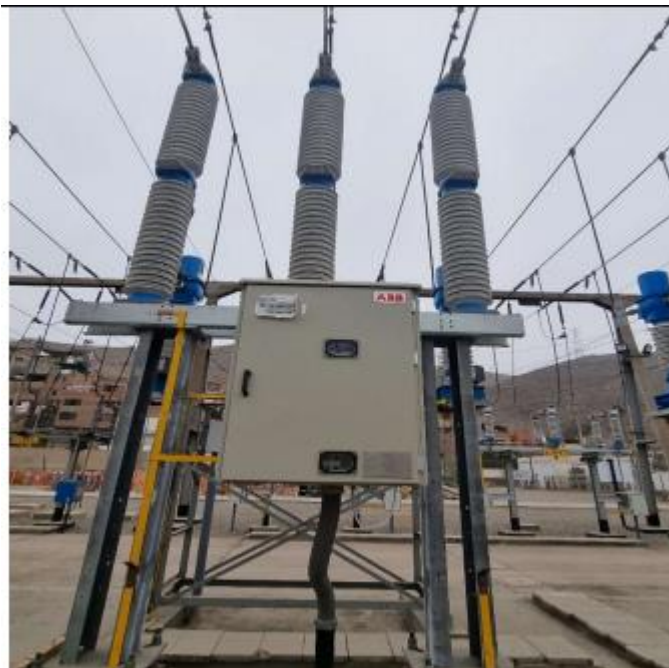
Fotografía N° 2. Seccionador de barra de la celda de línea L-617 SET Chavarria, Enel DP
