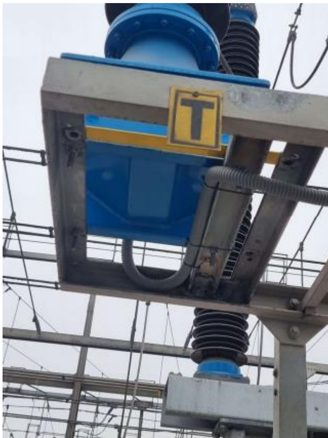
Fotografía N° 8. Gabinete no implementado de la celda de línea L-6361 SET Chavarria, Enel DP
