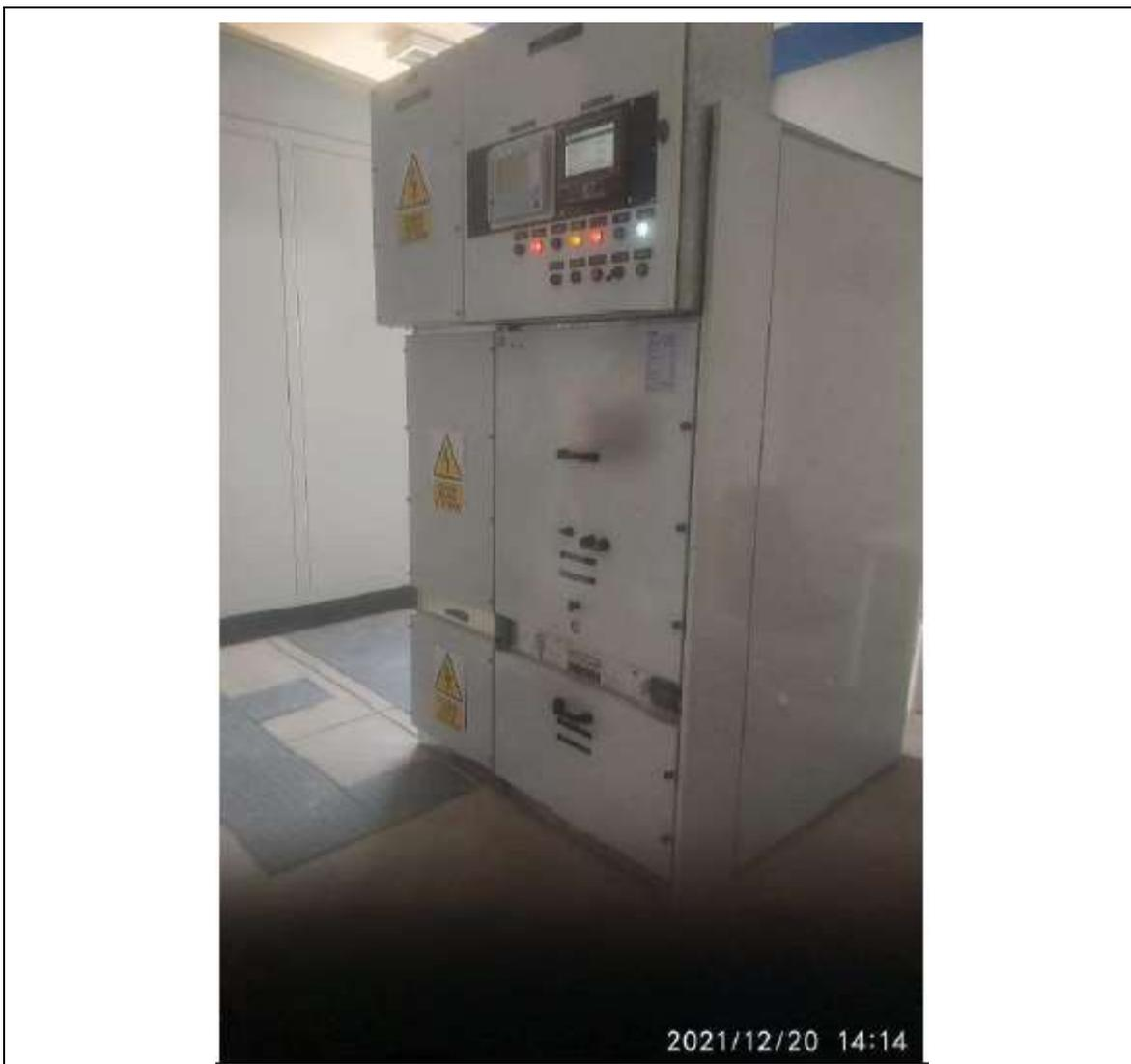
Foto 1. SET Pampa Pañalá. Celda Metal Clad de salida del alimentador ST2-2 en 22,9 kV.
