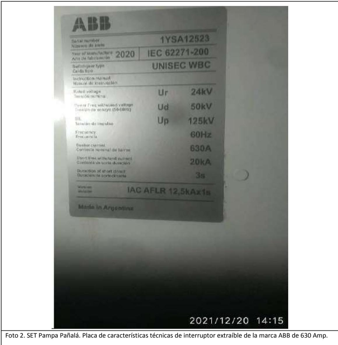
Foto 2. SET Pampa Pañalá. Placa de características técnicas de interruptor extraíble de la marca ABB de 630 Amp.
