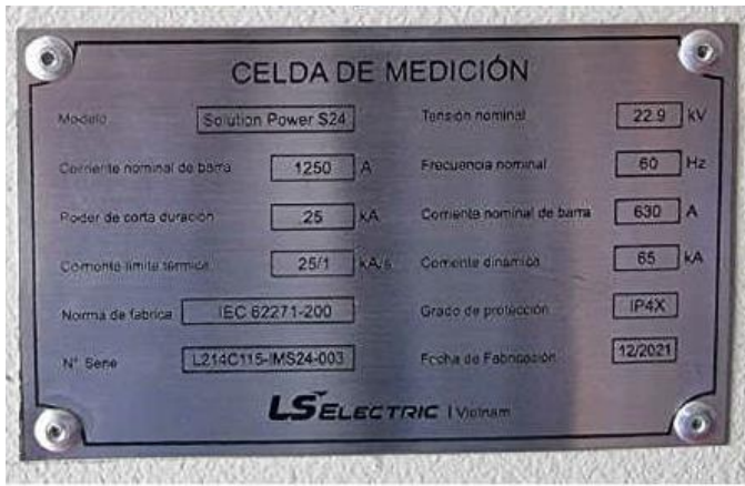
Fotografía N° 6. Celda de Alimentador 22.9 kV, CE-023COMCISBAL - SET El Carmen, Electro Dunas
