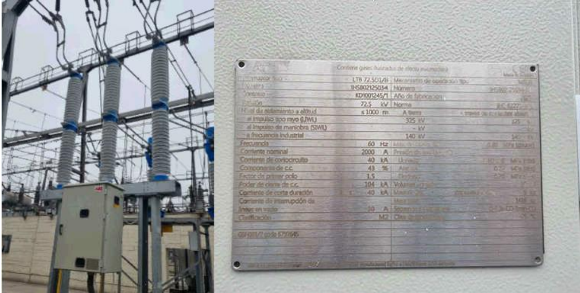
Fotografía N° 2. Seccionador de barra de la celda de TR1 - SET Chavarria, Enel DP
