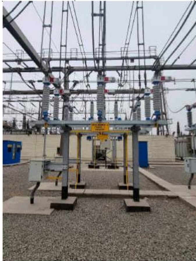
Fotografía N° 2. Seccionador de barra de la celda de TR1 - SET Chavarria, Enel DP
