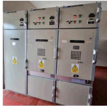
Fotografía N° 6. Celda de Alimentador 22.9 kV, CE-023COMCISBAL - SET El Carmen, Electro Dunas
