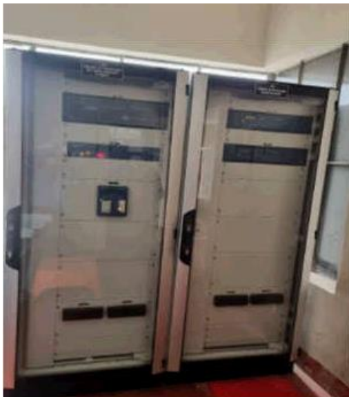
Fotografía N° 7. Módulos de Protección de Celdas 22.9 kV - SET El Carmen, Electro Dunas
