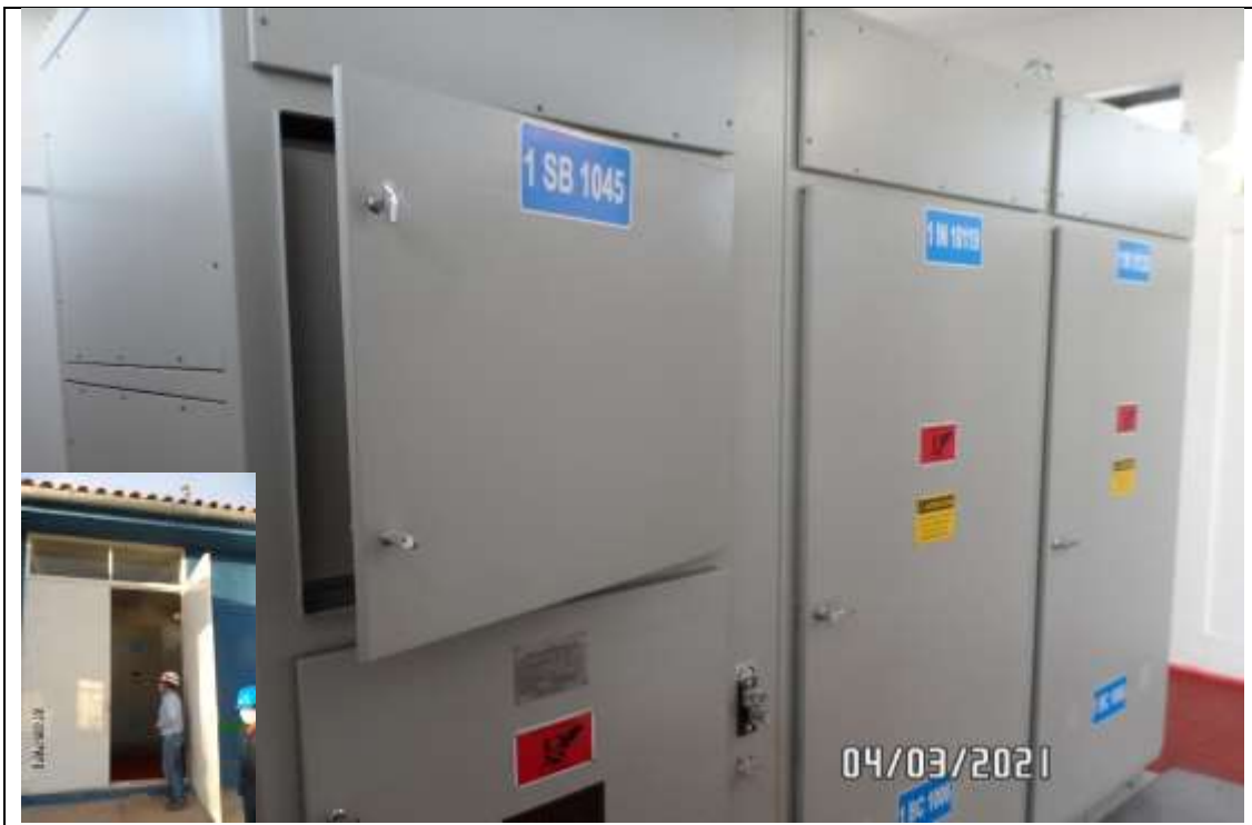
Foto 4. SET ZARUMILLA. Banco de condensadores de 2x6x250 KVAR
