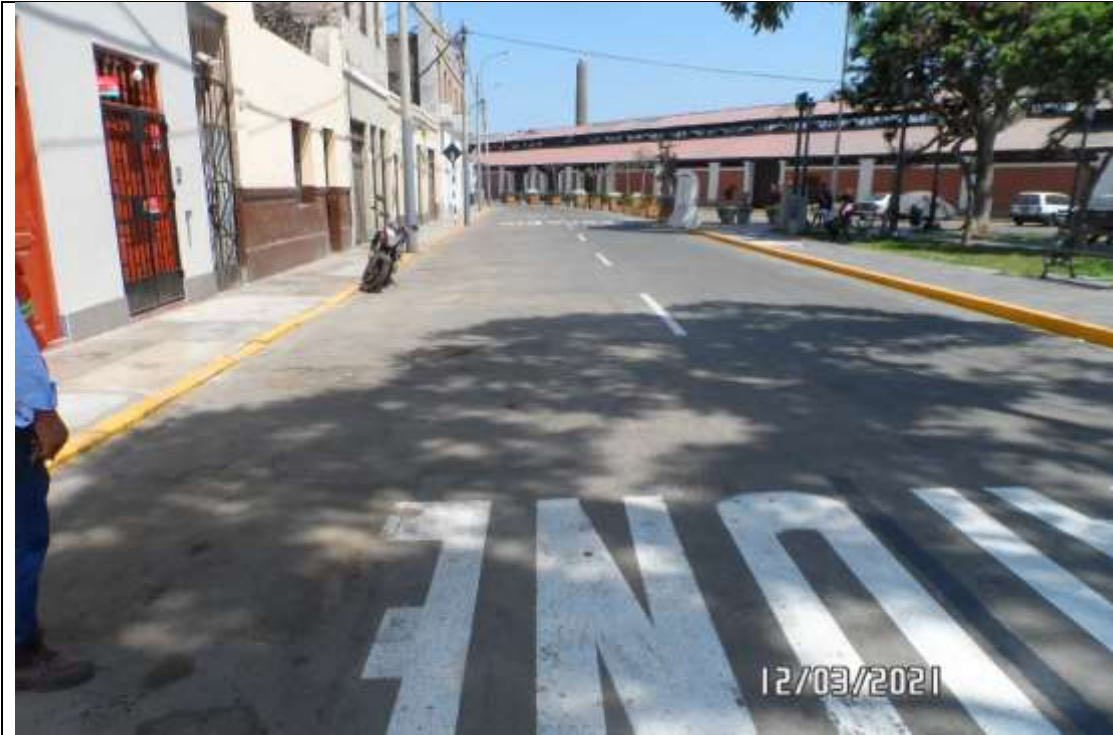
Foto 3. LT 60 kV Malvinas – Tacna, de 3,126 Km. Recorrido por la margen izquierda de Calle Callao. Buzones metálicos cubiertos con capa de pavimento para evitar hurtos.
