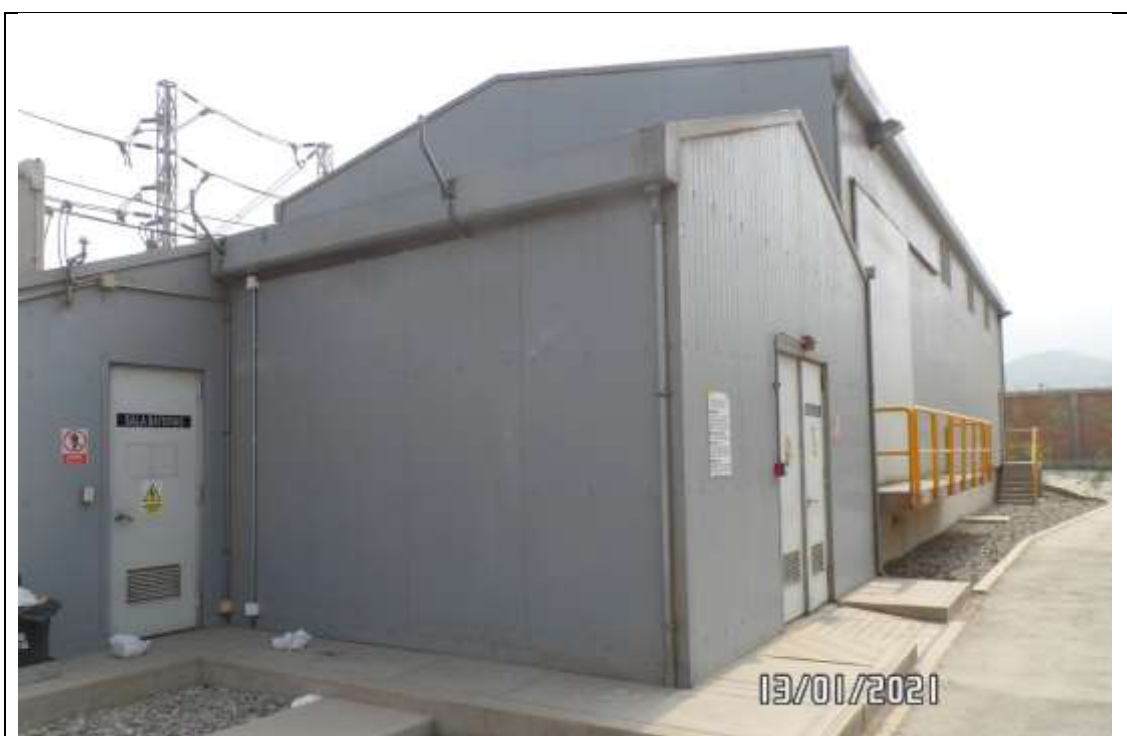
Foto 1. SET MANCHAY. Sala de Celdas (GIS) 220 kV
