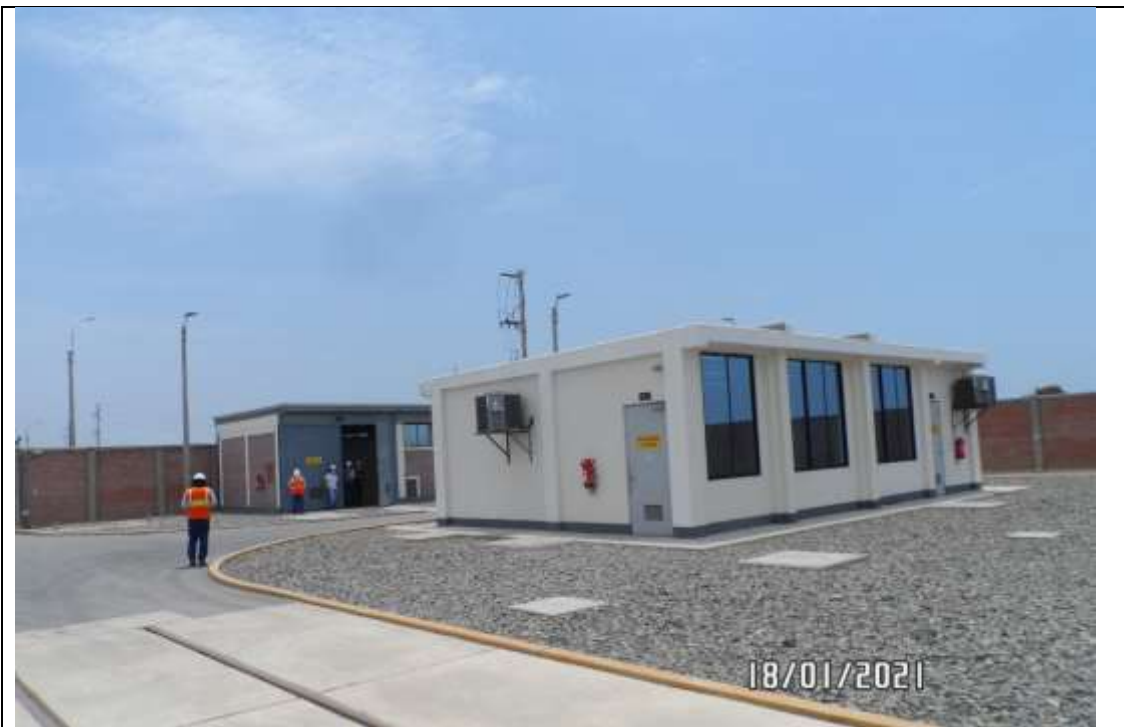
Foto 20. SET MEDIO MUNDO. Sala de control y sala de celdas 22,9 kV.
