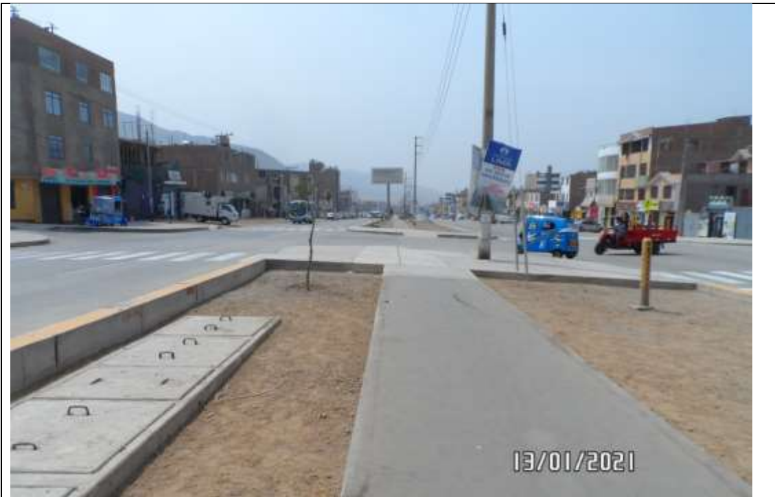
Foto 7. L-2133/L-2134. Cámaras de empalme. Recorrido de la LT por la berma central de Av. Víctor Malásquez.
