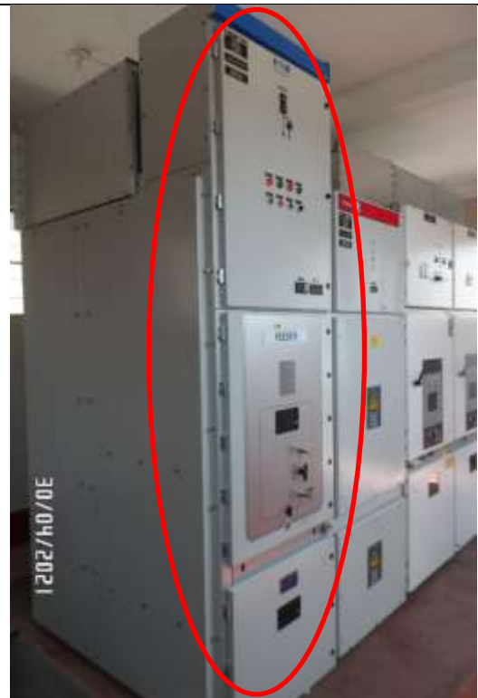
Foto 5. SET PUEBLO NUEVO. Celda metal clad en 23 kV. Código PN 209.
