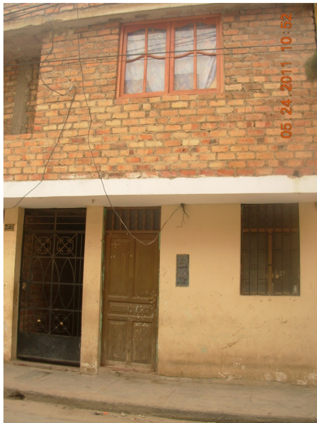
Foto N° 03. Cable de acometida no cumple la distancia de seguridad al nivel del piso. Jr. Amancaes 431. Referencia SUM 45565594.
