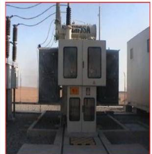
Transformador de Potencia de 20 MW – 23 / 66 kV (S.E. C.S Tacna)
