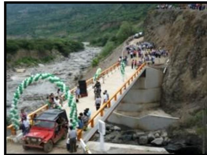
Construcción del puente Huaranchal
