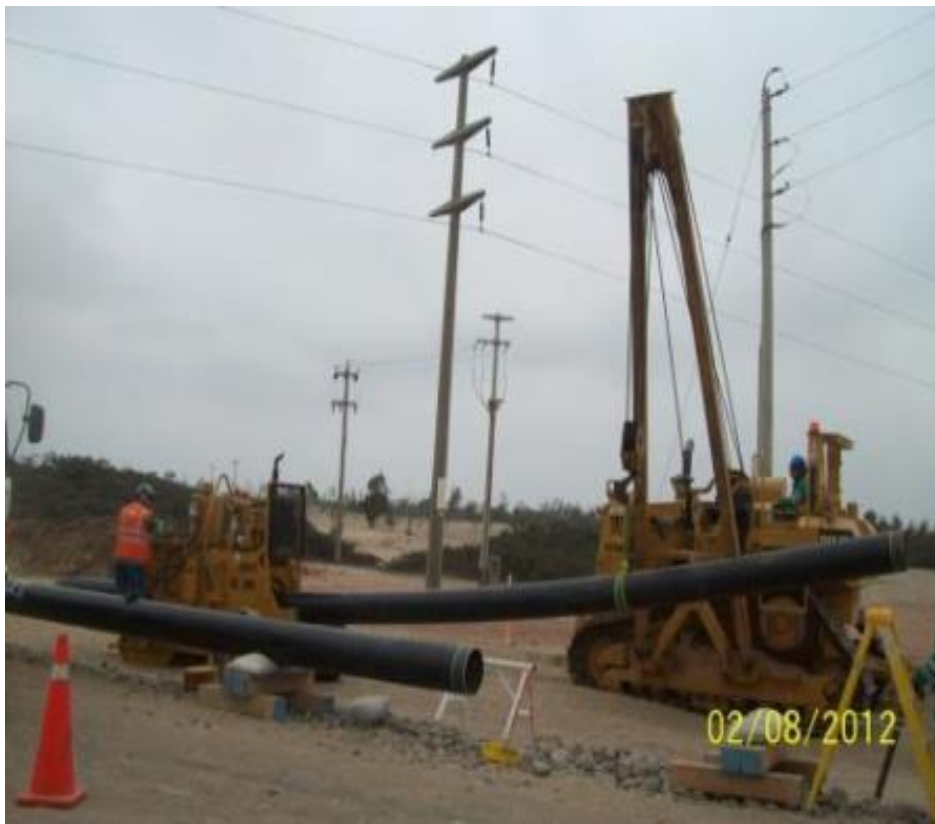
Curvados de tubos.
