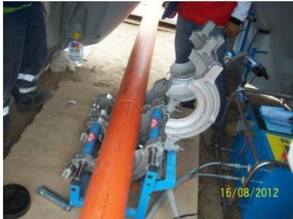
Soldadura por Termo fusión, de tubería \Phi 160 mm .
