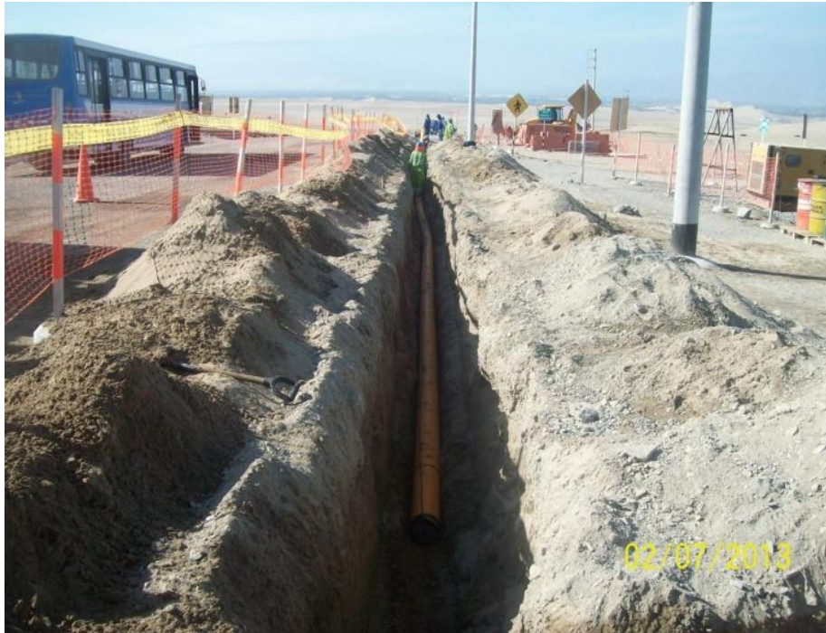
instalando la tubería troncal de PE \varnothing 200 mm. (e=11.9 mm)
