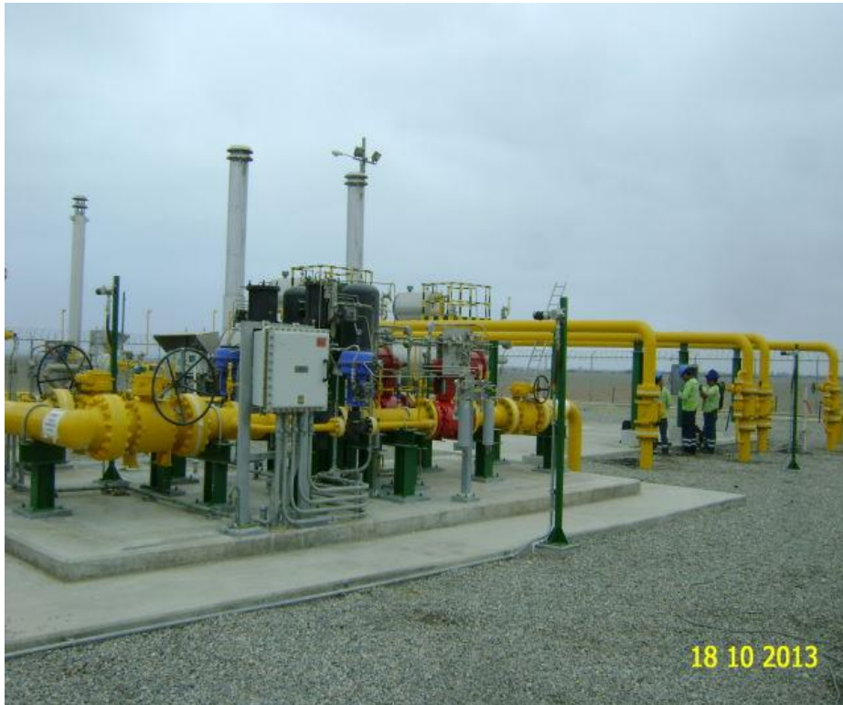
Verificando la instalación de los detectores de gas
