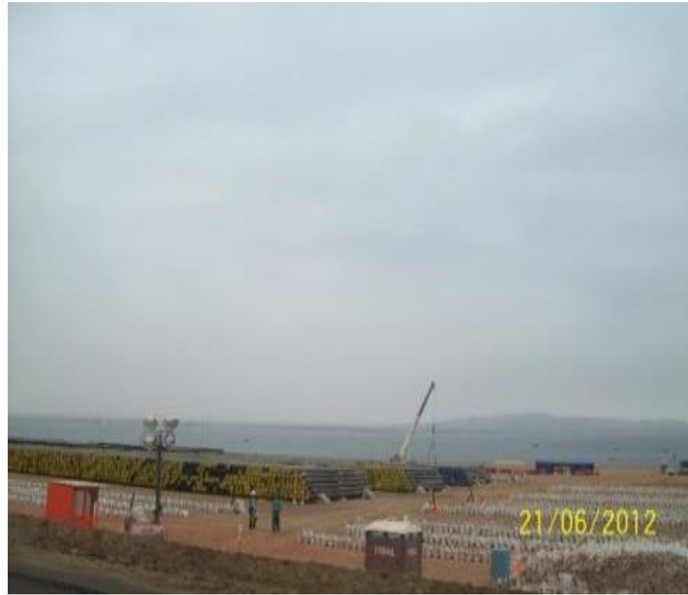
Acopio de tubos de Acero
