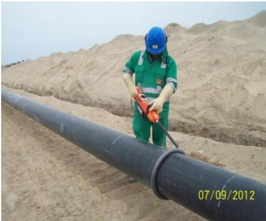
Verificación del revestimiento con el Holliday detector, antes de ser bajada
