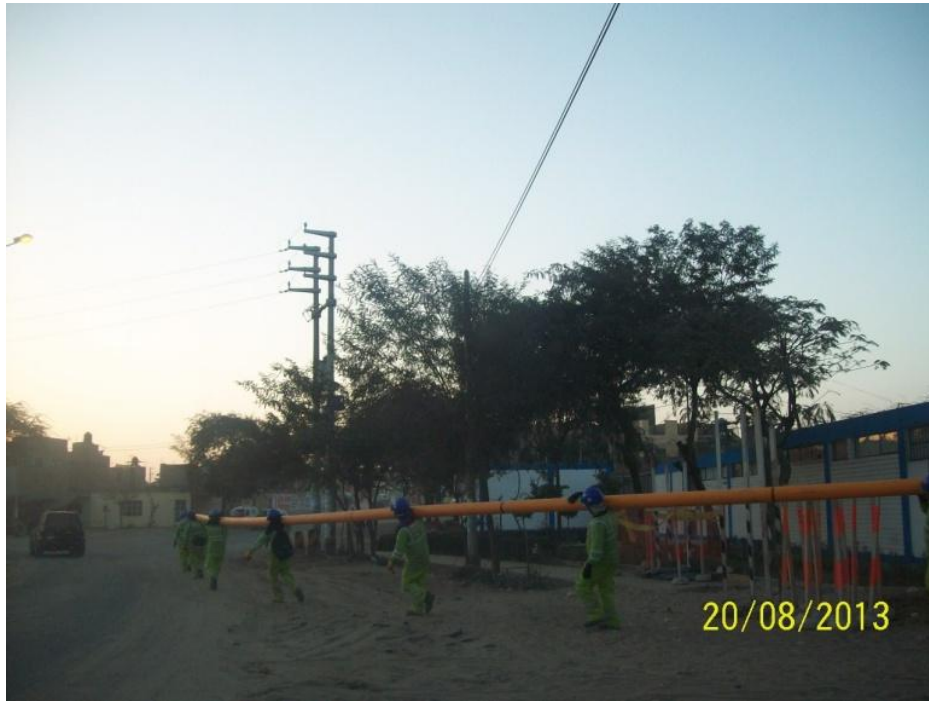
Trasladando un varillón de tubería de PE Ø160 mm.
