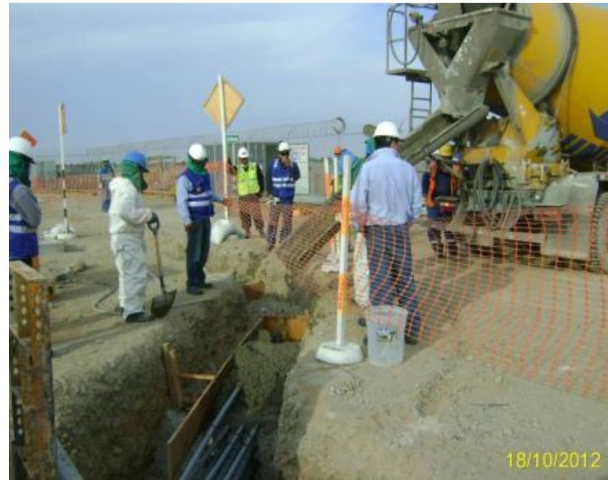
Vaciado de concreto a los banco de ductos
