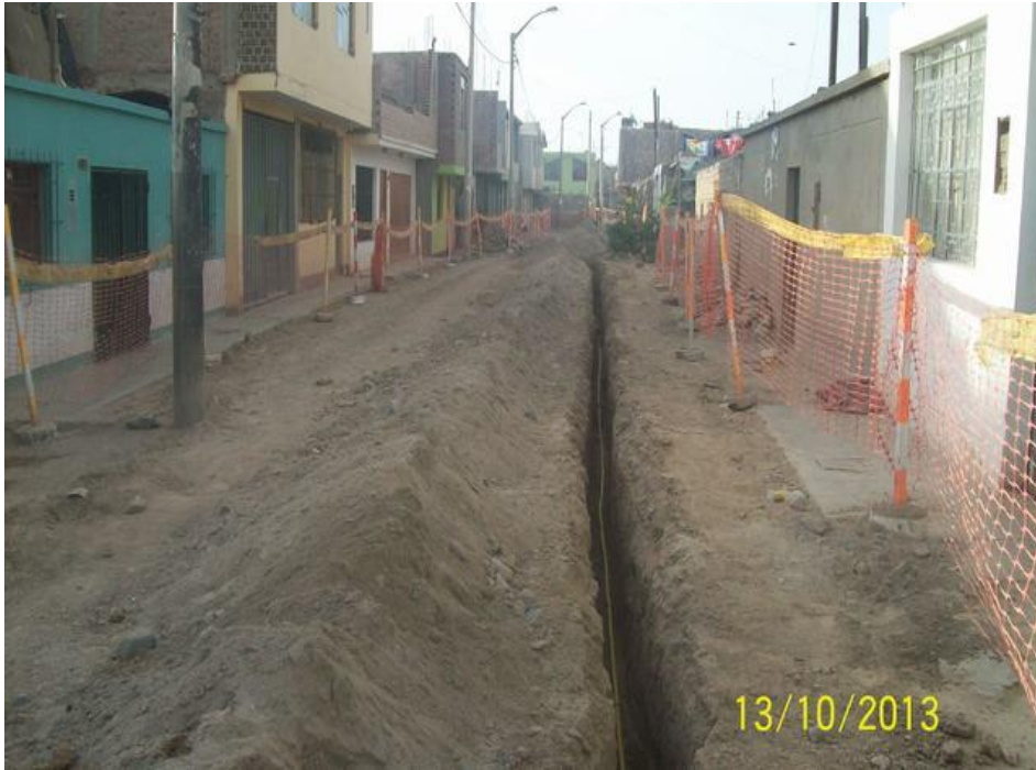
Tubería \varnothing 25 mm instalada en zanja
