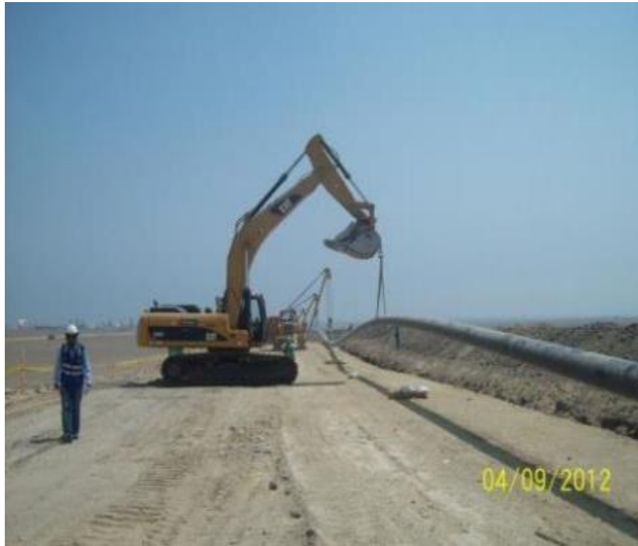
Izamiento de la tubería, para bajarla a la zanja.
