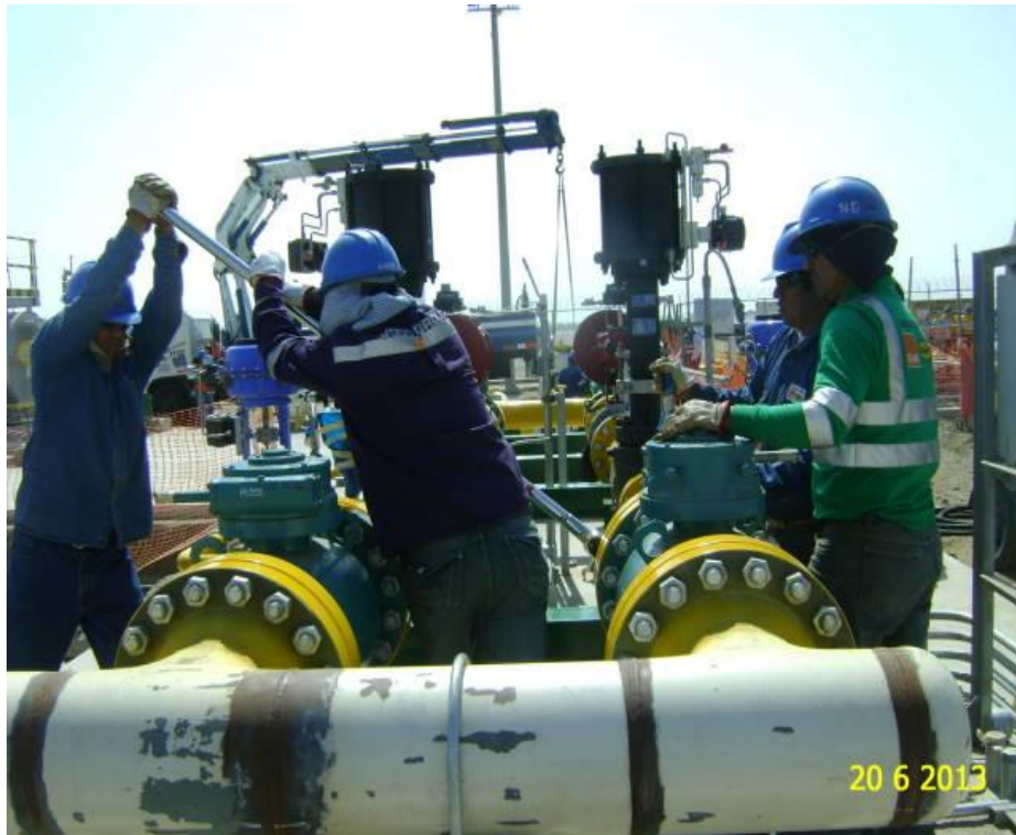
Ajuste de pernos en área de regulación de presión
