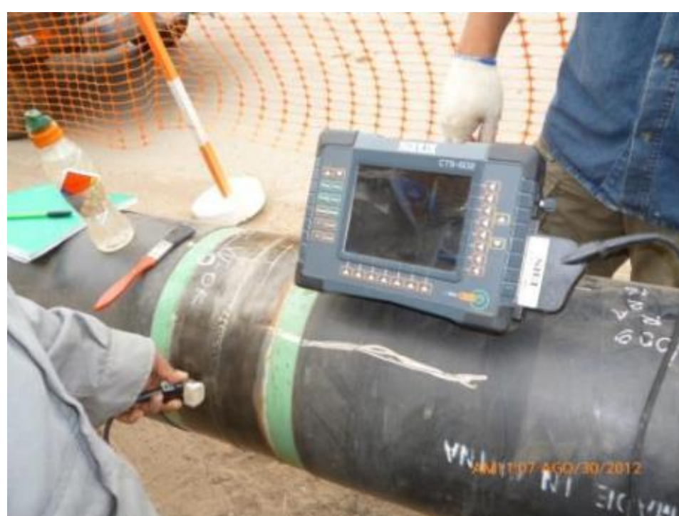
END por Ultrasonido, realizado a la junta soldada del gasoducto.
