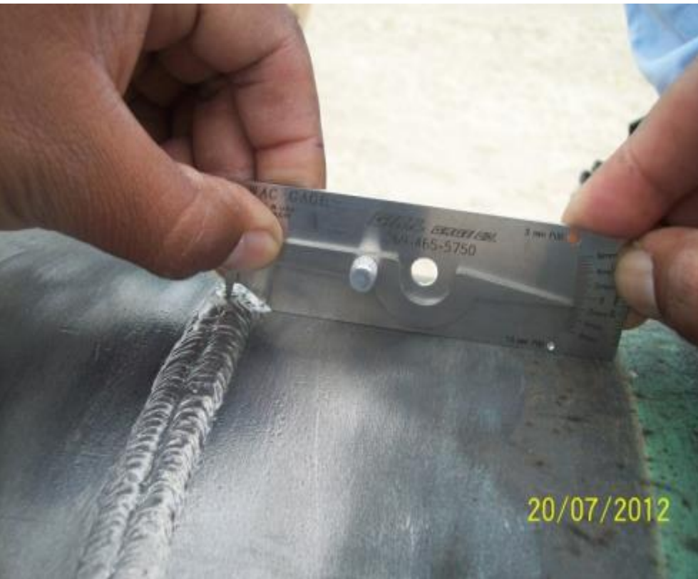
Verificación de la sobremonta de soldadura con el calibrador V WAC-GAGE.
