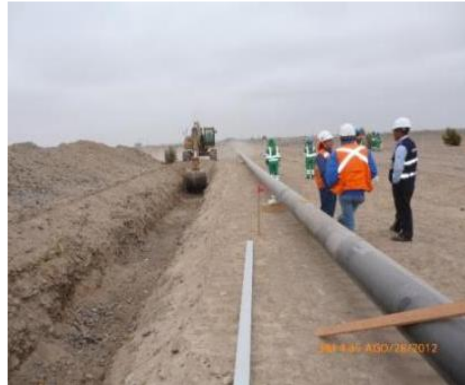
Excavación de zanja.
