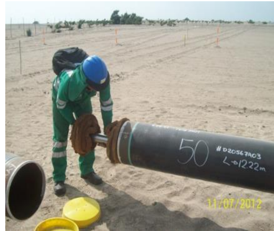
Calibración y limpieza interior de los tubos con plato calibrado al 97.5% del diámetro interior
