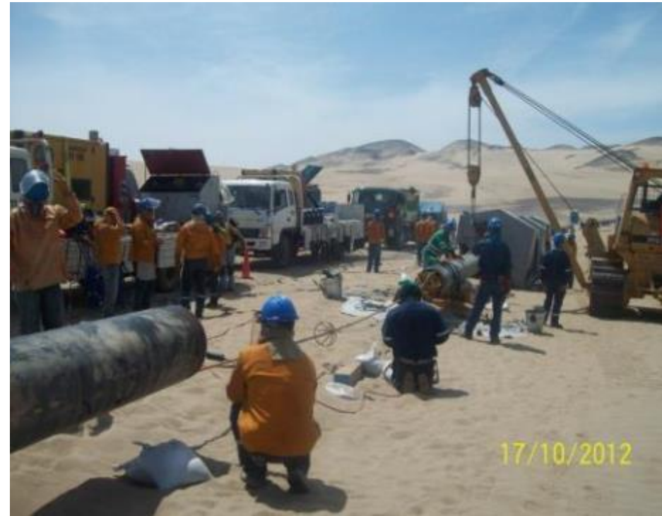
Actividades de soldadura
