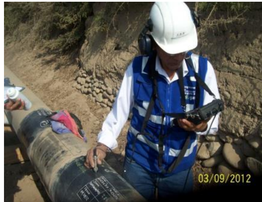
Medición del espesor de pared
