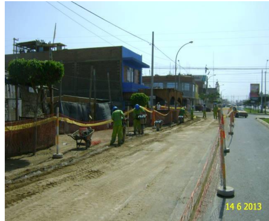
Compactación de suelo en zona donde se instaló tubería de PE.
