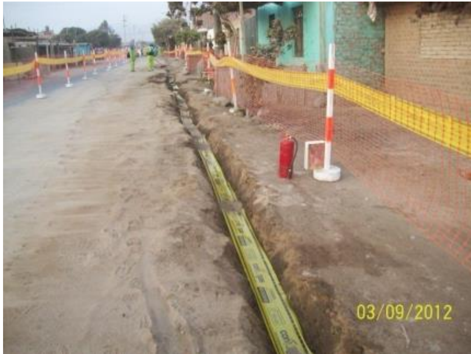
Colocación de cinta de señalización
