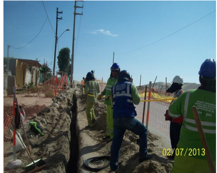
Instalación de la tubería de PE \varnothing 25 mm.
