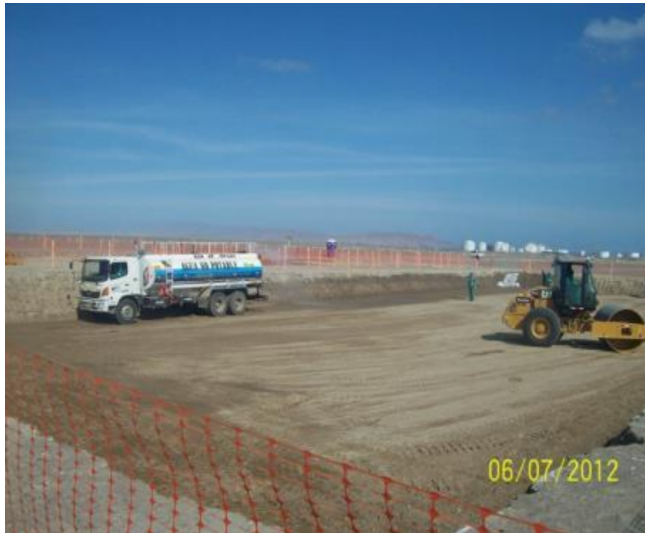
Compactación de la 3ra capa a efectos de mejorar la capacidad portante del terreno
