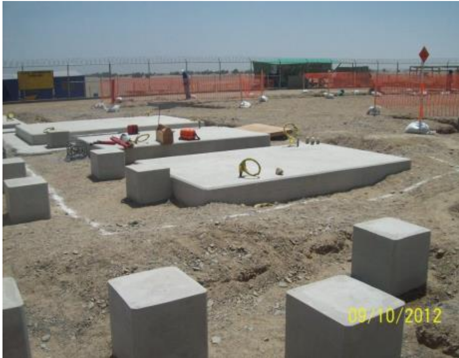
Losas de concreto (terminadas) para Cimentación de equipos a Instalarse
