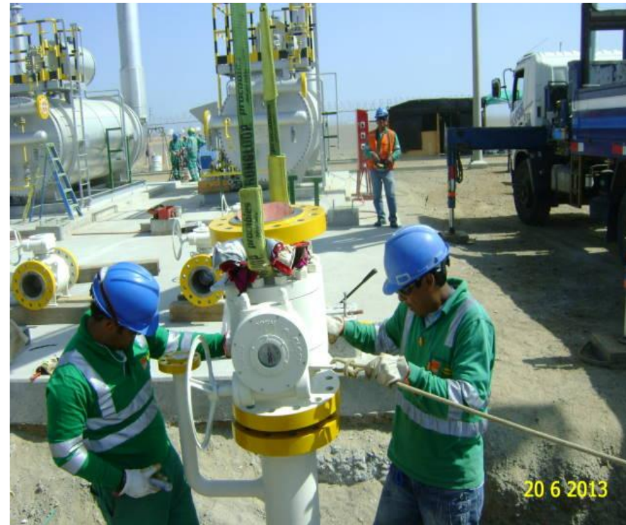
Instalación de válvula en tubería de ingreso a calentador
