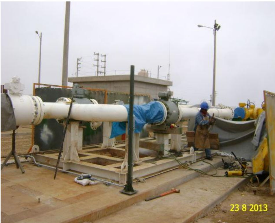
Soldadura en base metálica de trampa de envío
