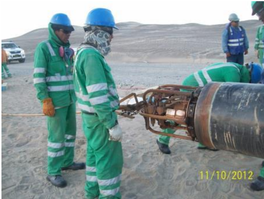
Alineamiento de los tubos con un “Clamp interno”
