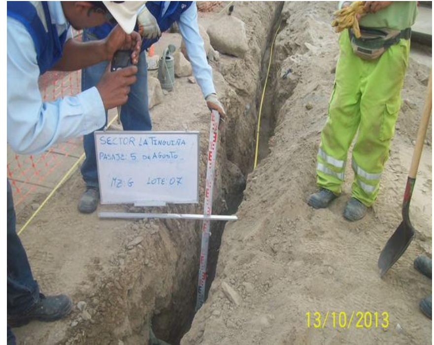
Verificación de la tapada de la tubería \varnothing 25 mm
