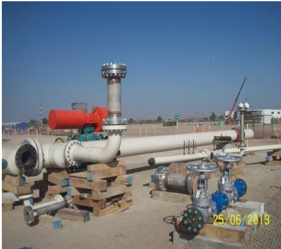
Vista del armado de prefabricados de tubería
