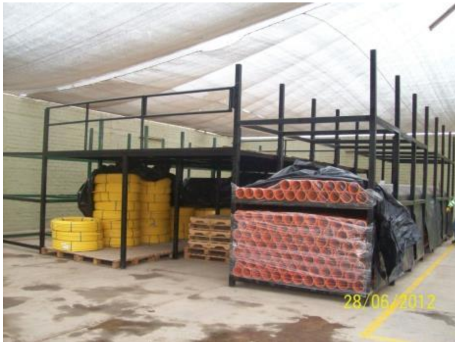
Almacenamiento de tuberías de PE.
