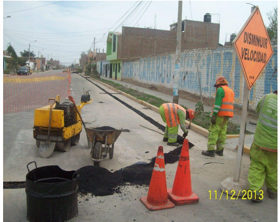
Reposición de la carpeta asfáltica
