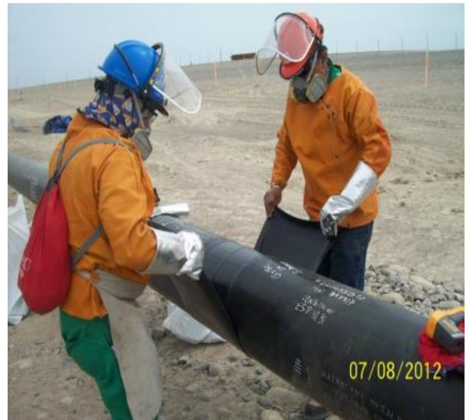
Instalación de manta termocontraíble (CANUSA GTS 65 QA 12B-870)
