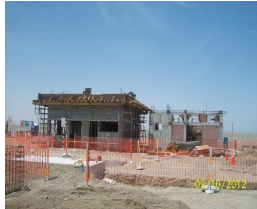
Actividades de albañilería en la sala de control, sala eléctrica y generador de gas
