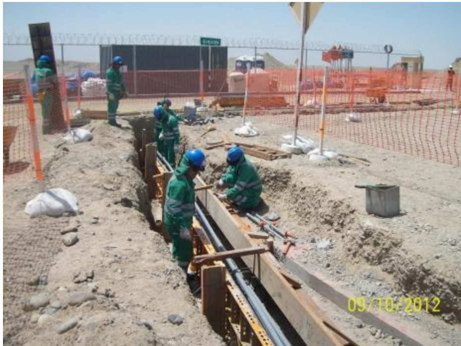
Instalación de banco de ductos
