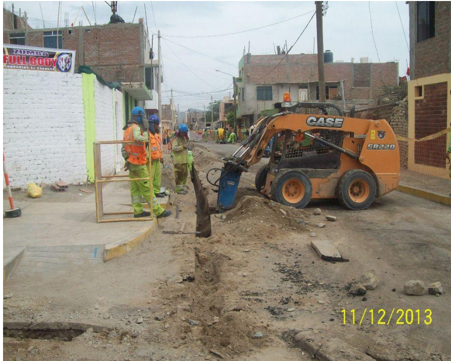
Instalación de redes de PE
