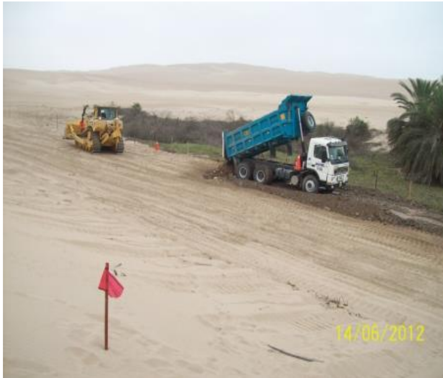
Preparación del DDV (con material afirmado)
