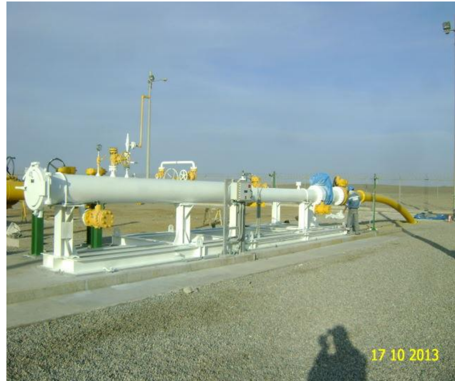
Pintura de acabado en trampa de recibo
