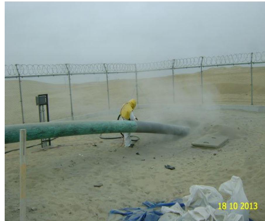
Retirando el revestimiento de la tubería para luego ser pintada (PK 20+650).
