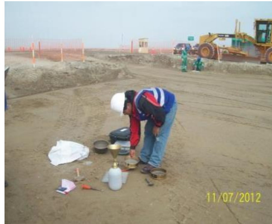
Prueba de ensayo de compactación de la 5ta capa, a efectos determinar la buena compactación (prueba del Proctor Modificado)
