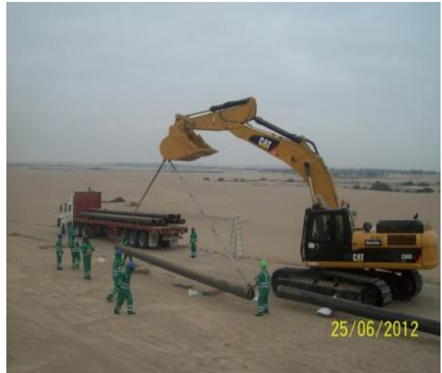
Transporte y descarga de tubos en el DDV
