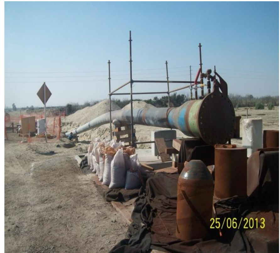
Limpieza con Foam-Pigs y Poly-Pigs del tramo de línea
