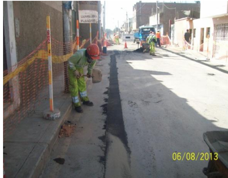
Reposición del asfaltado.
