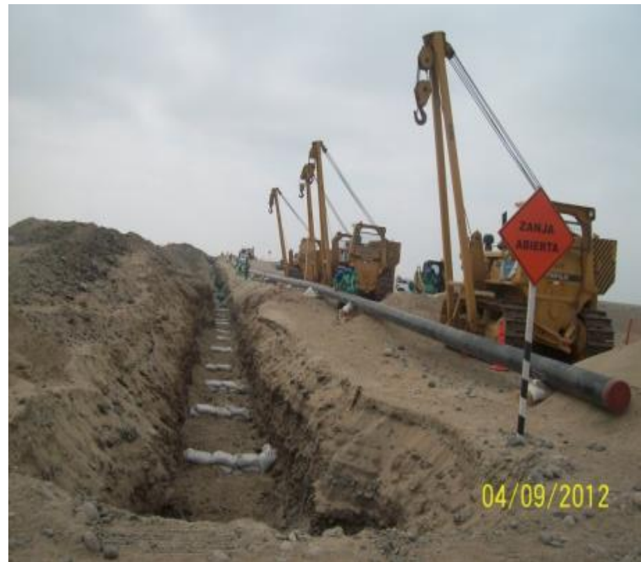
Zanja acondicionada para bajar el varillón \Phi 14'' .
