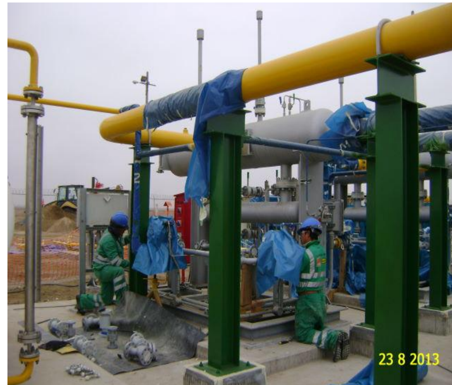
Instalación de válvulas pintadas en los filtros separadores
