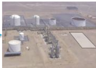
Planta Pisco Fraccionamiento de LGN
