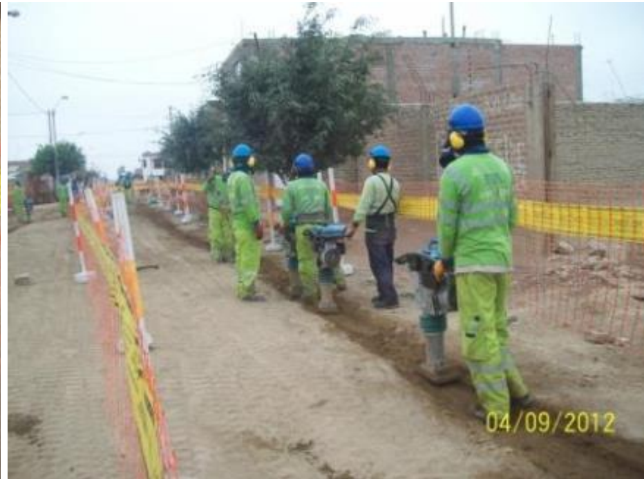
Compactación del terreno.
