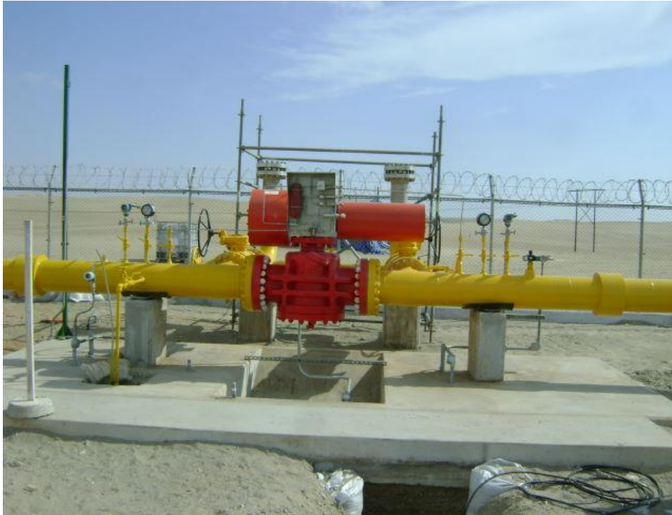
Válvula de seccionamiento (PK 20+650).
