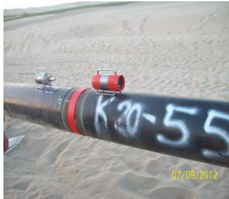
END al gasoducto, usando equipos crawlers de radiografía Industrial
