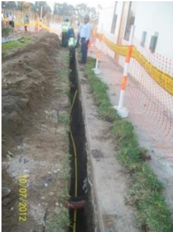
Zanjado y tendido de tubería de \varnothing 25 mm
