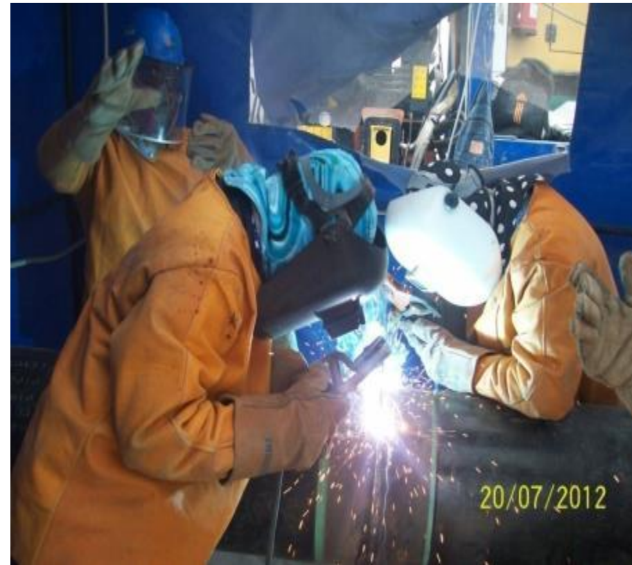
Soldadura de juntas
