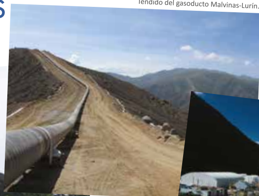
Tendido del gasoducto Malvinas-Lurín.
