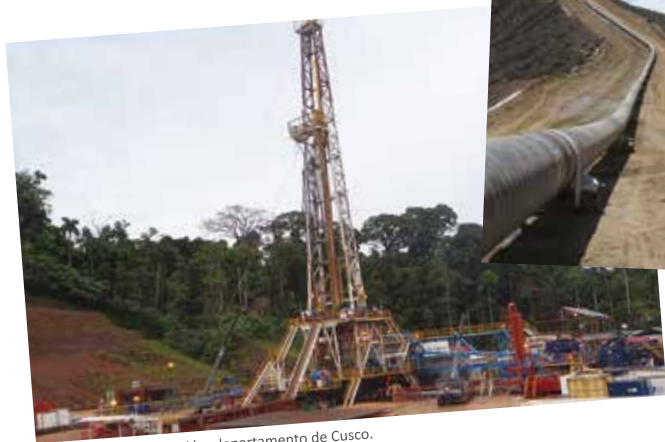
Plataforma de perforación, departamento de Cusco.
