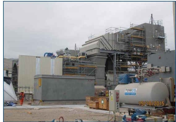
Turbogenerador N° 3 en proceso de montaje - CT. Puerto Bravo (Mollendo)
