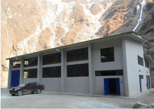
Casa de Máquinas
