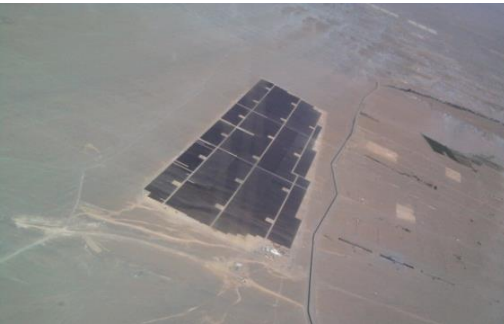
Vista aérea de paneles fotovoltaicos
