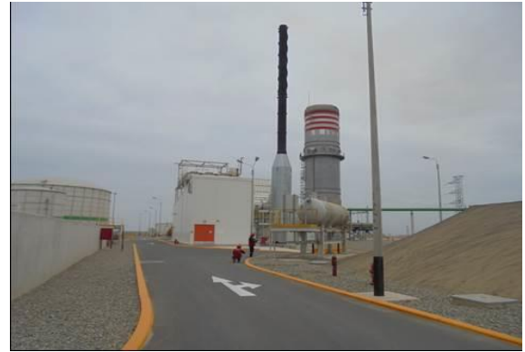
Central Térmica Reserva Fría ETEN
