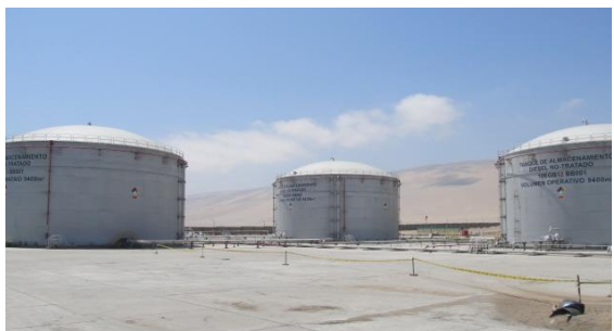
Tanques de combustible
