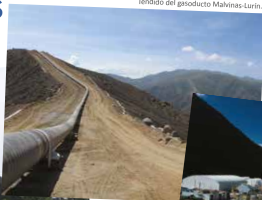
Tendido del gasoducto Malvinas-Lurín.
