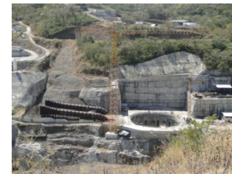
Central Hidroeléctrica El Chaparral 66 MW (2018)
