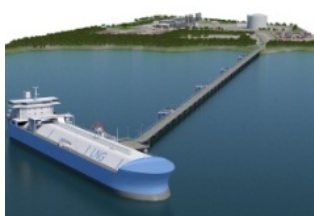
Planta de Generación Térmica de 380 MW de capacidad instalada a base de GNL, un muelle dedicado para la recepción de buques transportadores de GNL y una Planta de Regasificación (2019).
