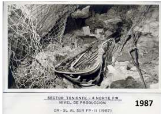
Estallido de roca en la Mina Teniente (Caimaque, 2019)
