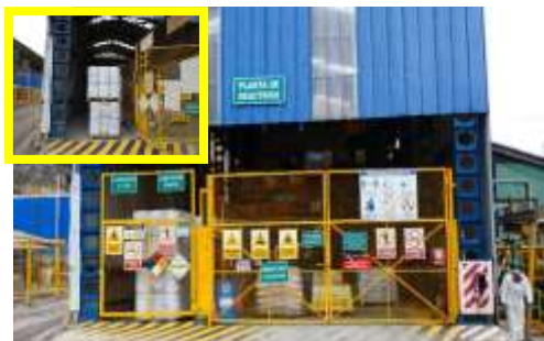
El cianuro de sodio no cuenta con almacén propio, en U. Casapalca, se encuentra almacenado dentro de la sala de preparación de reactivos, en un área reducida, en cilindros de 50 Kg, apilado hasta cuatro (04) unidades. Osinergmin
