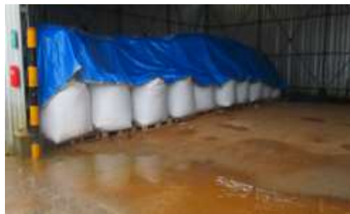
La cal se encuentra almacenada en un depósito con charcos de agua al ingreso del depósito, así como por goteras del techo con agujeros, generando condición de riesgo, U. La Arena. Fuente: Osinergmin
