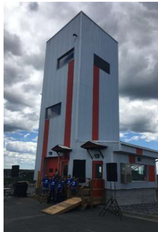
Demostración HAC instalado en un antiguo hueco de ascensor en Dynamic Earth de Science North en Sudbury-Canadá. Fuente: CEMI
