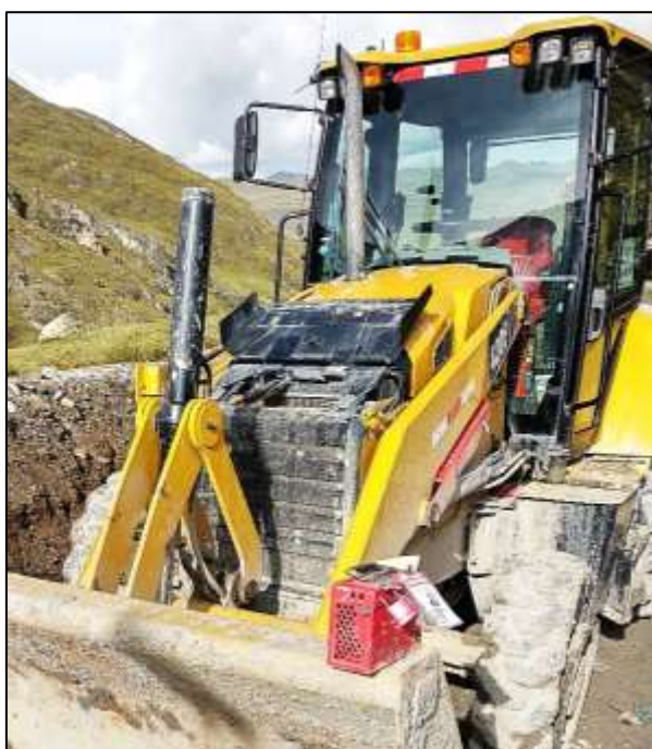
Cargador frontal cuya cabina cuenta con sistema de protección contra vuelco (ROPS) de fábrica. Fuente: Osinergmin
